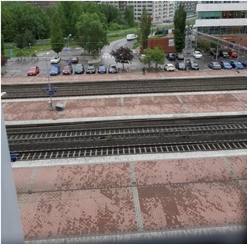
Kuva 8. Ratapihan aluetta suunnittelualueen kohdalla (lähde: Vantaan raitiotie, rakennettavuusselvitys, Ratakujan tunneli Afry Finland 19.4.2021)
