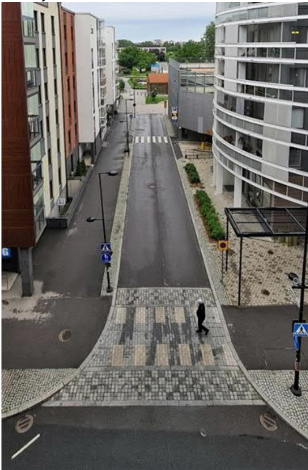
Kuva 1. Suunnittelualueetta Ratakujan kohdalla kesäkuussa 2020 kauppakeskus DIXI:n suunnasta kuvattuna (lähde: Vantaan raitiotie, rakennettavuusselvitys, Ratakujan tunneli Afry Finland 19.4.2021)
