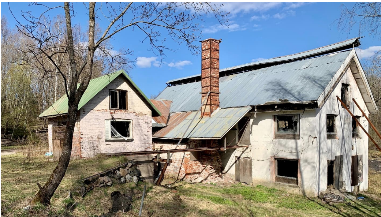
Mylly ei kerro vain historiasta vaan myös tulevaisuudesta. Mylly etelästä. Kiviseinät säilyvät, myllyä korotetaan, keskiosa puretaan, piippu uusitaan. Mylly saa uuden elämän. TKa 2.5.2021
