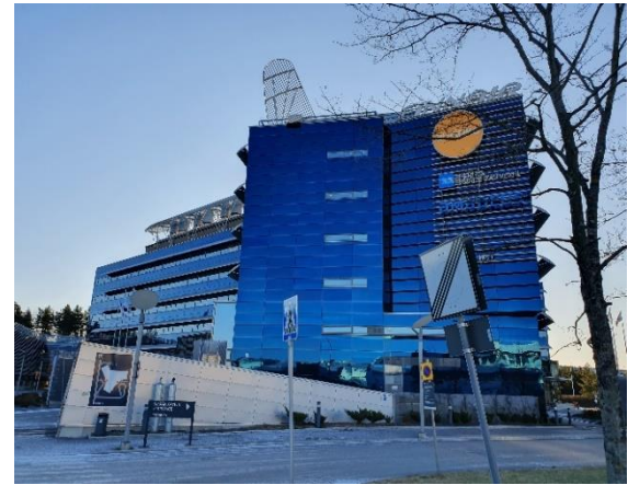
Tietotie 9:n metallijulkisivu on näyttävä.
