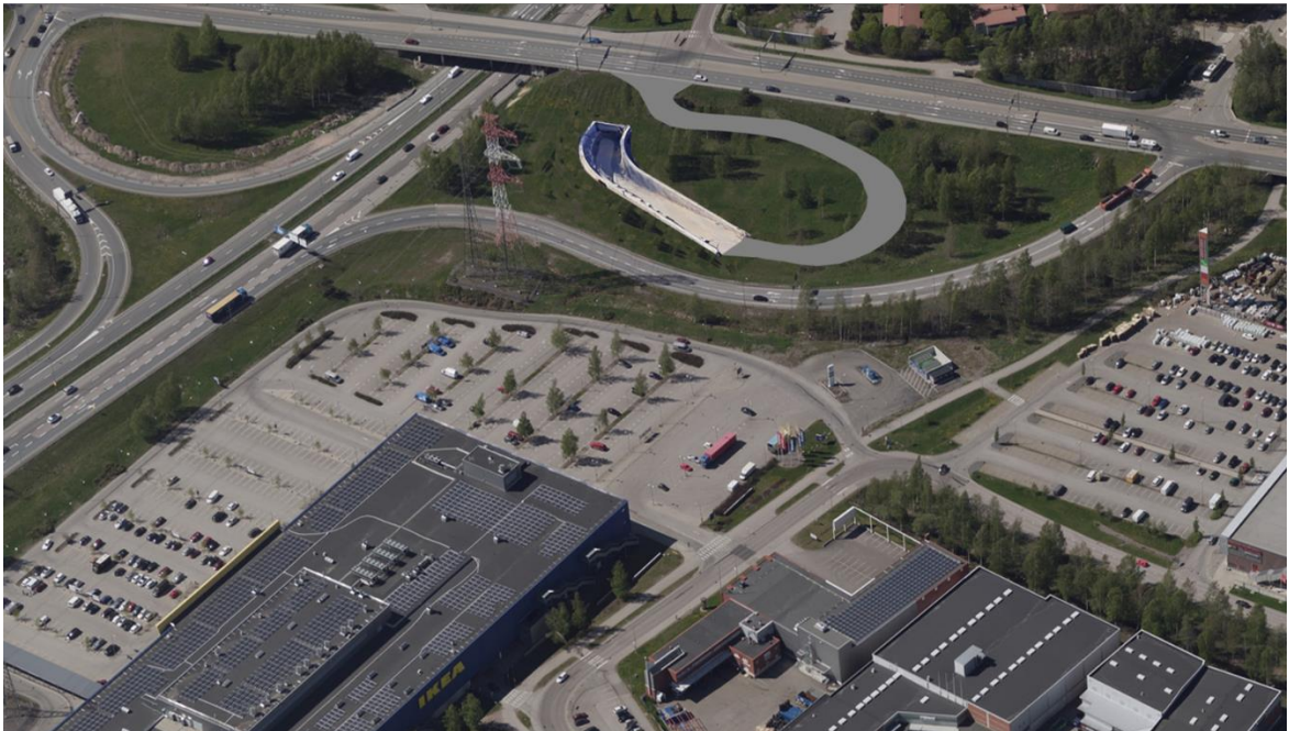
Kuva 21. Tunnelin suuaukko ja ajoyhteys ramppialueen sisäpuolella idästä päin katsottuna. Käytönaikainen liittymä toteutetaan kevyempänä ja maisemaan paremmin mukautuvana (AFRY Finland Oy 2021).
