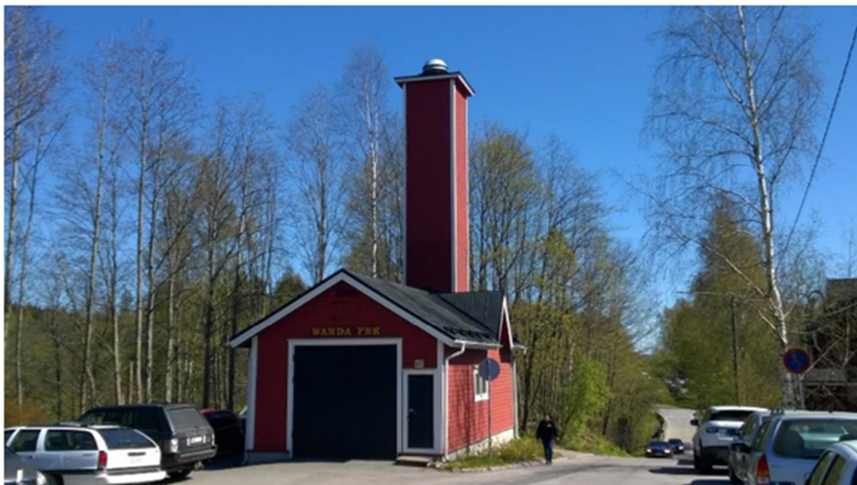
Vanda fbk:n paloasemaa (1909) on nostettu metrillä ylöspäin 2006.
