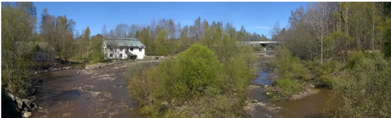
Vantaankoski Kuninkaantien sillalta. Taustalla Kehä III:n sillat.
