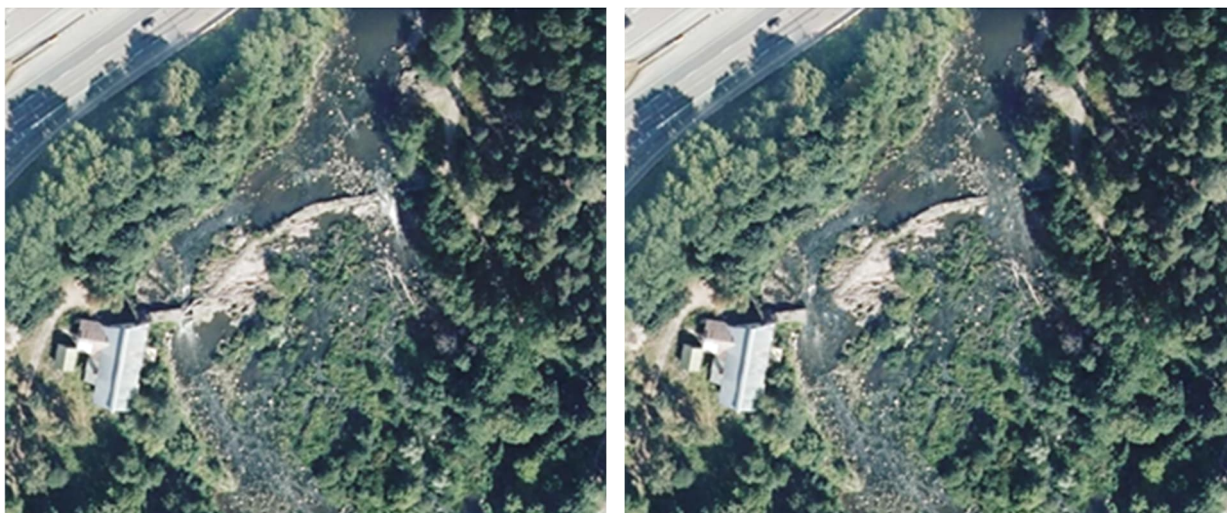
Padon osittainen purkaminen. Vasemmalla nykytila, oikealla osin purettuna.
