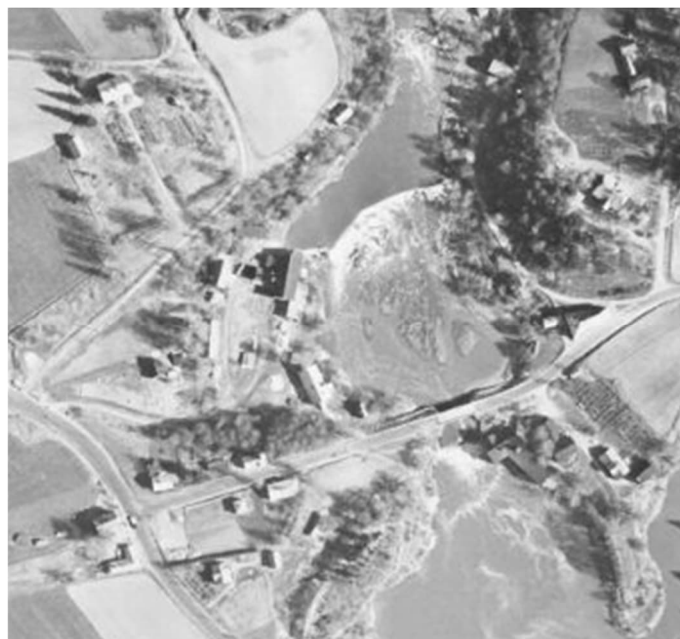
Rakentamista vuoden 1954 ilmakuvassa.
