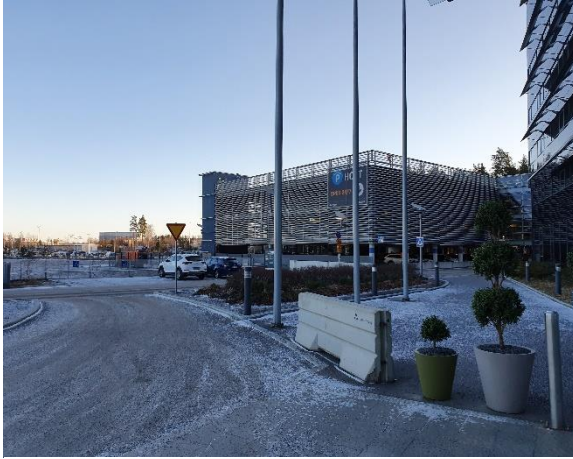
Finnairin pääkonttorirakennuksen pysäköintitalo Tietotien suunnalta nähtynä.
