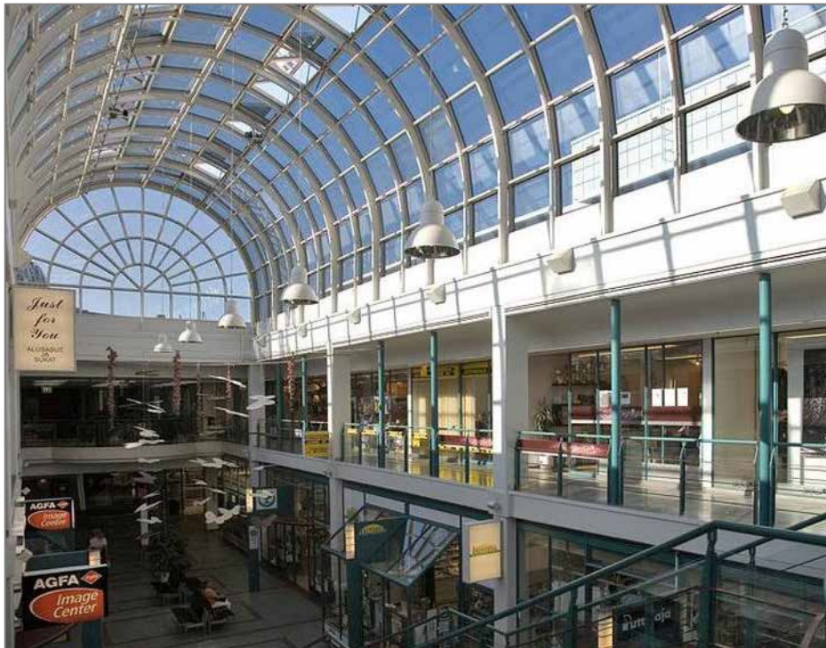
Kuvassa keskuskäytävän kattoikkunat ja alkuperäisiä erkkereitä. Kuva Flickr/ Ark-byroo Oy.
