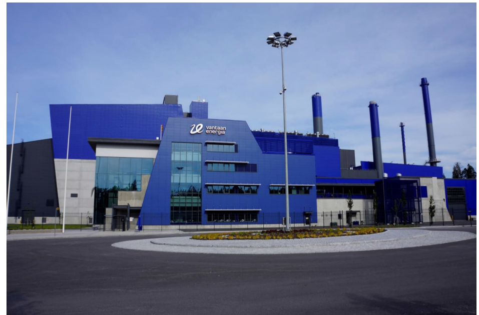
Kuva: Vantaan Energia
