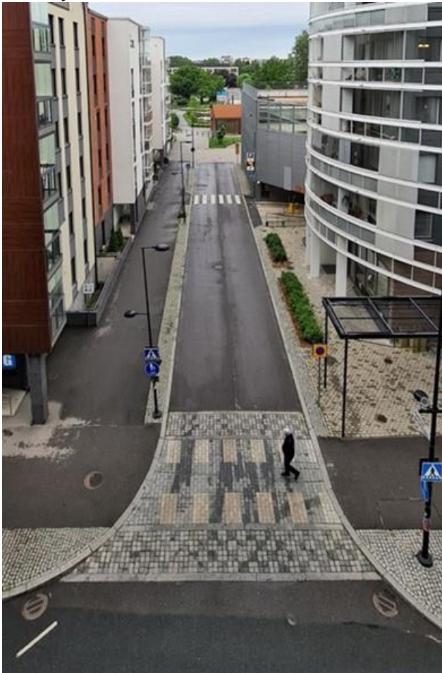
Kuva 1. Suunnittelualueetta Ratakujan kohdalla kesäkuussa 2020 kauppakeskus DIXI:n suunnasta kuvattuna (lähde: Vantaan raitiotie, rakennettavuus selvitys, Ratakujan tunneli Afry Finland 19.4.2021)
