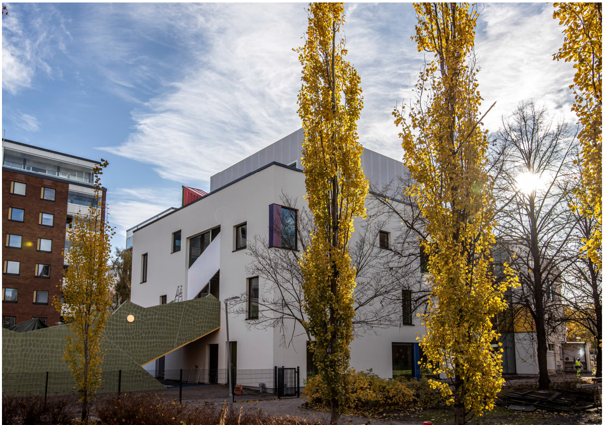
Tikkurilan kolmikerroksinen päiväkotitoimitus valmistui vuonna 2019. Kuva: Sakari Manninen
