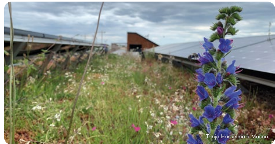
Aurinkopaneelit sopivat hyvin kasvikatoille, sillä kasvillisuuden viilentävän vaikutuksen on todettu pidentävän paneelien käyttöikää. Kun kasvillisuus valitaan tukemaan luonnon monimuotoisuutta, puhutaan biosolar-katosta. Kuvassa on biosolar-katto Kvarteret Sofia -kiinteistön katolla Malmössä.
