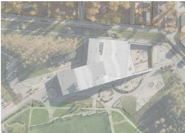
Kuva 1. Tontilla sijaitseva paviljonkipäiväkoti puretaan. Lähde Vampatti 30.11.2021.
