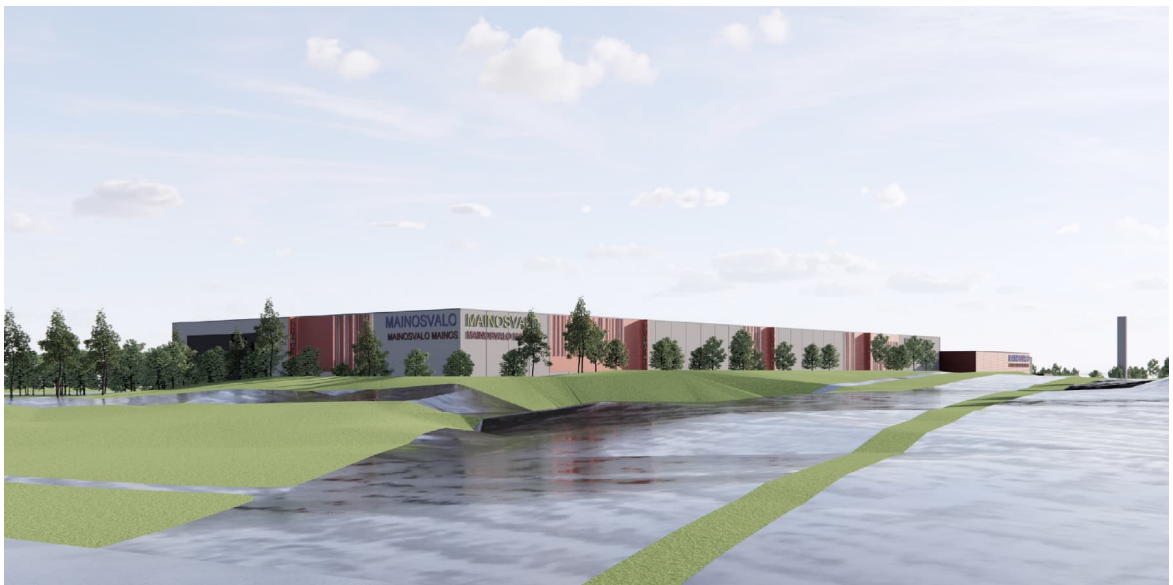
Ainontie 5 nähtynä Kehä III:n länteen johtavilta kaistoilta.
