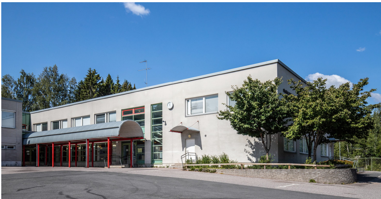
Päiväkummun koulussa siirryttiin öljylämmityksestä kaukolämpöön. Kuva: Ilari Lehtinen
