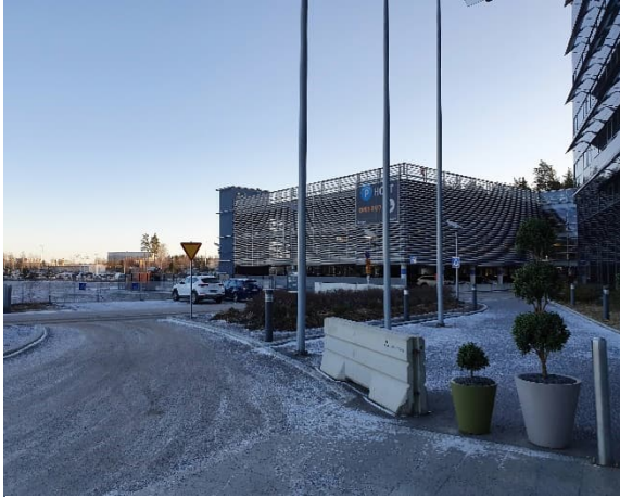
Finnairin pääkonttorirakennuksen pysäköintitalo Tietotien suunnalta nähtynä.
