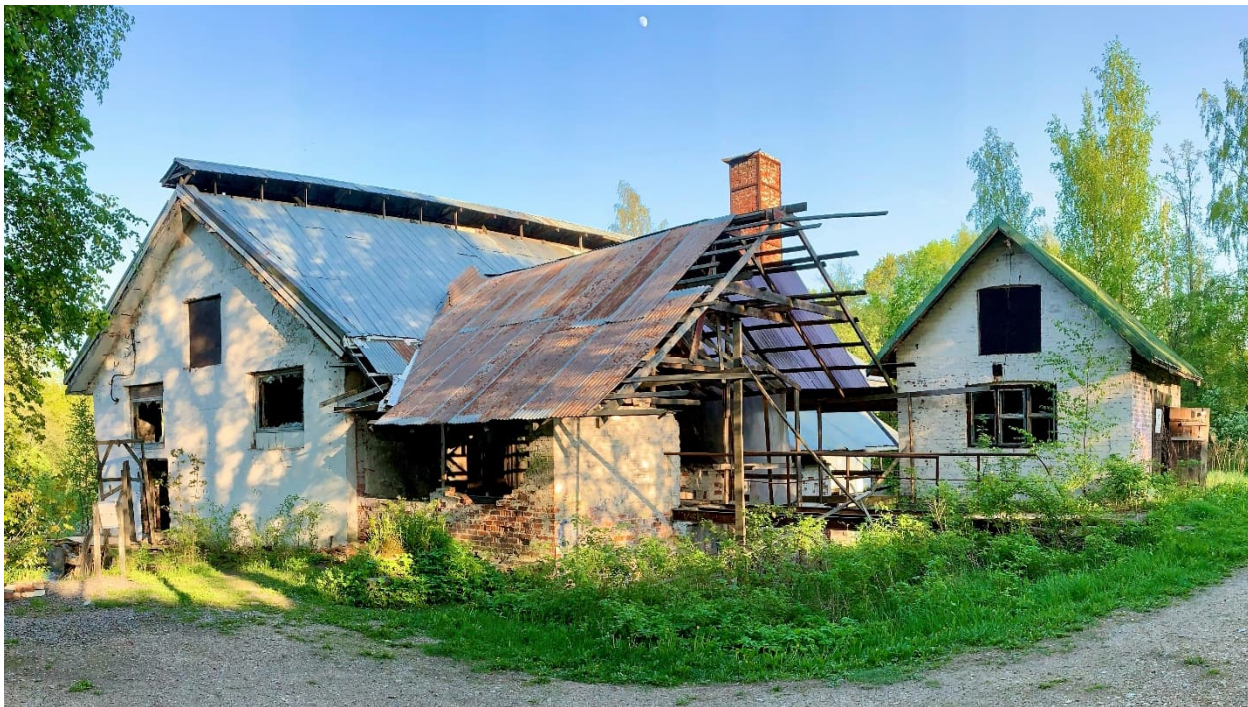
Mylly ja sähkölaitos pohjoispuolelta. Keskiosa puretaan. Sen paikalle tulee aulatiloja ja kabinetti. TKa 22.5.2021
