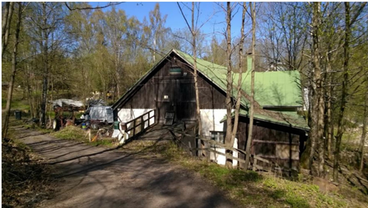
Vanha navetta/varasto sijaitsee masuunin paikalla ja puretaan.
