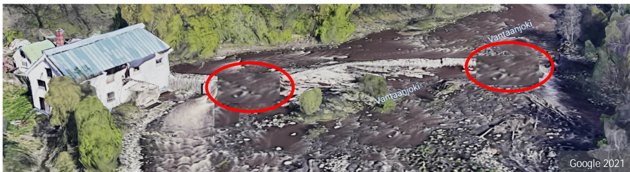
Padon osittainen purkaminen. Aukkoja levitetään keskelle päin, jolloin reunat ja keskiosa säilyvät nykyisinä ja vaikutus maisemaan on vähäisin. Mitä isommat aukot, sen parempi kalatie. TKa 2022
