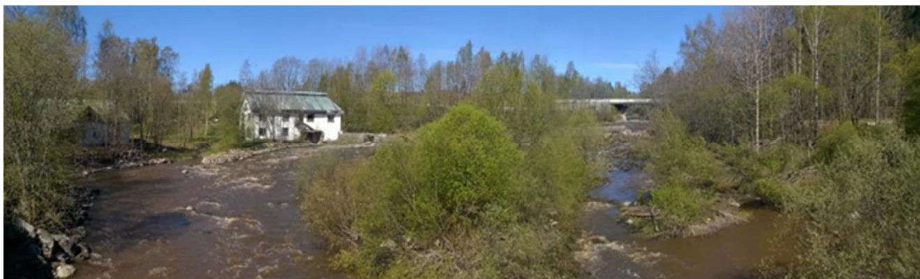
Vantaankoski Kuninkaantien sillalta. Taustalla Kehä III:n sillat.
