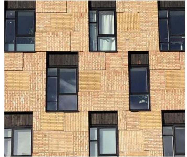
Resource rows, Kööpenhamina. Uudelleenkäytettyä tiiliseinää ja ikkunoita uudessa asuinrakennuksessa. Kuva: Inari Virkkala
