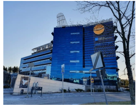
Tietotie 9:n metallijulkisivu on näyttävä.
