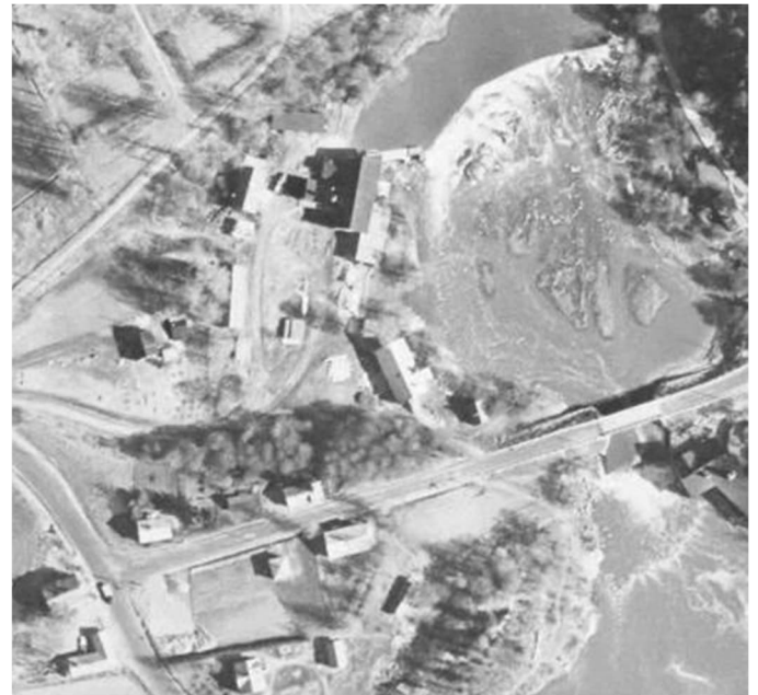
Rakentamista vuoden 1954 ilmakuvassa.
