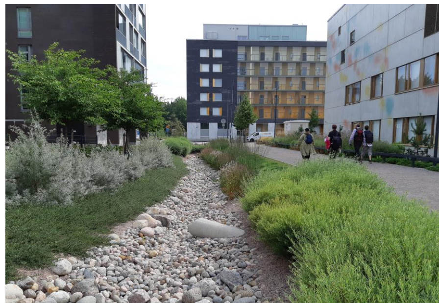
Kuva: Timanttikiteenpuiston hulevesireitti istutuksineen Kivistössä (Kuva: Vantaan kaupunki, Eeva Eitsi 2022)
