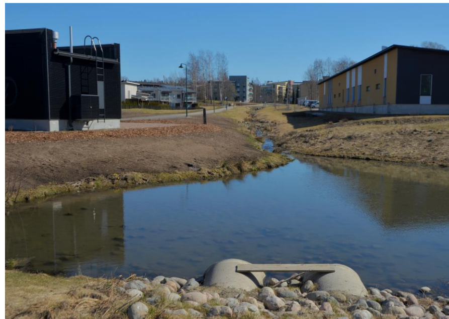
Kuva: Vaskipellonoja ja allas Kaivokselassa tuovat hulevesien hallinnan lisäksi vaihtelevan maiseman päiväkodin ja puiston ulkoiluraitin välille. Ojan leveys vaihtelee luonnollisen oloisesti. Altaassa on tasaustilavuutta tulvatilannetta varten. (Kuva: Vantaan kaupunki, Antti Auvinen)
