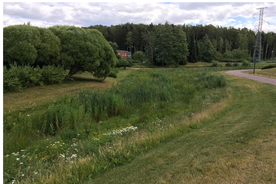
Kuva: Kolmikallionpuiston altaat Multaojan latvoilla. (Kuva: Vantaan kaupunki, Antti Auvinen 2022)
