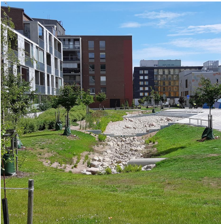
Kuva: Timanttikiteenpuiston veistoksellinen hulevesirakenne Kivistössä (Kuva: Vantaan kaupunki, Eeva Eitsi 2021)
