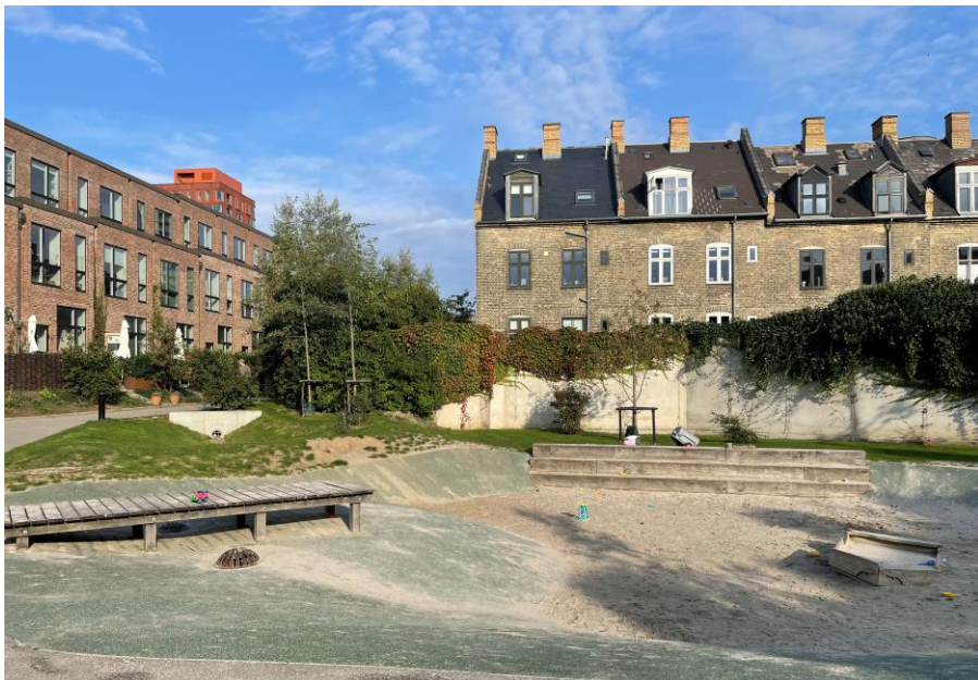
Kuva: Kuivana kautena hulevesiallas toimii leikki- ja oleskelualueena. Kööpenhaminassa Österbron ilmastonkestävä kaupunginosa on rakennettu esittelemään ilmastonmuutokseen sopeutumisen ratkaisuja. (Kuva: Vantaan kaupunki, Marja Kärki 2022)
