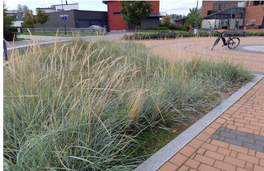
Kuva: Tiikerinsilmän hulevesirakenne viivyttää ja suodattaa katuvesiä Kivistössä. Painanteen viereinen kivimuuri soveltuu istuskeluun. (Kuva: Vantaan kaupunki, Eeva Eitsi 2021)
