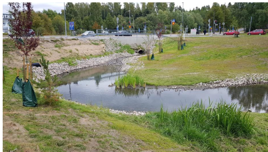
Kuva: Kunnossapidon näkökulmasta kiviä kannattaa sijoittaa vain sellaisiin paikkoihin, joissa ne ovat tarpeen esimerkiksi eroosion estämiseksi tai maisemallisena elementtinä. Laskeutusta ja tulvatasannetta Paskurinojassa Lahdessa. (Kuva: Vantaan kaupunki, Marika Orava 2022)
