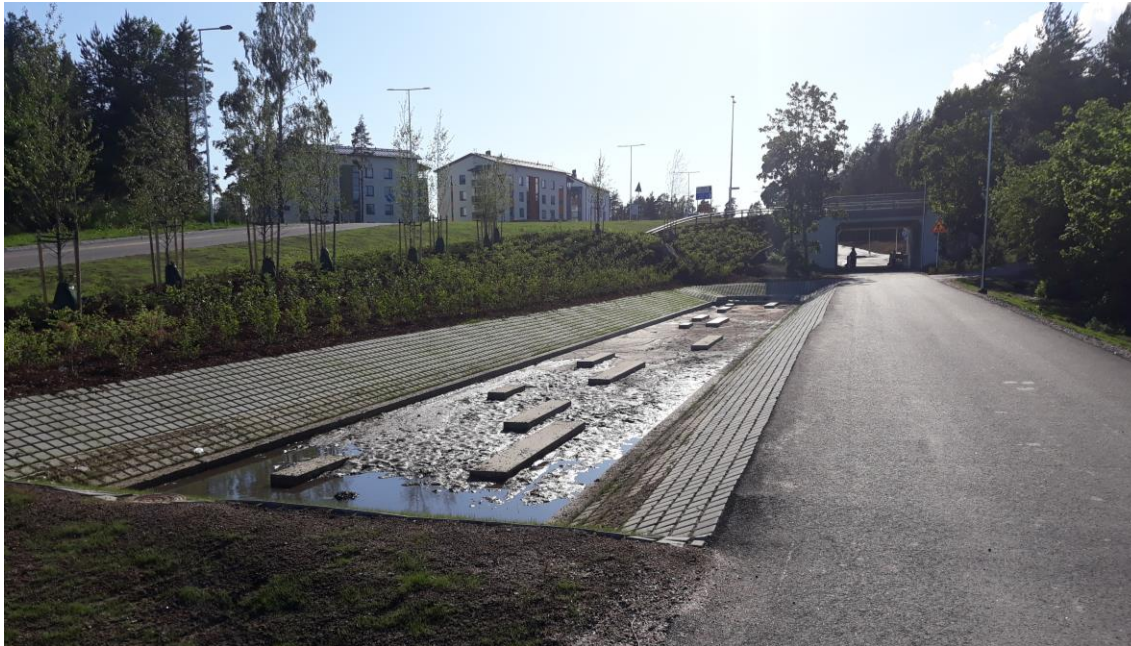
Kuva: Sadetilanteessa 6.9.2022 vesi nousi Länsimäentien hulevesipainanteessa puoli metriä ja suotautui tämän jälkeen hitaasti rakenteen läpi. Rankkasateen päättymisestä on kulunut useita tunteja. (Kuva: Vantaan kaupunki, Antti Auvinen 2022)
