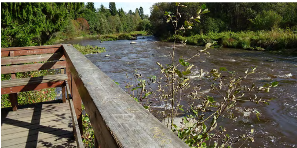
Kuva 43. Esimerkkikohde: Pitkäkosken luonnontarkkailupaikka, Ylästö
