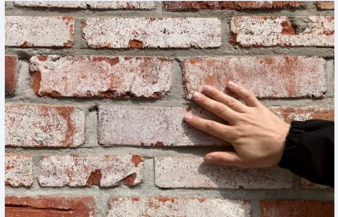
Kuva: Tikkurilan paviljonkikoulun varaston rakentamisessa on käytetty Kansallisteatterista purettuja tiiliä. Kuvaaja: Jenni Särnä
