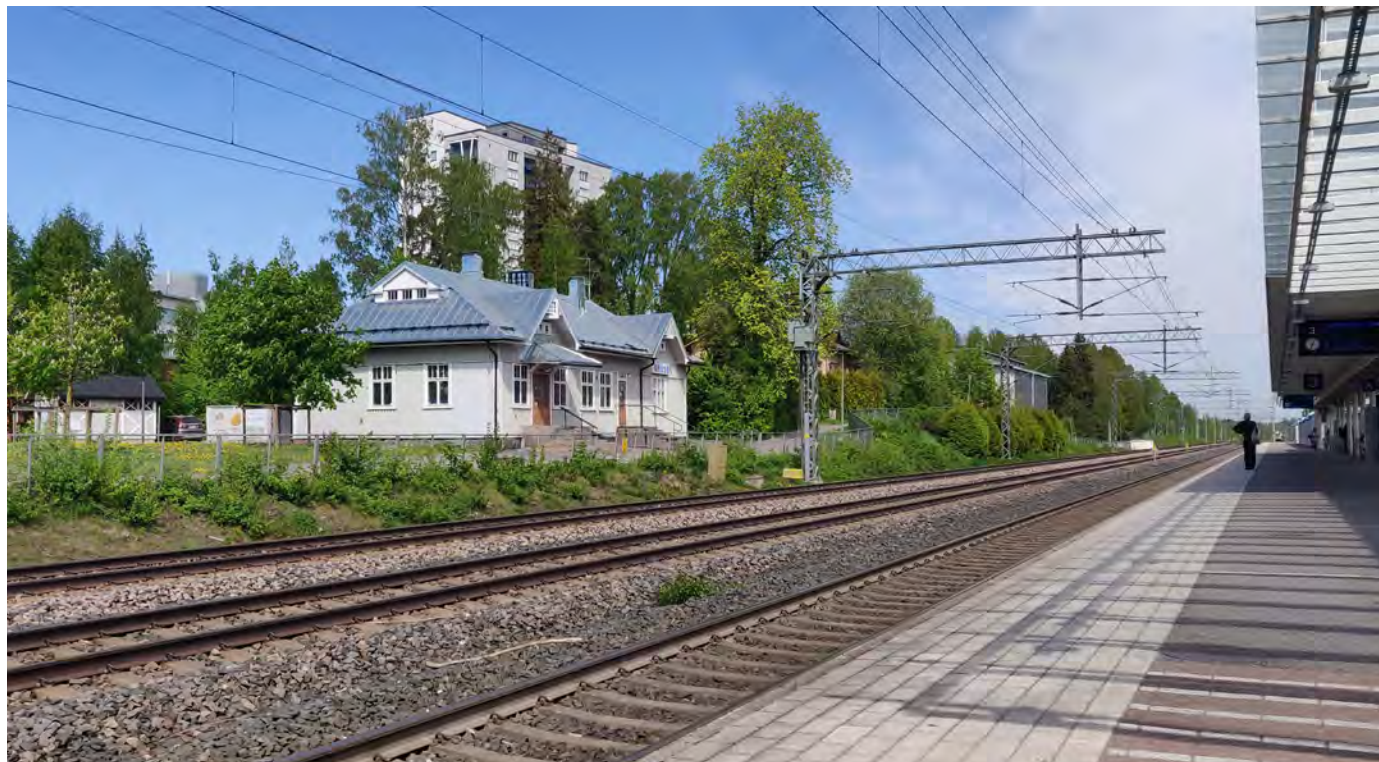
Kuva 20. Näkymä vanhalle asemalle laiturilta. (05/2023)
