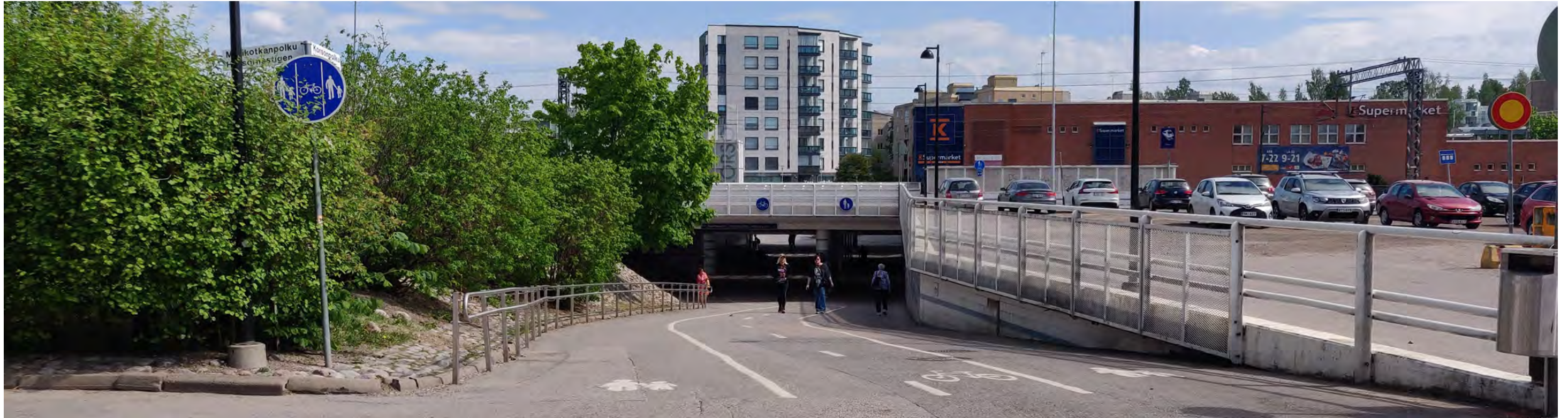
Kuva 19. Luiska Korsonaukiolta alikulkuun. (05/2023)
