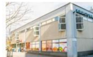
9. Pallastunturintien Liikekiinteistö Oy 1977
