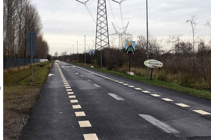
oik. alhaalla: Silkeborg, Tanska 2-1 -tieksi muutettu maantie. Huomaa käytöstä poistetut vanhat kaistaviivat tien keskellä.
