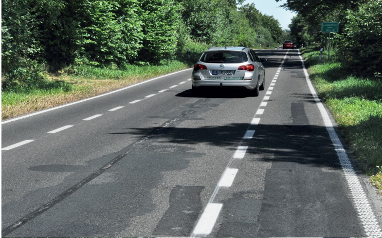
vas. ylhäällä: Hoisdorf, Saksa Pituussuuntaisissa tiemerkinnoissa käytetty yhtenäistä ajoradan reunaviivaa ja katkonaista kaistojen erotusviivaa.
