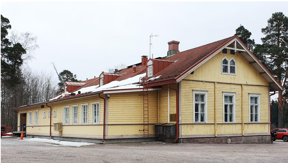
Kuva 27. Suojeltu rakennus ja sen pohjoinen laajennusosa.
