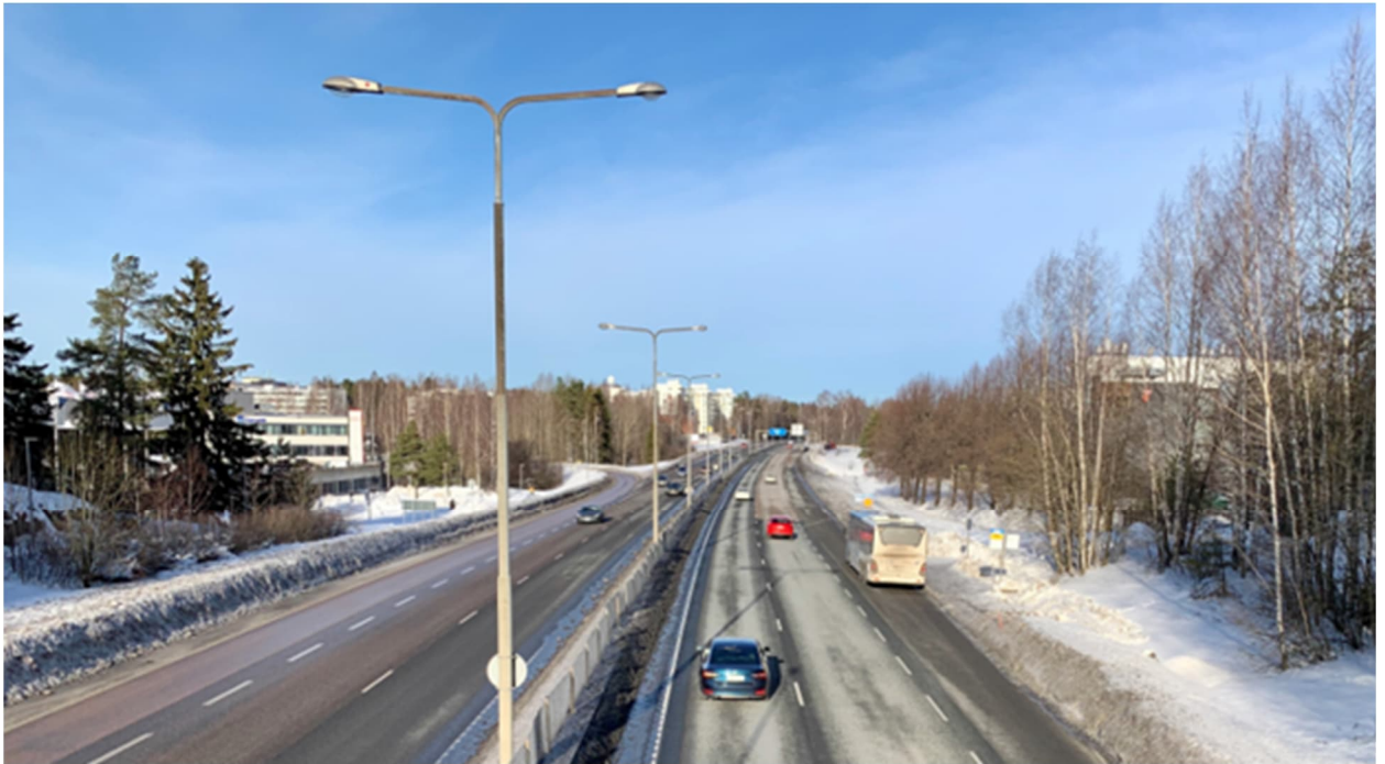
Hämeenlinnanväylä Palotien sillalta pohjoiseen.
