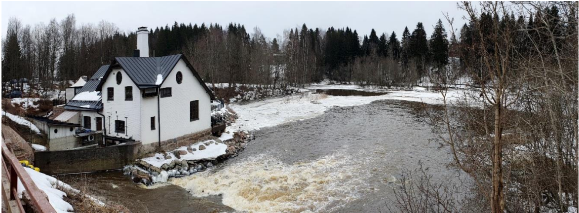
Kuva 12. Vantaanjoki ja vanha viilatehdas Kuninkaantien sillalta katsottuna.
