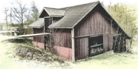
Nedre Nybackan lato 1950-luvulta puretaan.
