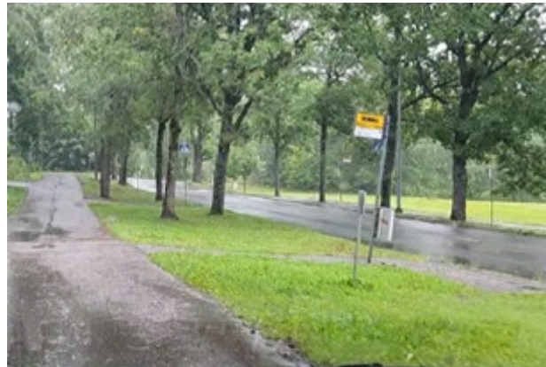
Tältä Hevoshaantien pysäkiltä puuttuu kunnollinen ja korotettu odotustila. Kuva: Vantaan kaupunki / Vaisala RoadAi-video
