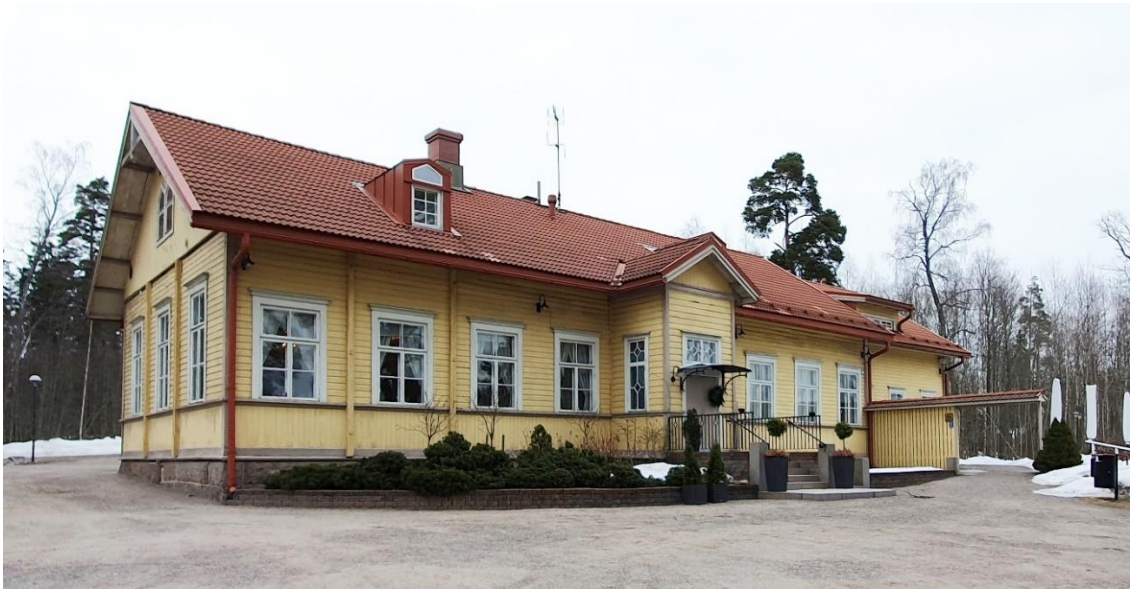
Kuva 26. Suojeltu rakennus ja sen itäinen laajennusosa.
