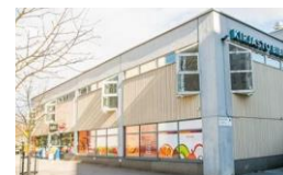
7. Pallastunturintien Liikekiinteistö Oy 1977
