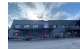
15. KOy Vantaan Helikopteritukikohta 2009
