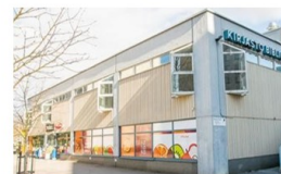
7. Pallastunturintien Liikekiinteistö Oy 1977
