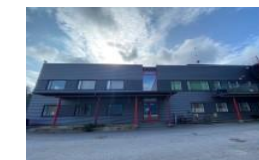
15. KOy Vantaan Helikopteritukikohta 2009
