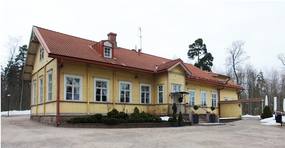
Kuva 26. Suojeltu rakennus ja sen itäinen laajennusosa.
