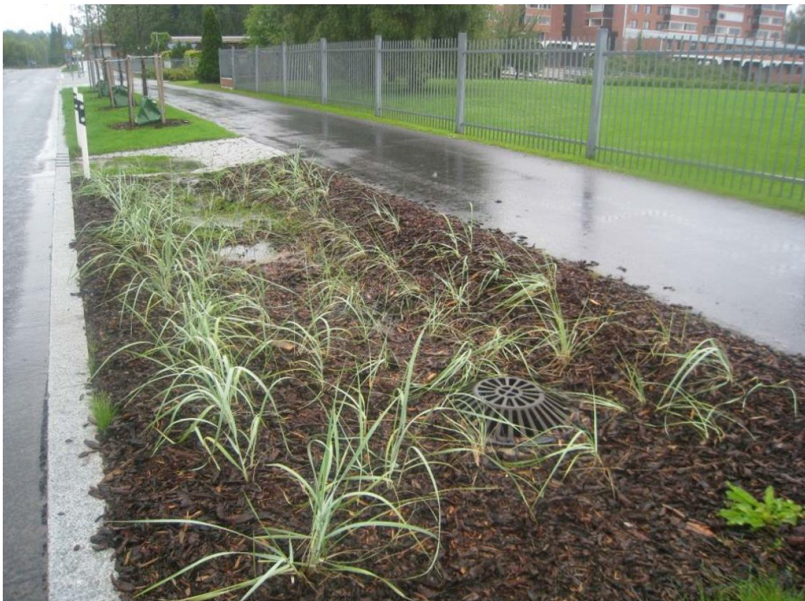
Kuva 5. Vantaan Koivuhaan Meiramtien hulevesien hallintarakenne (Vantaan kaupunki 2013)
