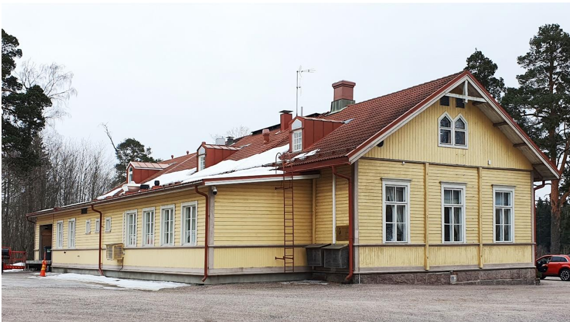
Kuva 27. Suojeltu rakennus ja sen pohjoinen laajennusosa.
