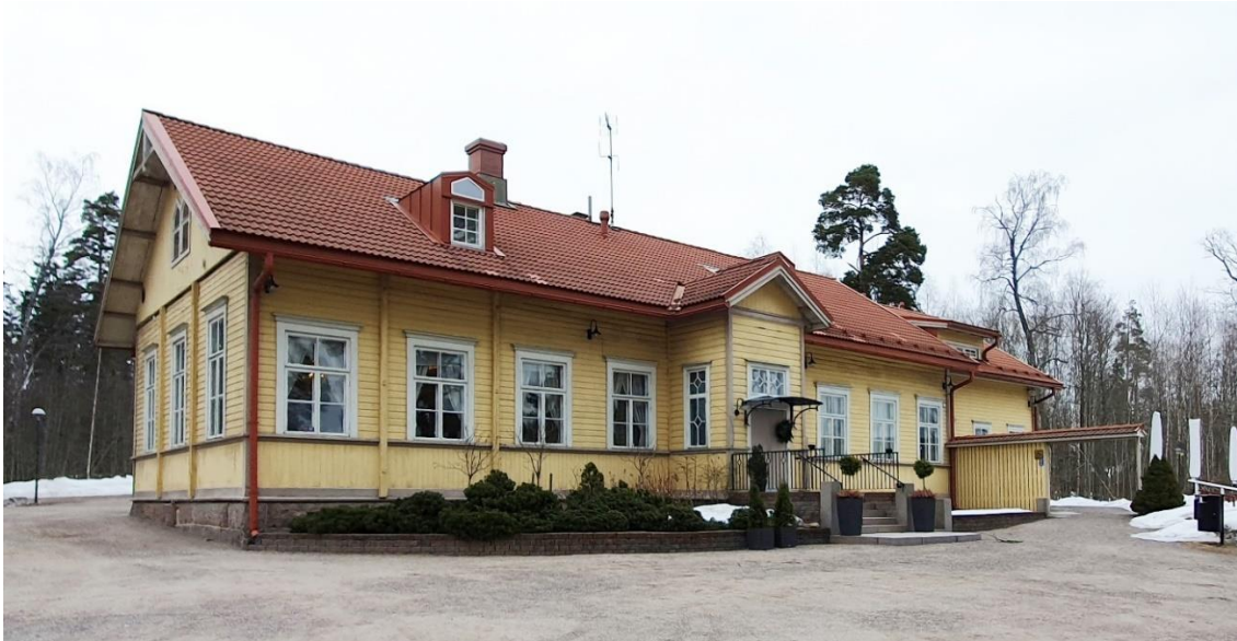
Kuva 26. Suojeltu rakennus ja sen itäinen laajennusosa.
