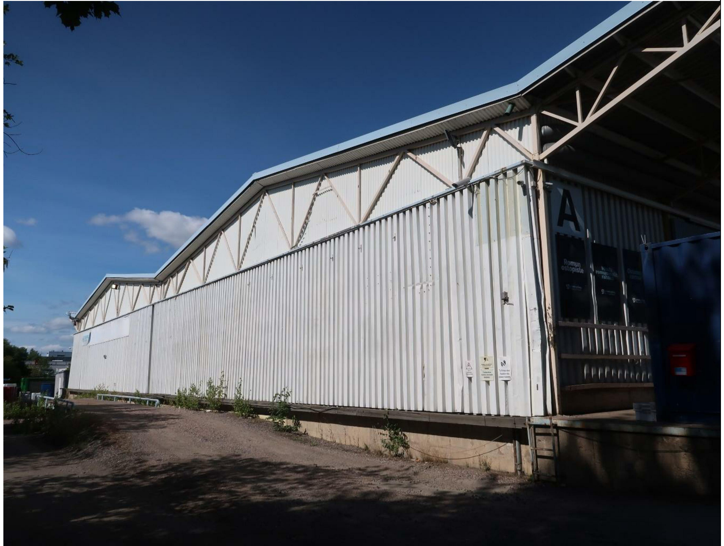
Kuva 5. Rakennus A, rakennuksen eteläpuoleinen julkisivu.
