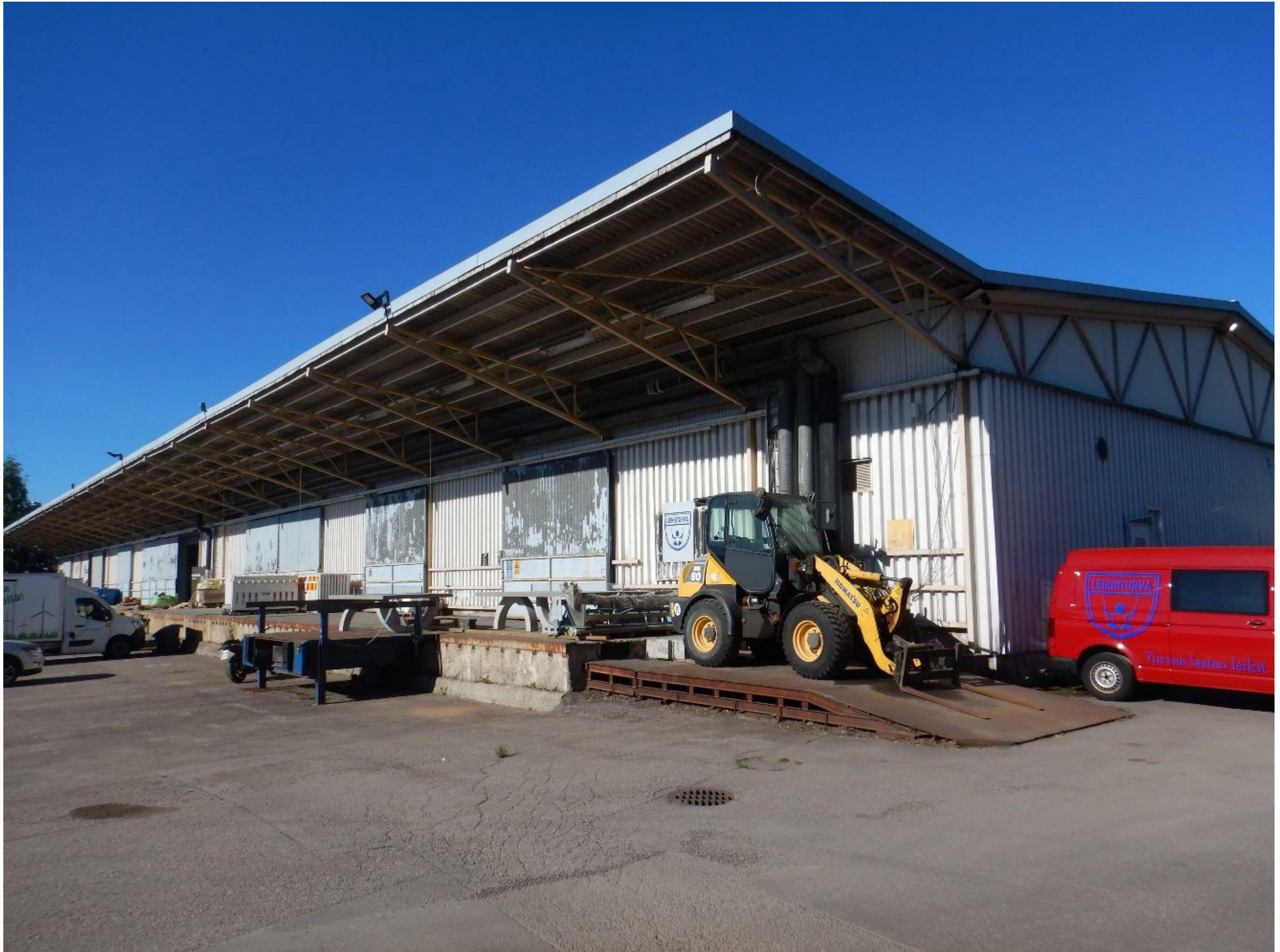
Kuva 1. Rakennus A, rakennuksen pohjois- ja itäpuolen julkisivu.
