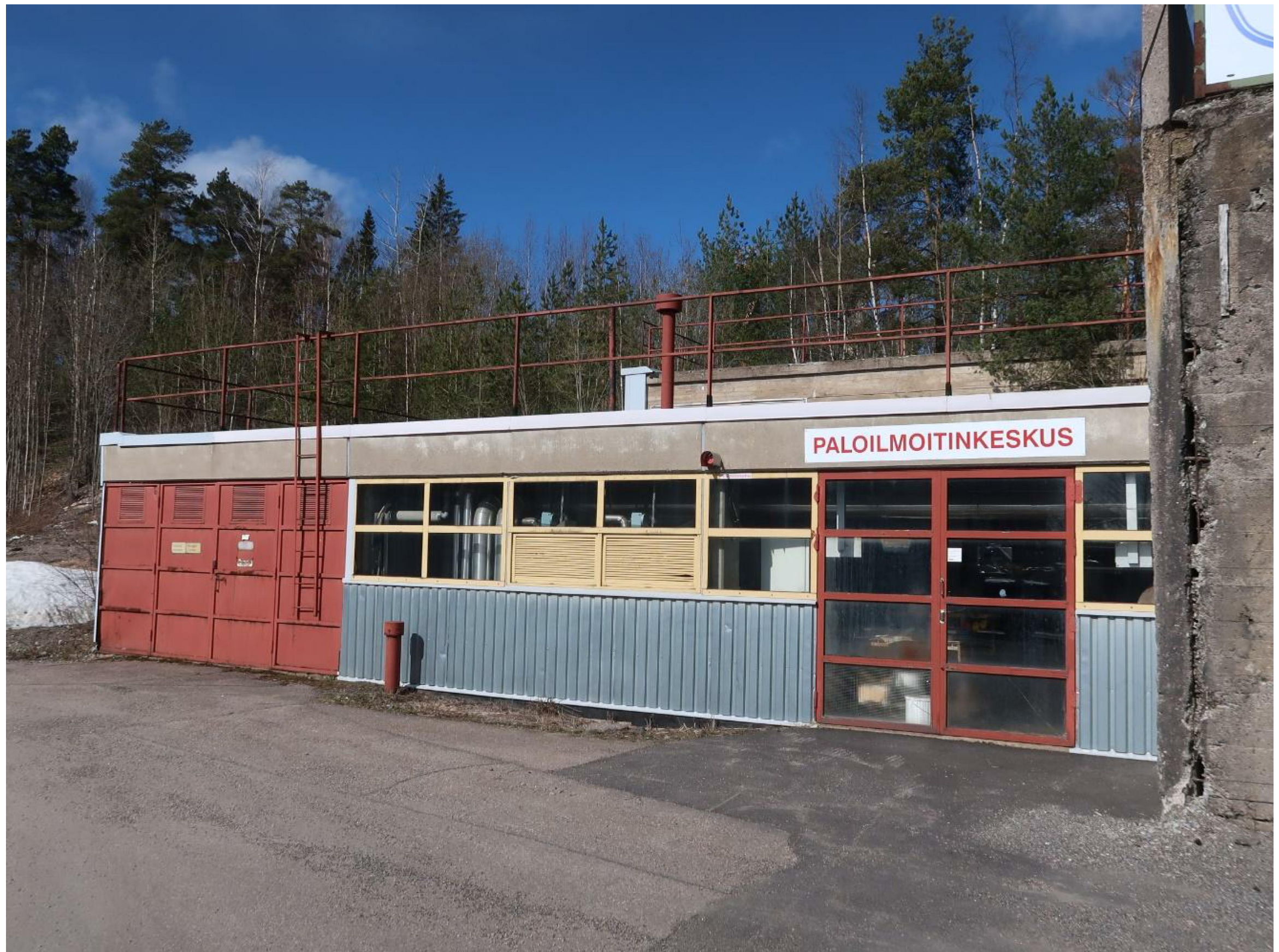
Kuva 8. Paloilmoitinkeskus, rakennuksen eteläpuolen julkisivu.
