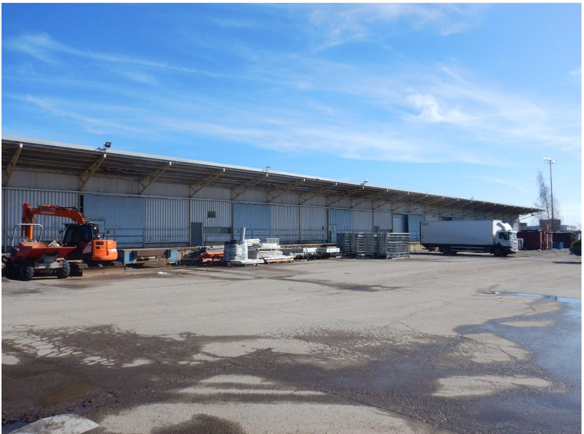
Kuva 4. Rakennus A, rakennuksen länsipuolen julkisivu.
