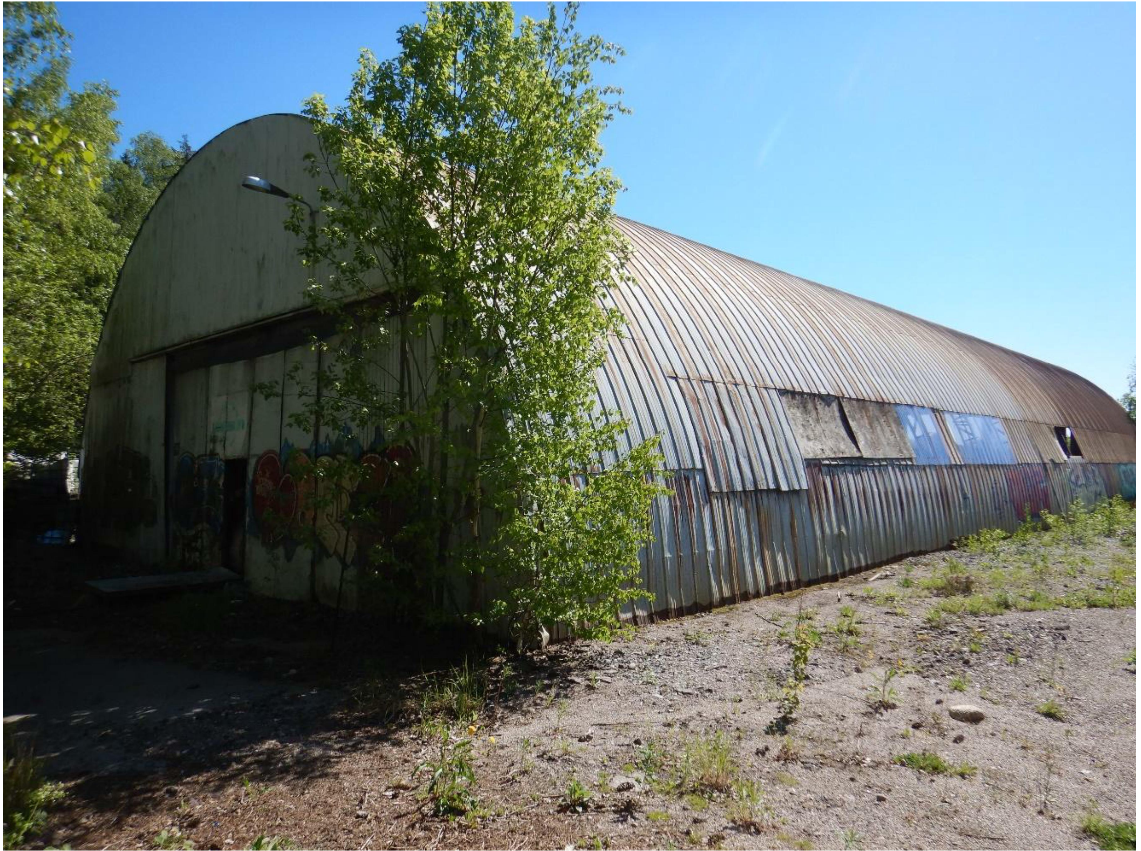
Kuva 16. Pitkä kaarihalli, rakennuksen pohjois- ja länsipuolen julkisivu.
