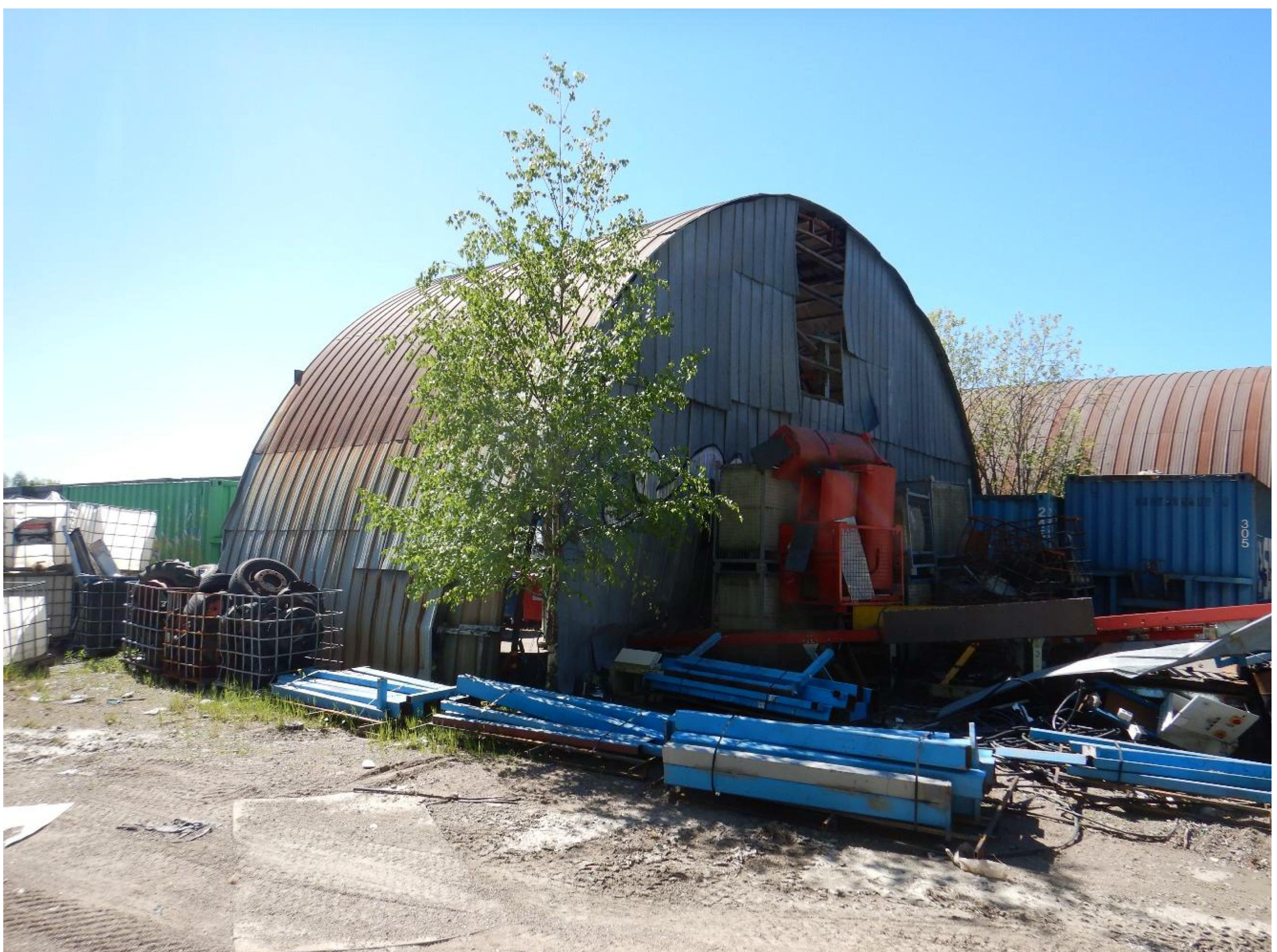
Kuva 19. Lyhyt kaarihalli, rakennuksen pohjois- ja itäpuolen julkisivu.
