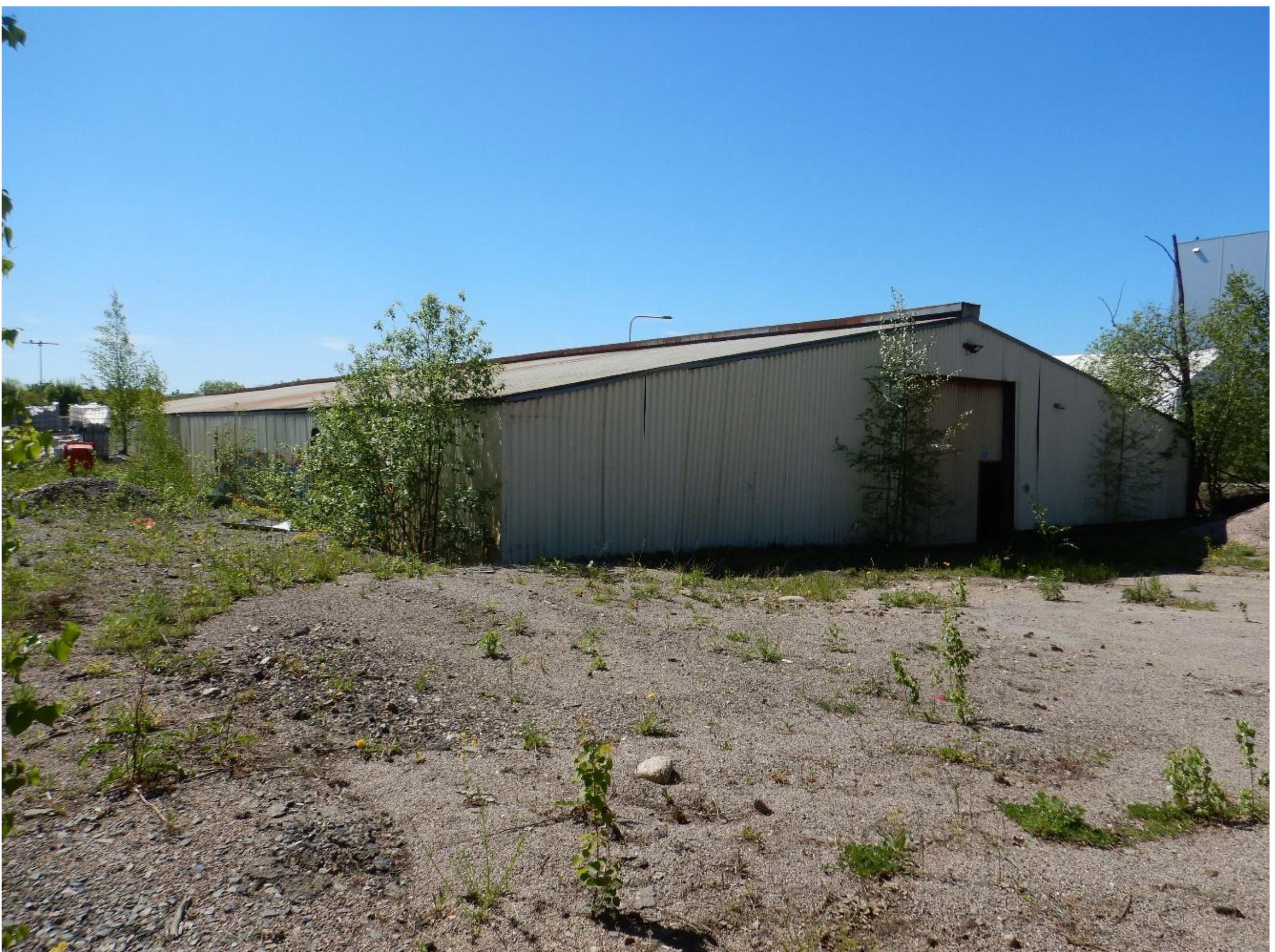
Kuva 11. Peltihalli, rakennuksen pohjois- ja itäpuolen julkisivu.
