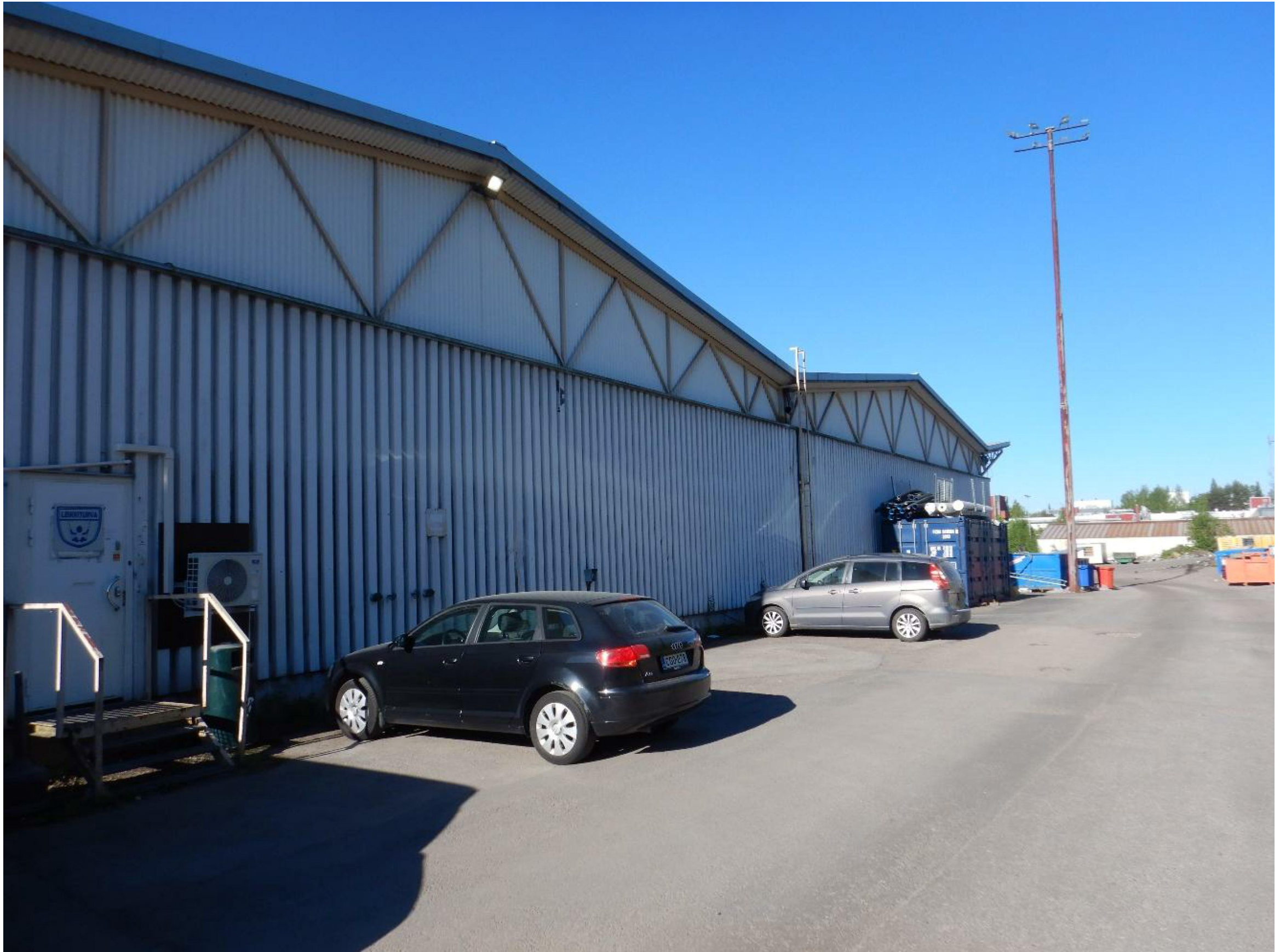
Kuva 3. Rakennus A, rakennuksen pohjoispuolen julkisivu.
