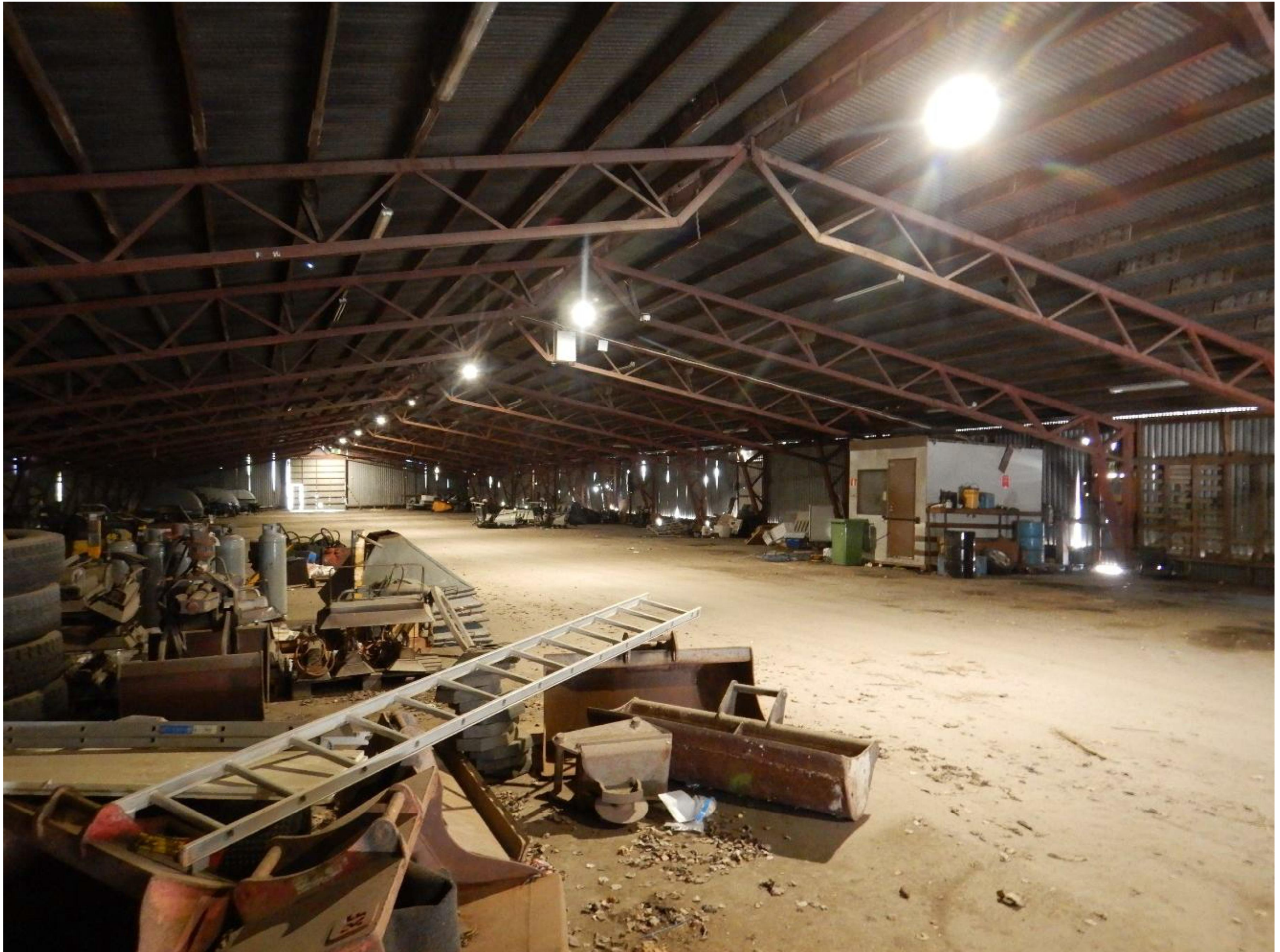
Kuva 14. Peltihalli, yleiskuva rakennuksen sisältä.
