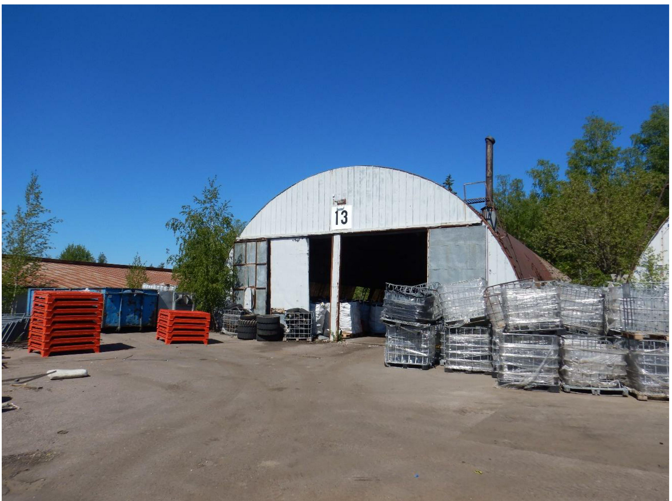
Kuva 15. Pitkä kaarihalli, rakennuksen eteläpuolen julkisivu.
