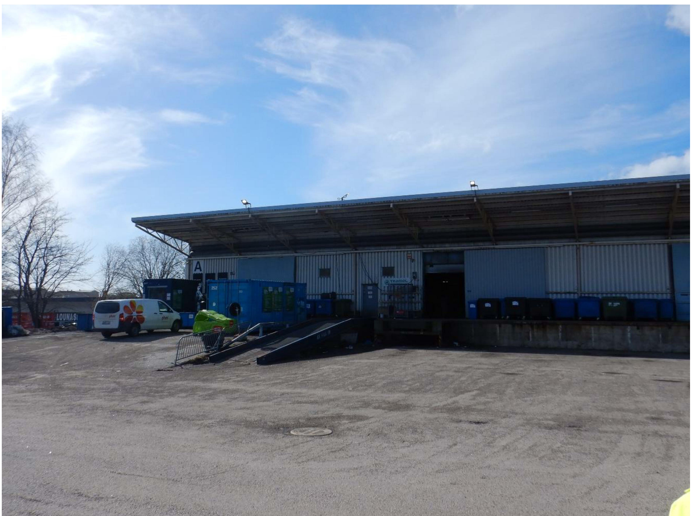
Kuva 2. Rakennus A, rakennuksen itäpuolen julkisivu.
