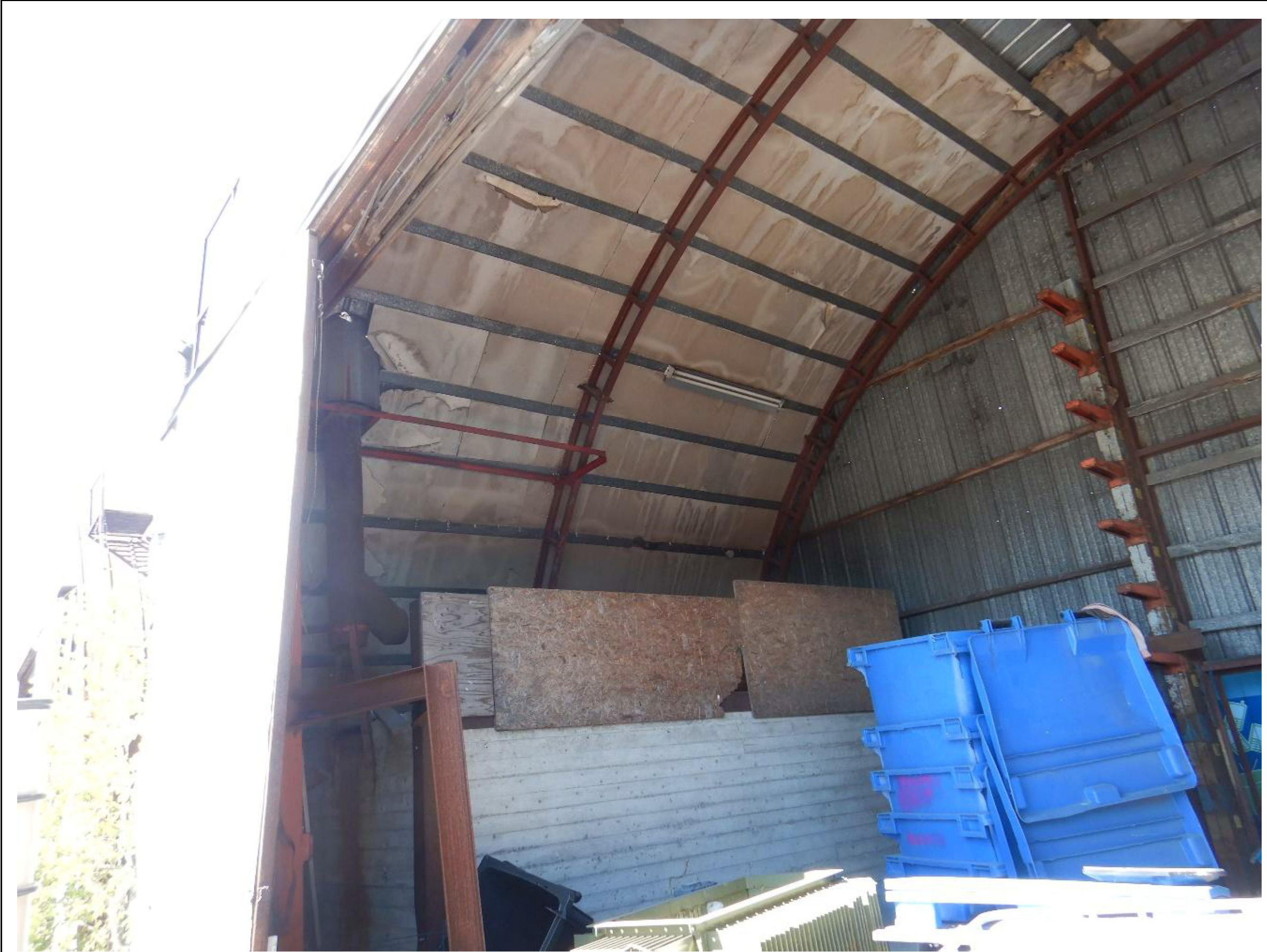
Kuva 20. Lyhyt kaarihalli, yleiskuva rakennuksen sisältä.
