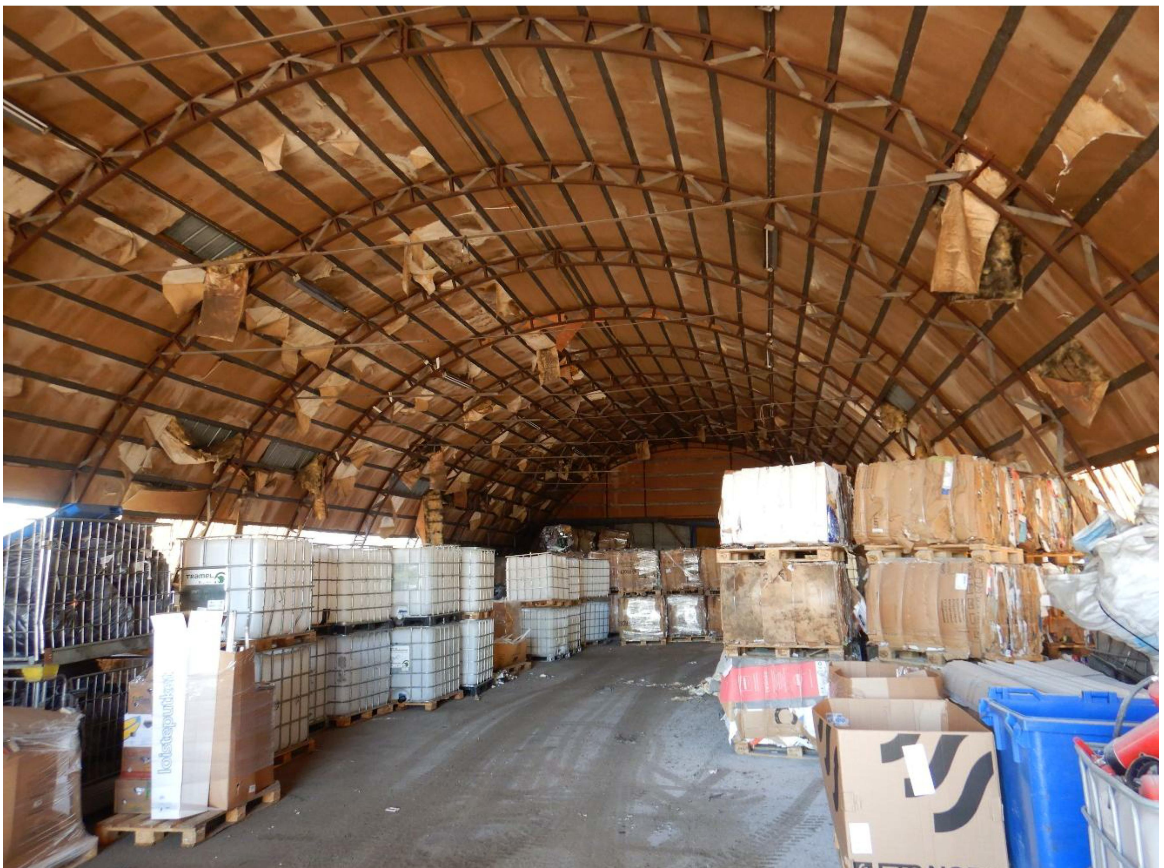
Kuva 17. Pitkä kaarihalli, yleiskuva rakennuksen sisältä.
