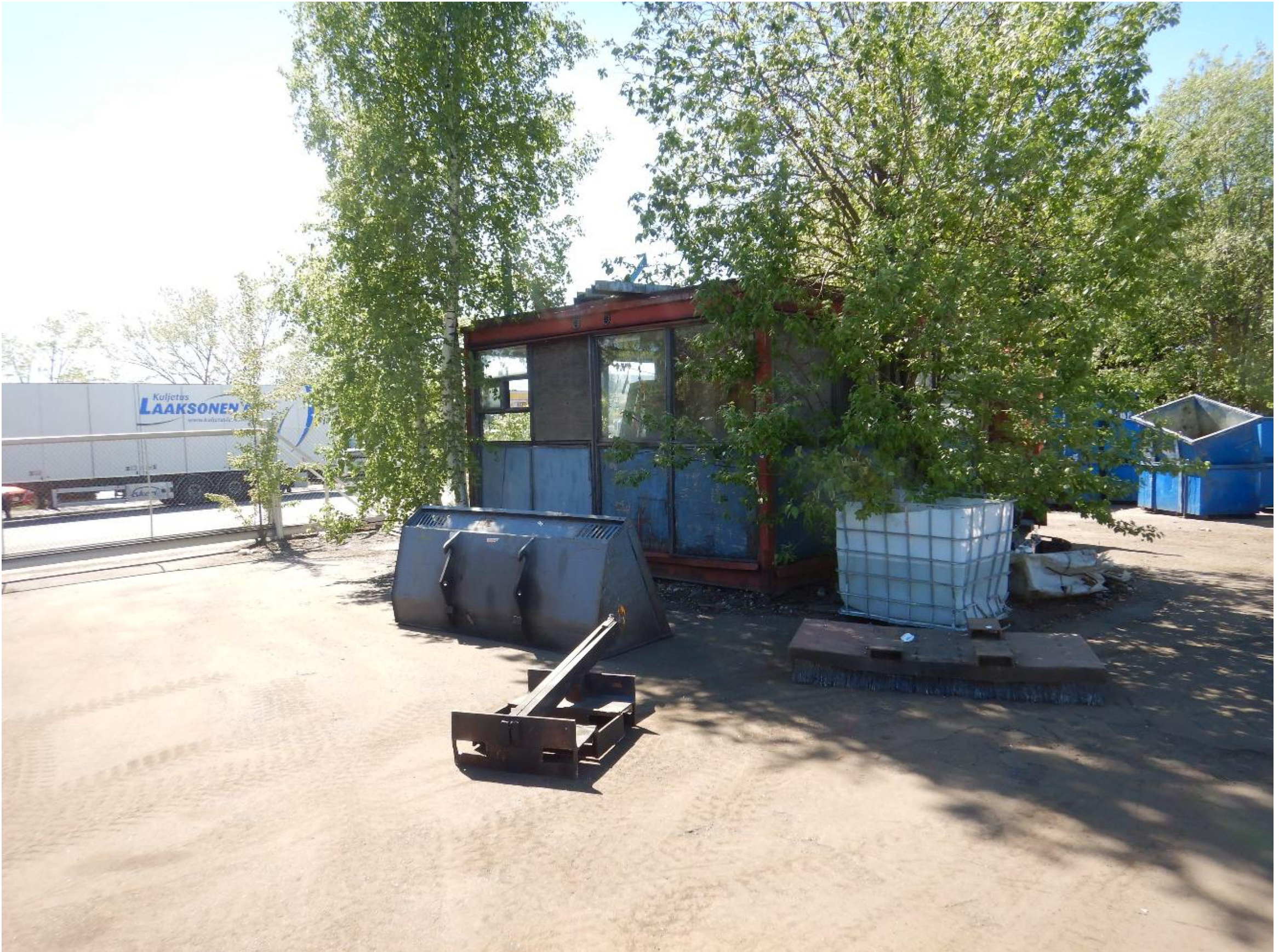
Kuva 22. Porttivartijan rakennus, rakennuksen pohjois- ja itäpuolen julkisivu.
