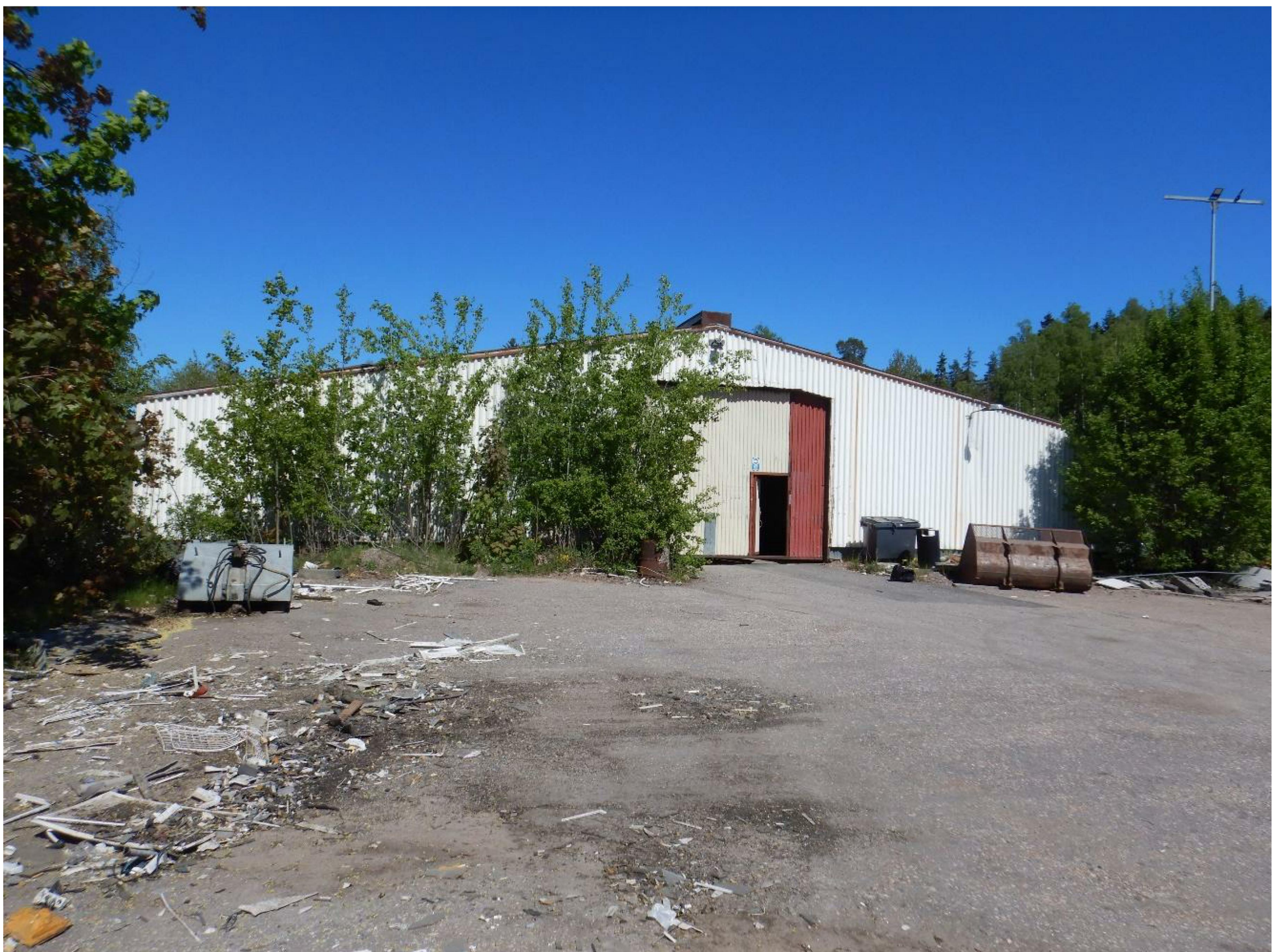
Kuva 13. Peltihalli, rakennuksen eteläpuolen julkisivu.
