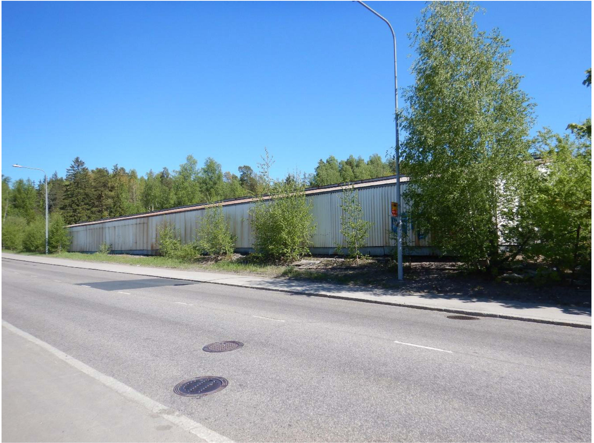
Kuva 12. Peltihalli, rakennuksen länsipuolen julkisivu.
