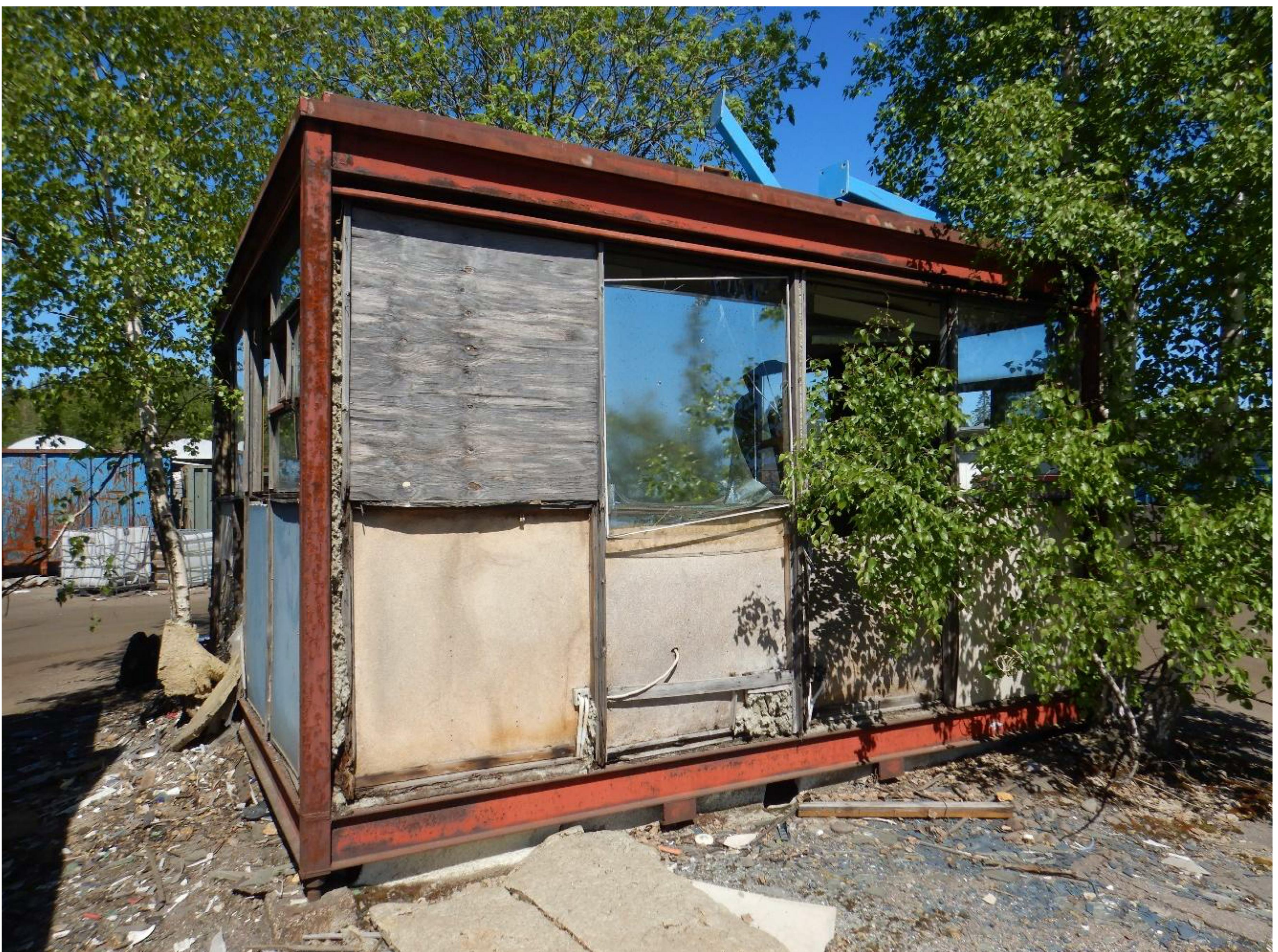
Kuva 23. Porttivartijan rakennus, rakennuksen etelä- ja länsipuolen julkisivu.
