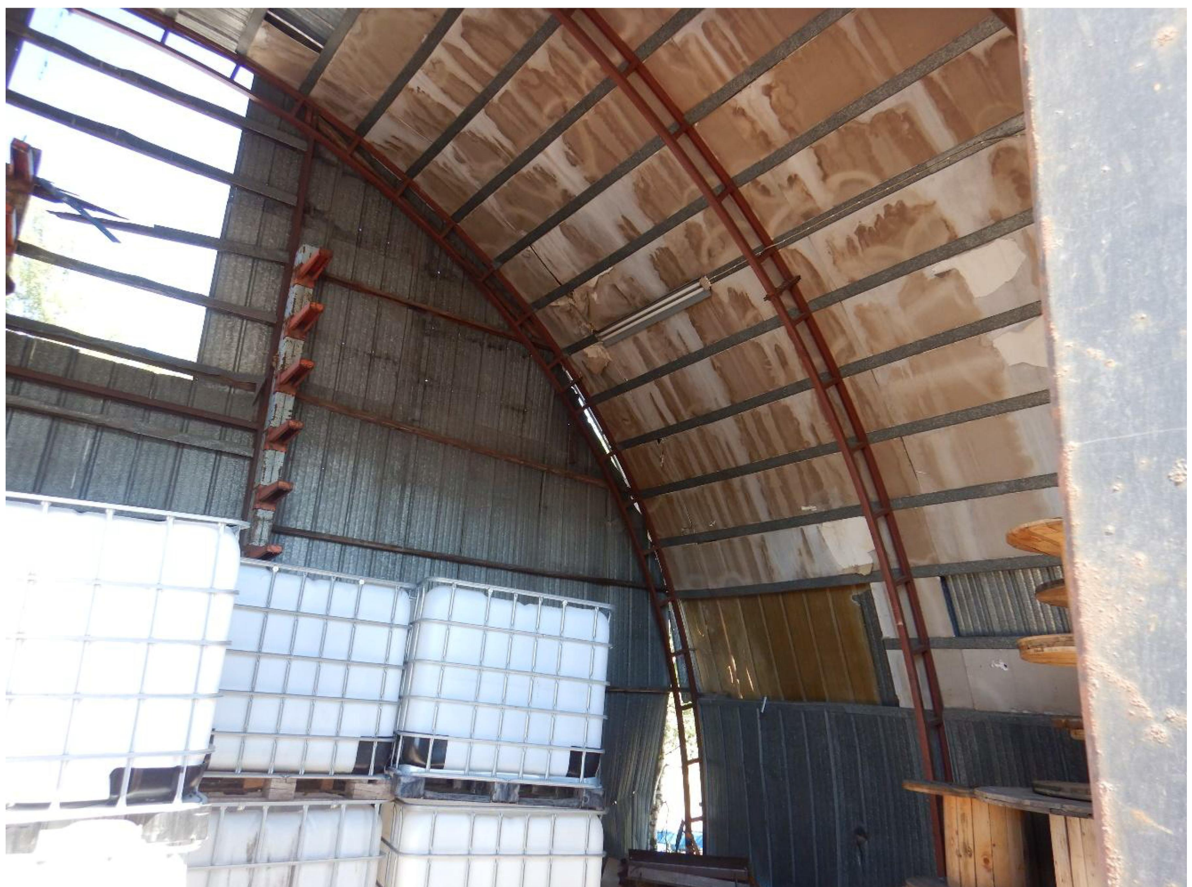
Kuva 21. Lyhyt kaarihalli, yleiskuva rakennuksen sisältä.
