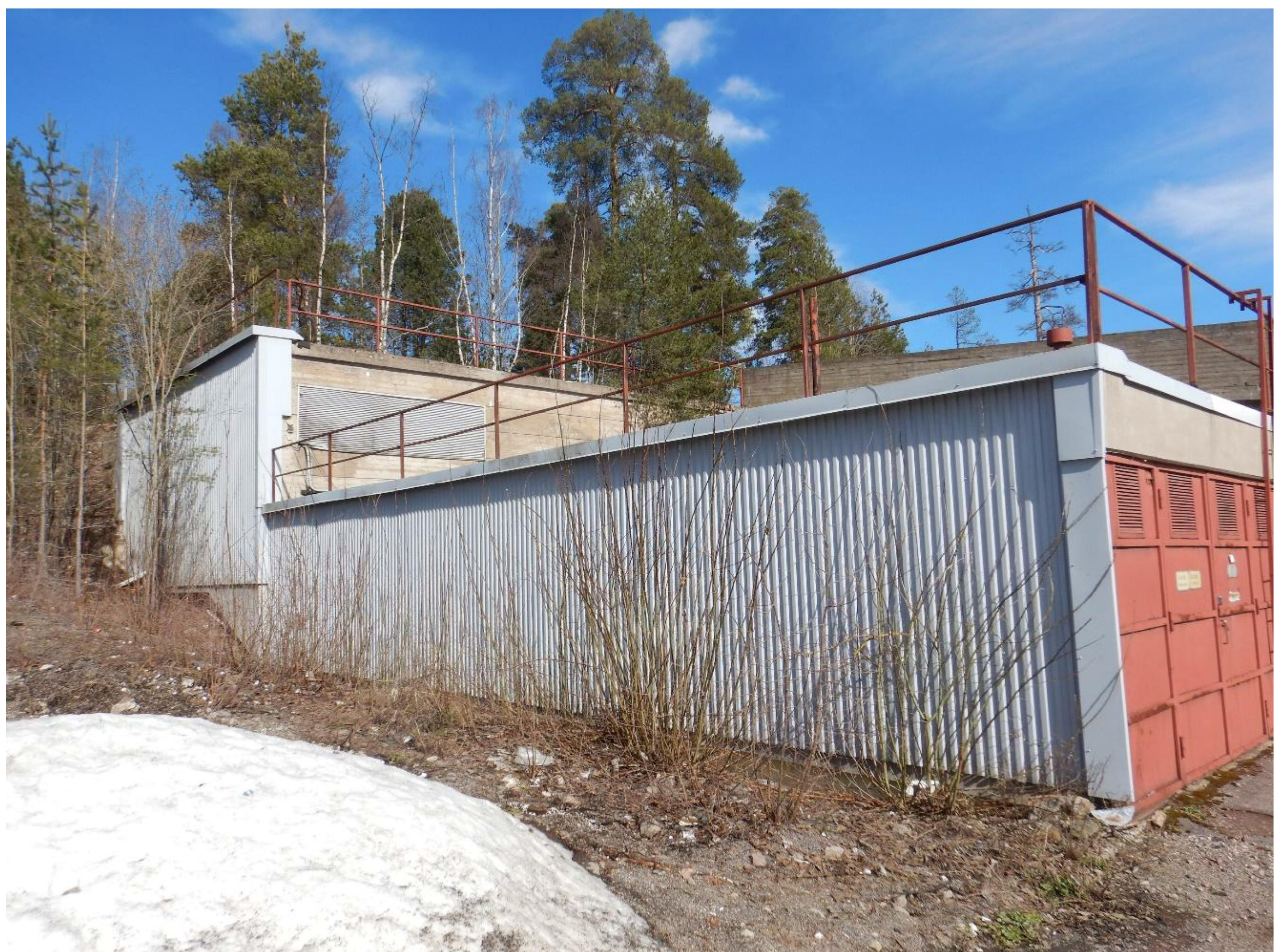
Kuva 9. Paloilmoitinkeskus, rakennuksen länsipuolen julkisivu.
