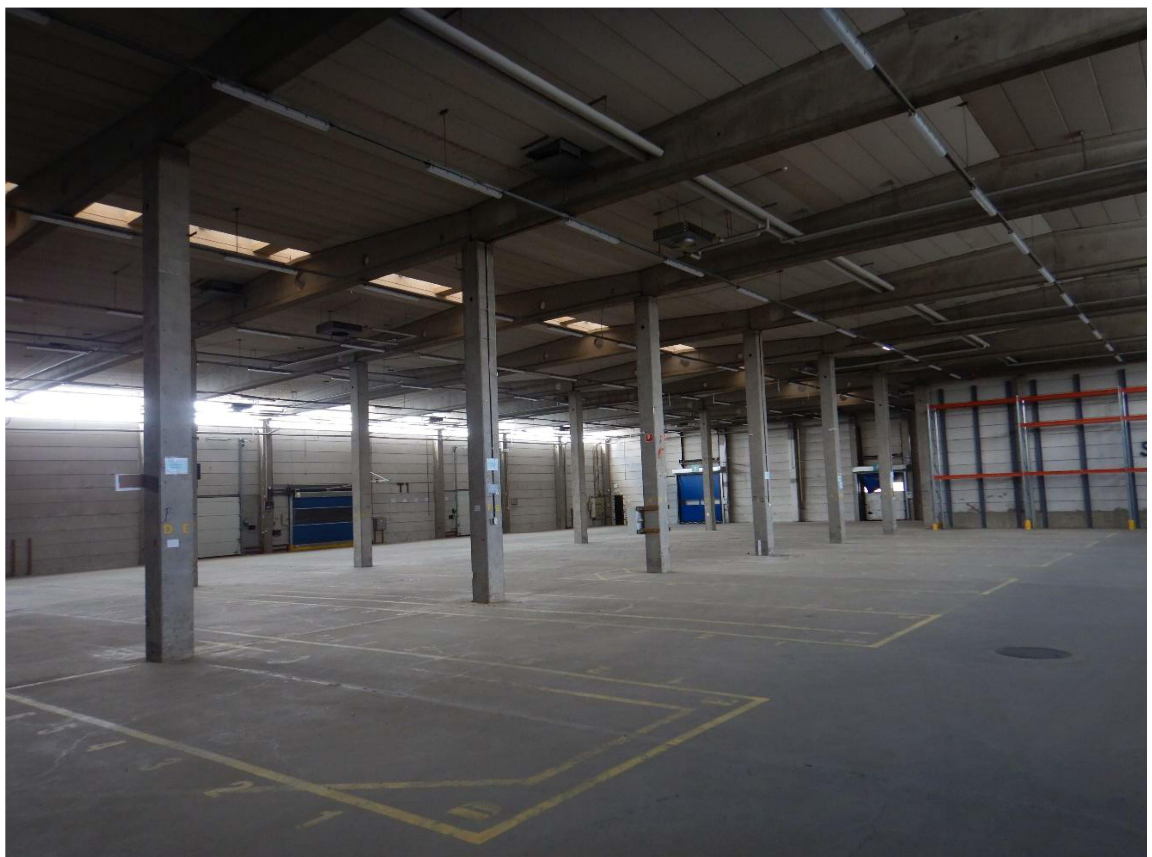
Kuva 7. Rakennus B, yleiskuva rakennuksesta.
