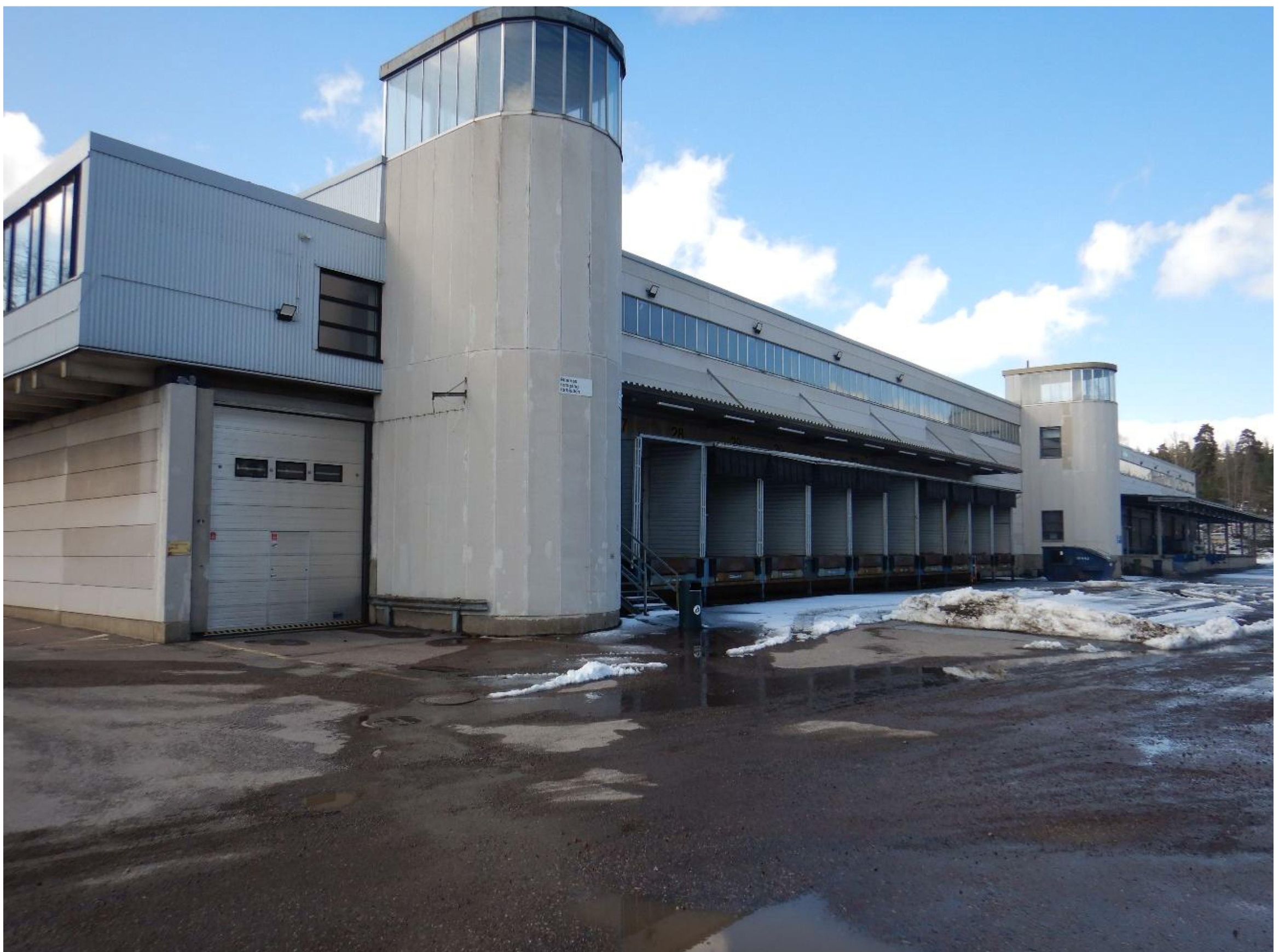
Kuva 2. Rakennus B, rakennuksen itäpuolen julkisivu.
