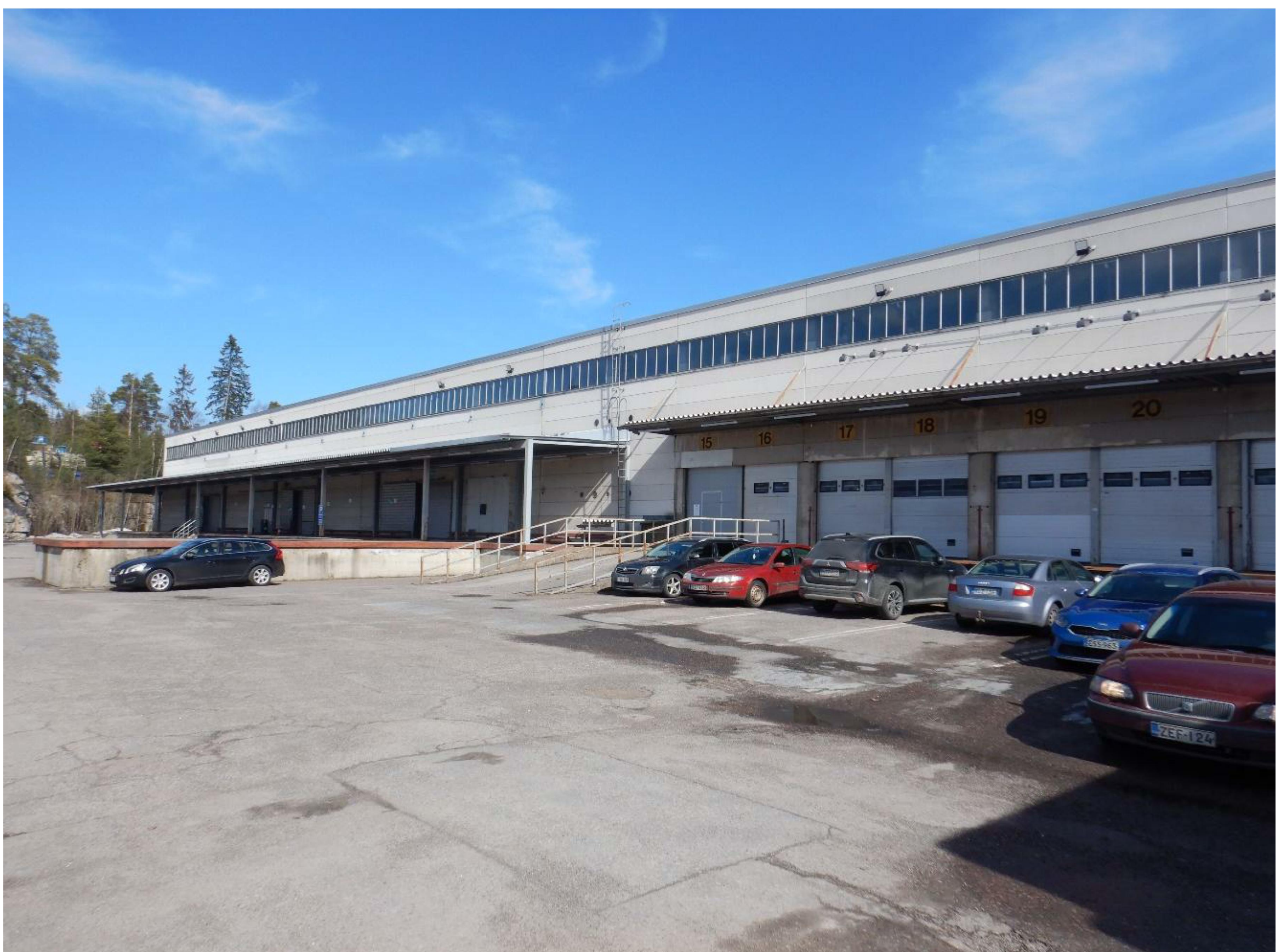
Kuva 4. Rakennus B, rakennuksen länsipuolen julkisivu.
