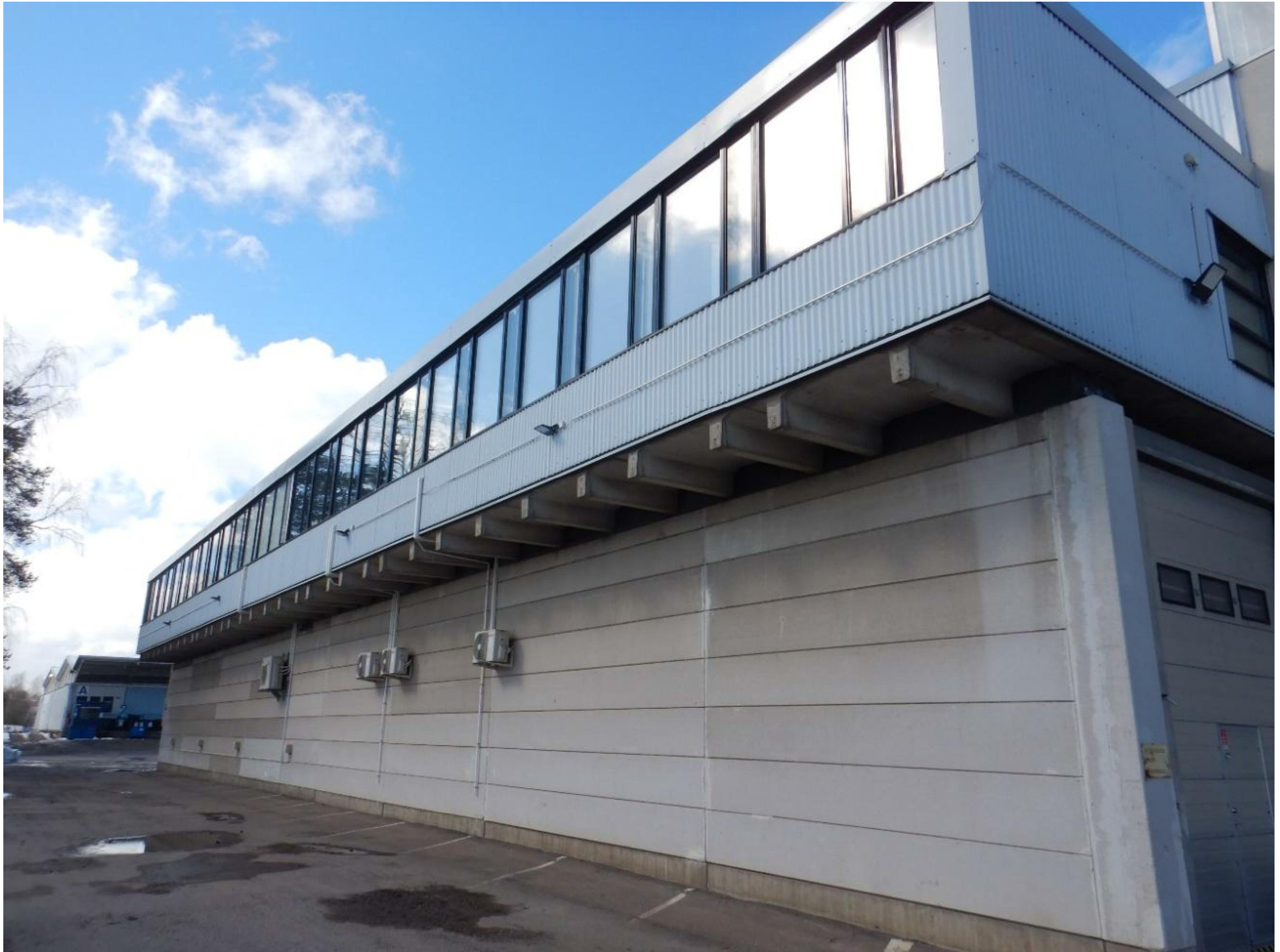
Kuva 3. Rakennus B, rakennuksen eteläpuolen julkisivu.
