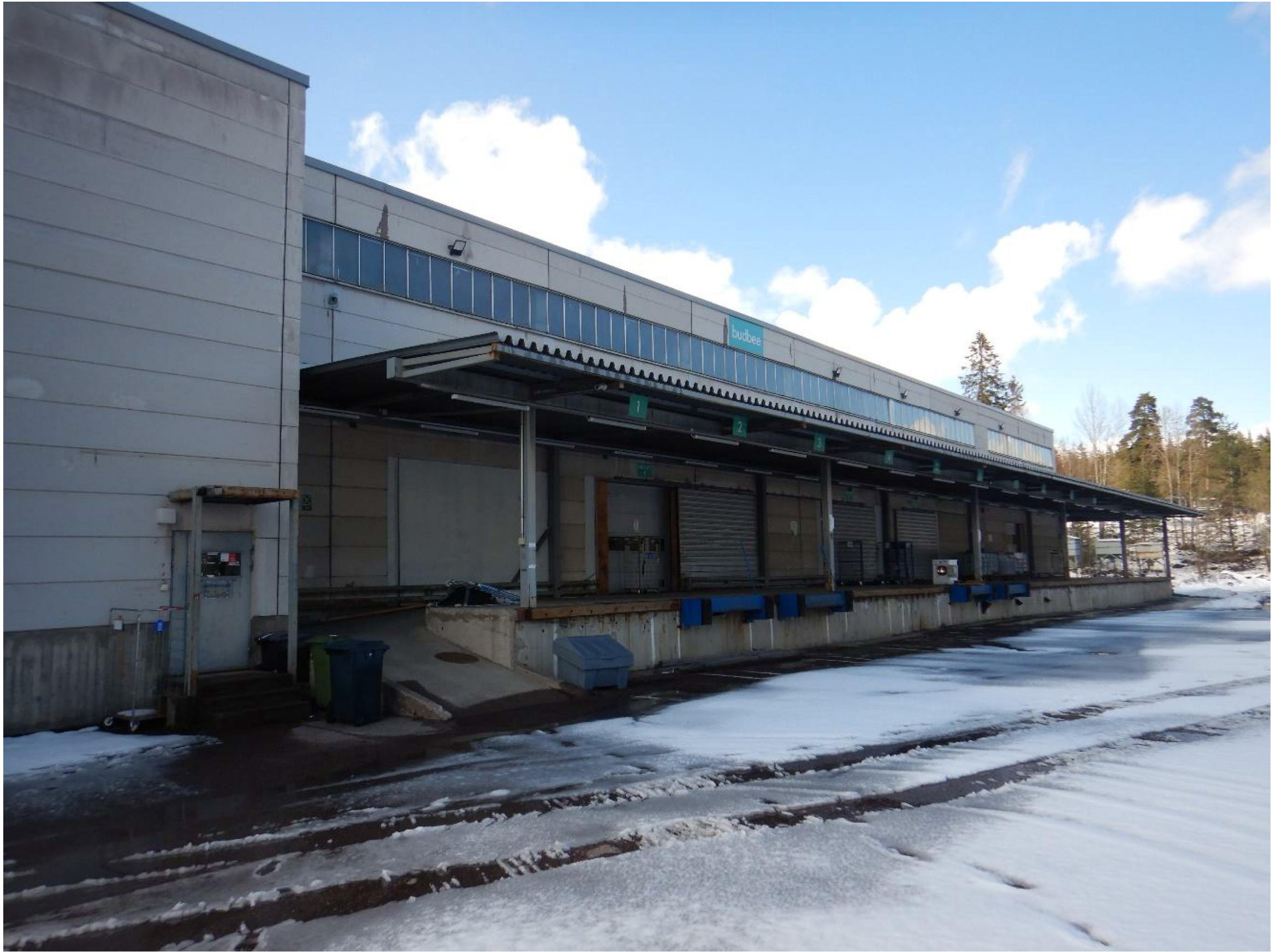
Kuva 1. Rakennus B, rakennuksen itäpuolen julkisivu.
