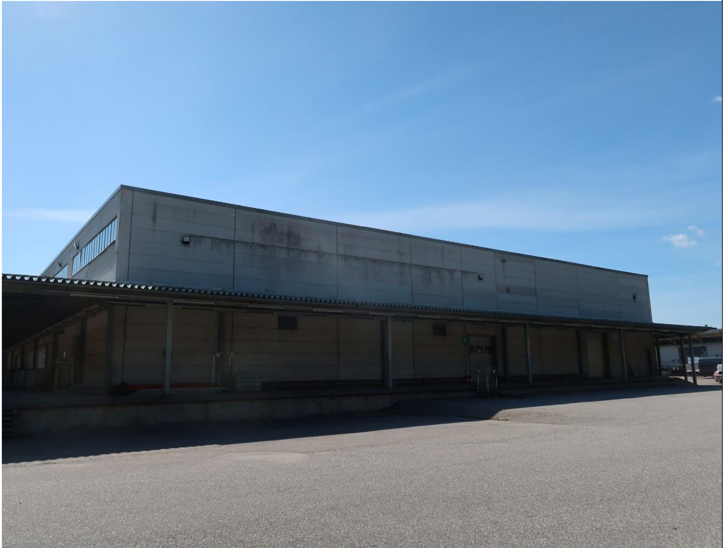
Kuva 5. Rakennus B, rakennuksen pohjoispuolen julkisivu.
