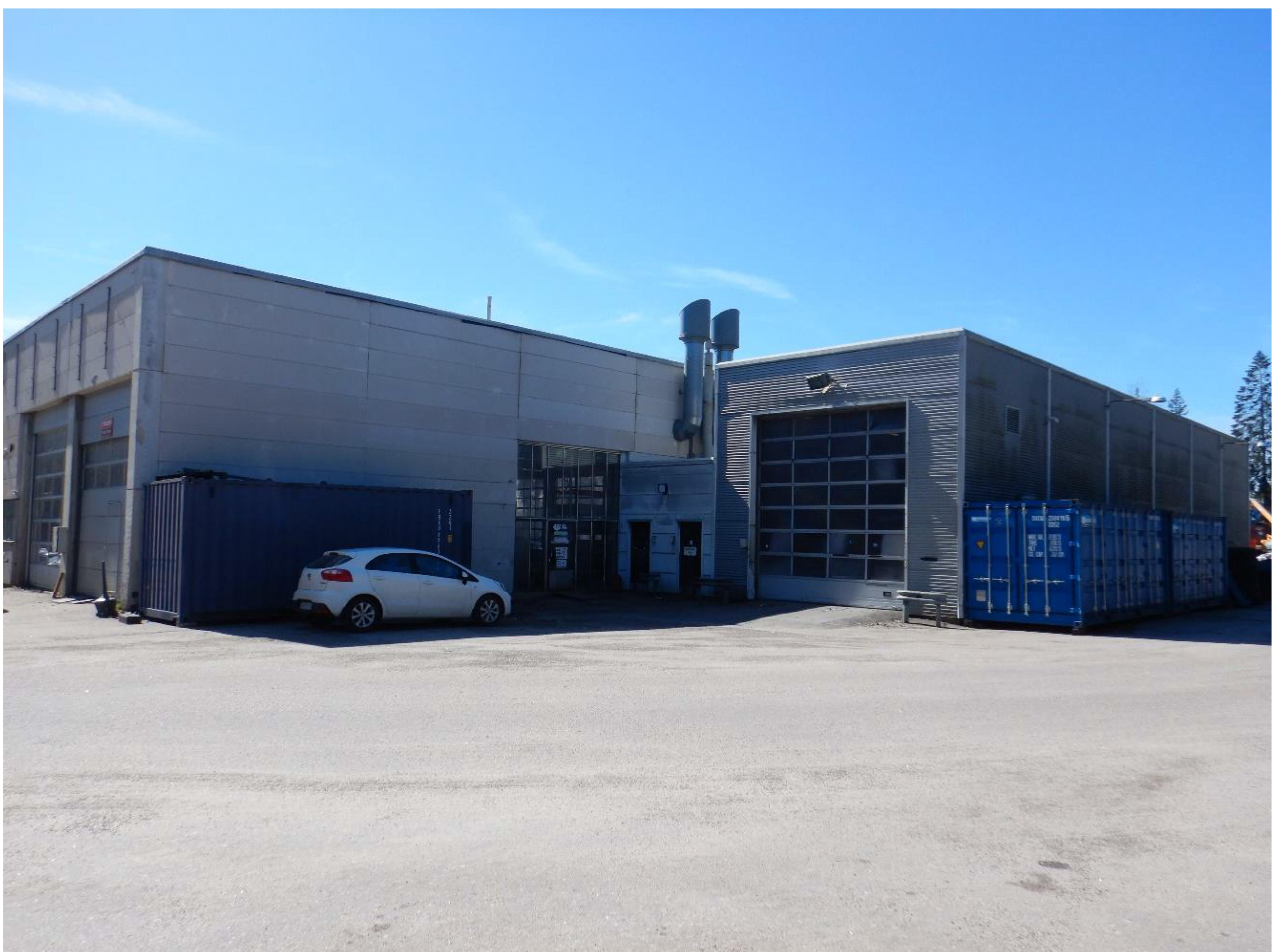
Kuva 4. Rakennus C, rakennuksen pohjoispuolen julkisivu.
