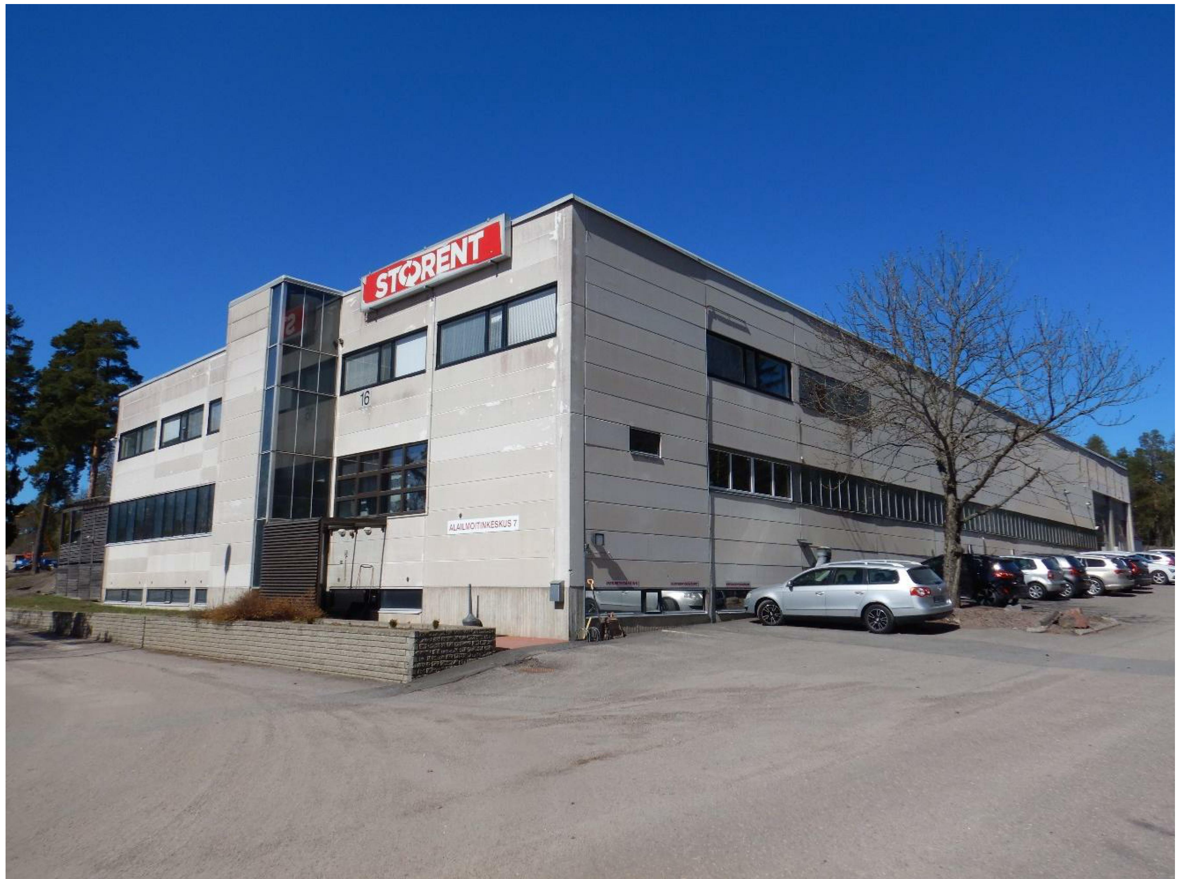
Kuva 1. Rakennus C, rakennuksen etelä- ja itäpuolen julkisivu.
