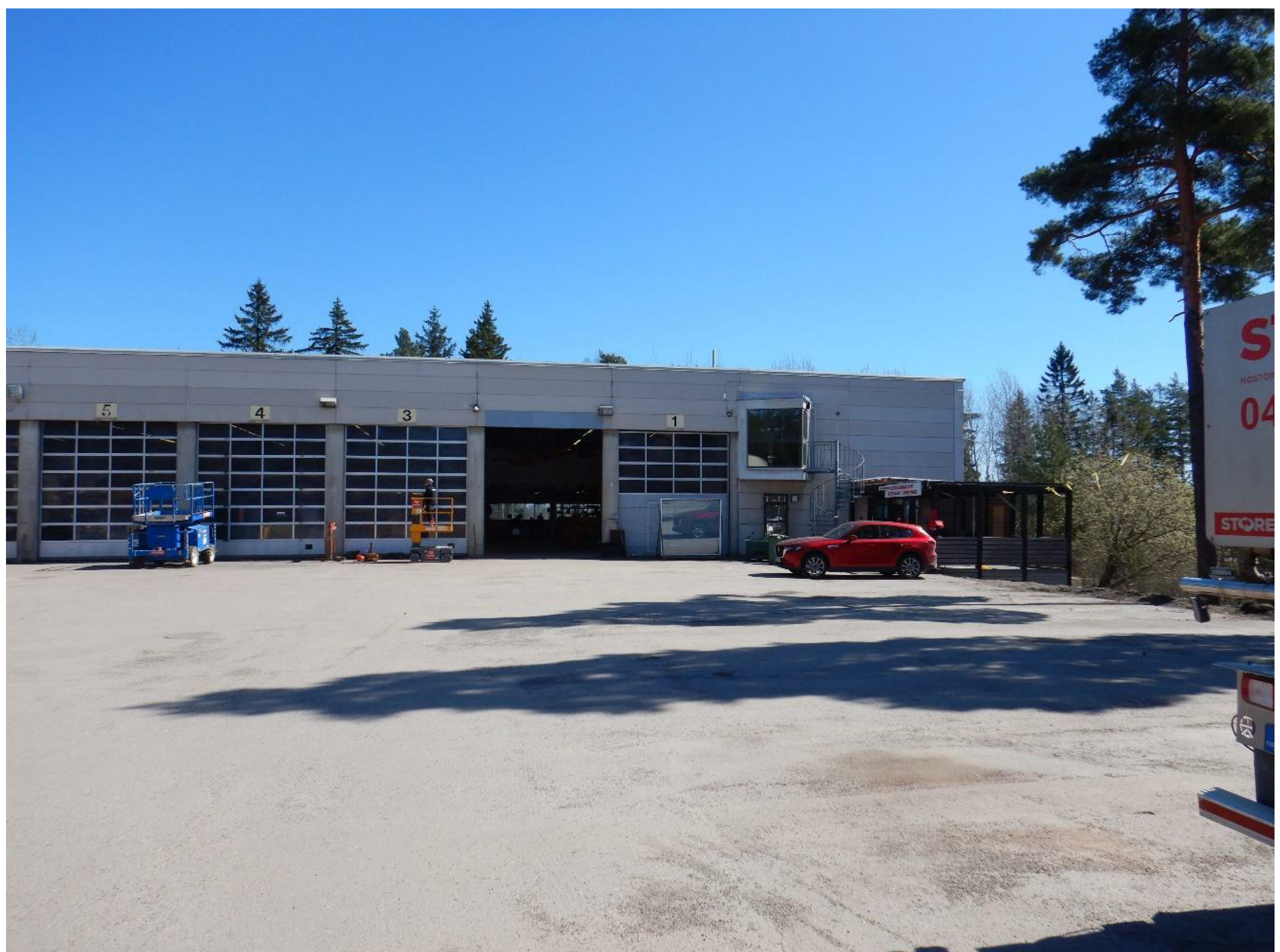
Kuva 2. Rakennus C, rakennuksen länsipuolen julkisivu.
