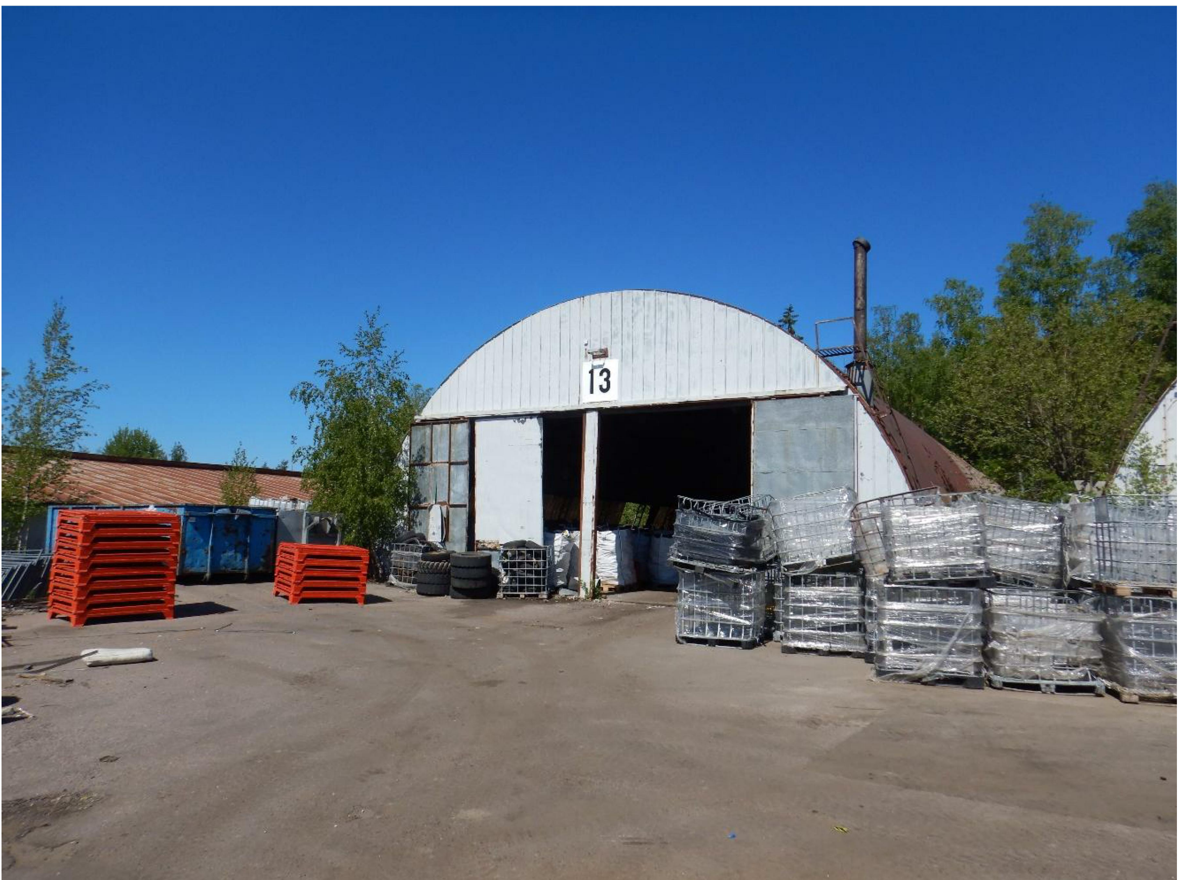
Kuva 15. Pitkä kaarihalli, rakennuksen eteläpuolen julkisivu.
