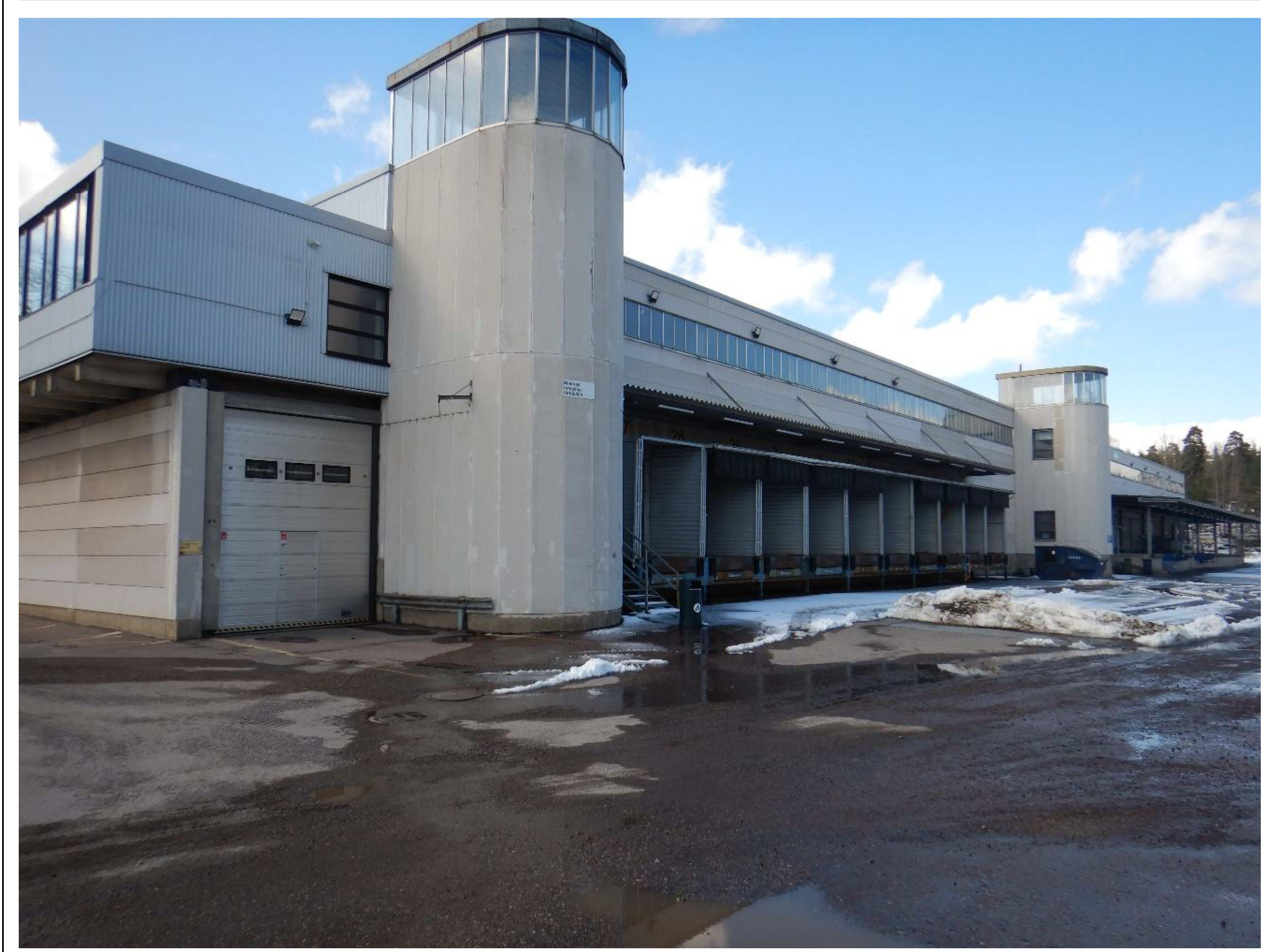
Kuva 2. Rakennus B, rakennuksen itäpuolen julkisivu.
