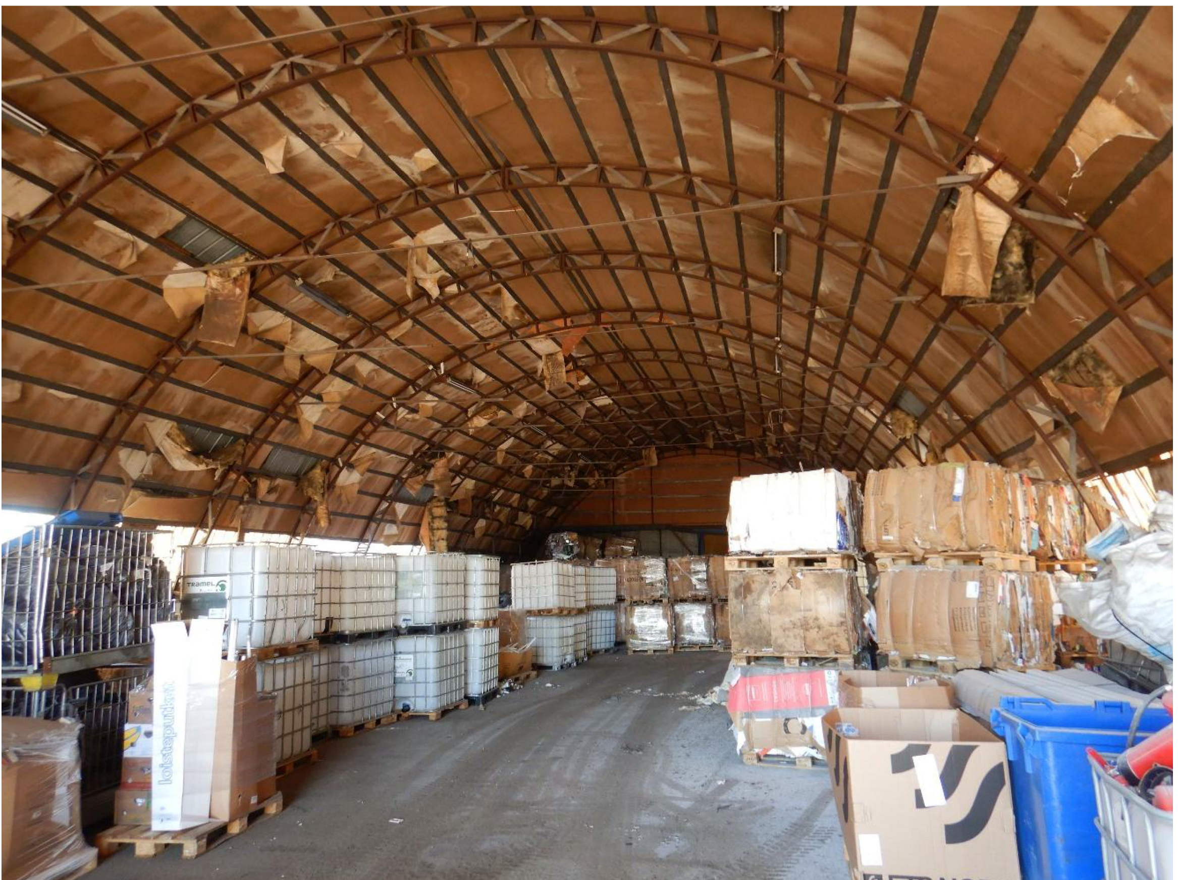
Kuva 17. Pitkä kaarihalli, yleiskuva rakennuksen sisältä.
