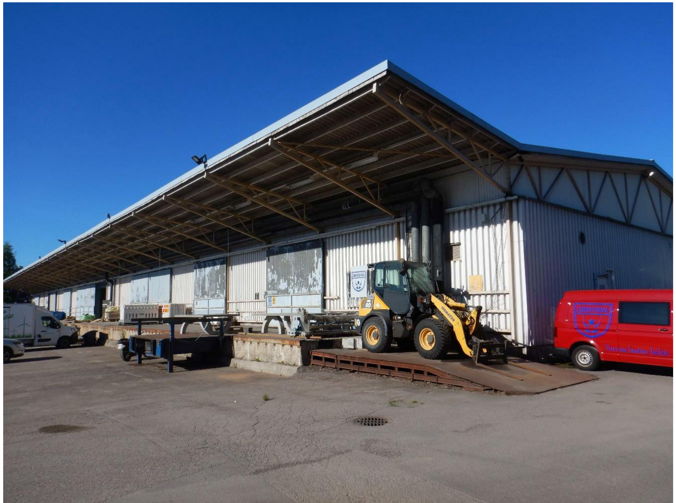
Kuva 1. Rakennus A, rakennuksen pohjois- ja itäpuolen julkisivu.
