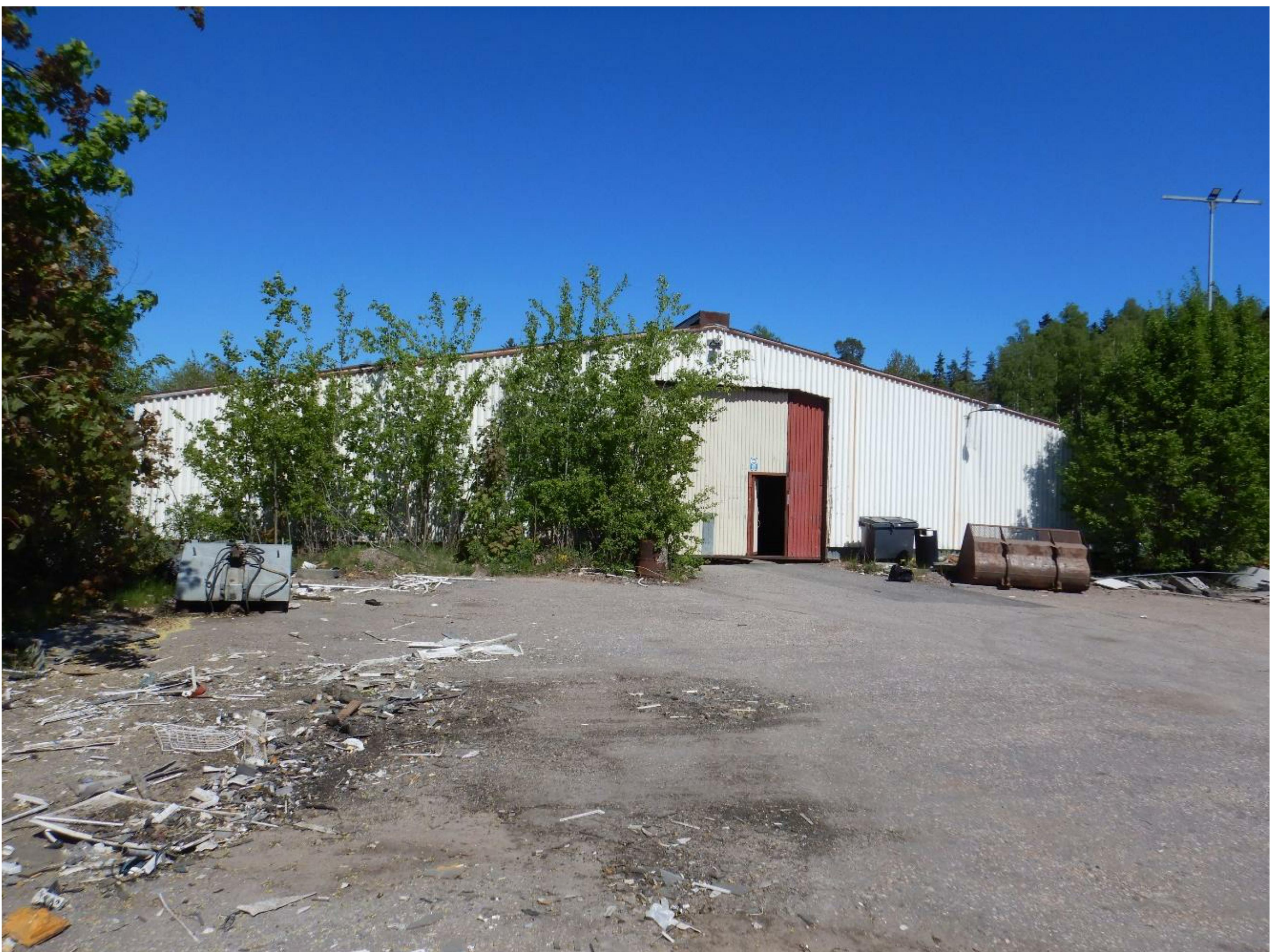
Kuva 13. Peltihalli, rakennuksen eteläpuolen julkisivu.
