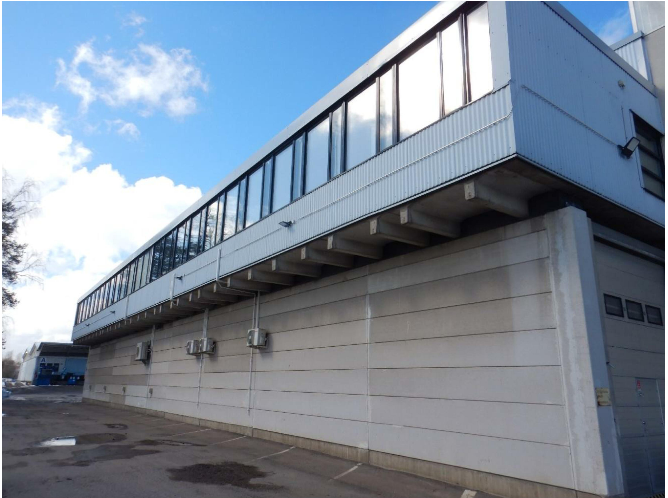
Kuva 3. Rakennus B, rakennuksen eteläpuolen julkisivu.
