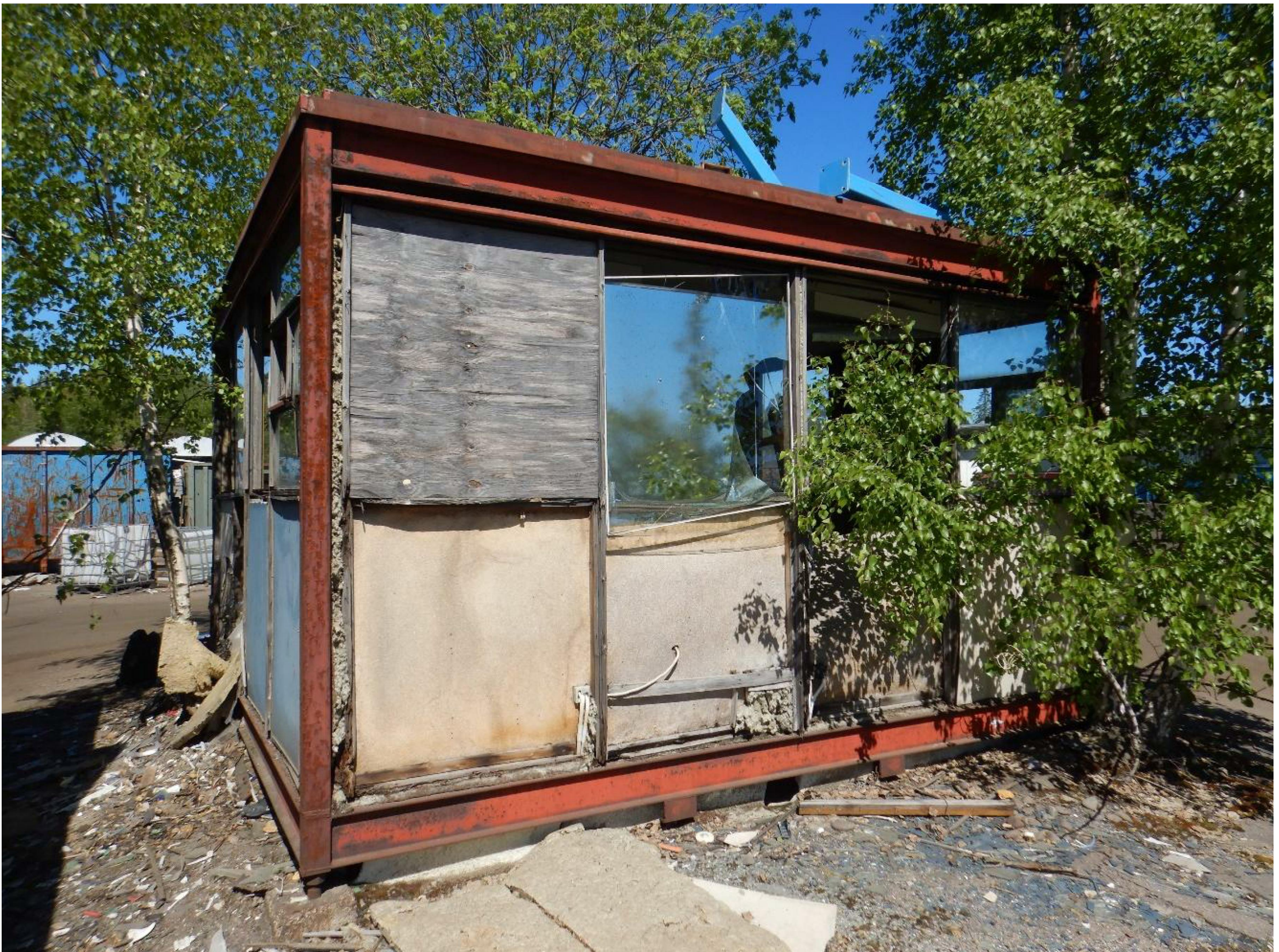
Kuva 23. Porttivartijan rakennus, rakennuksen etelä- ja länsipuolen julkisivu.
