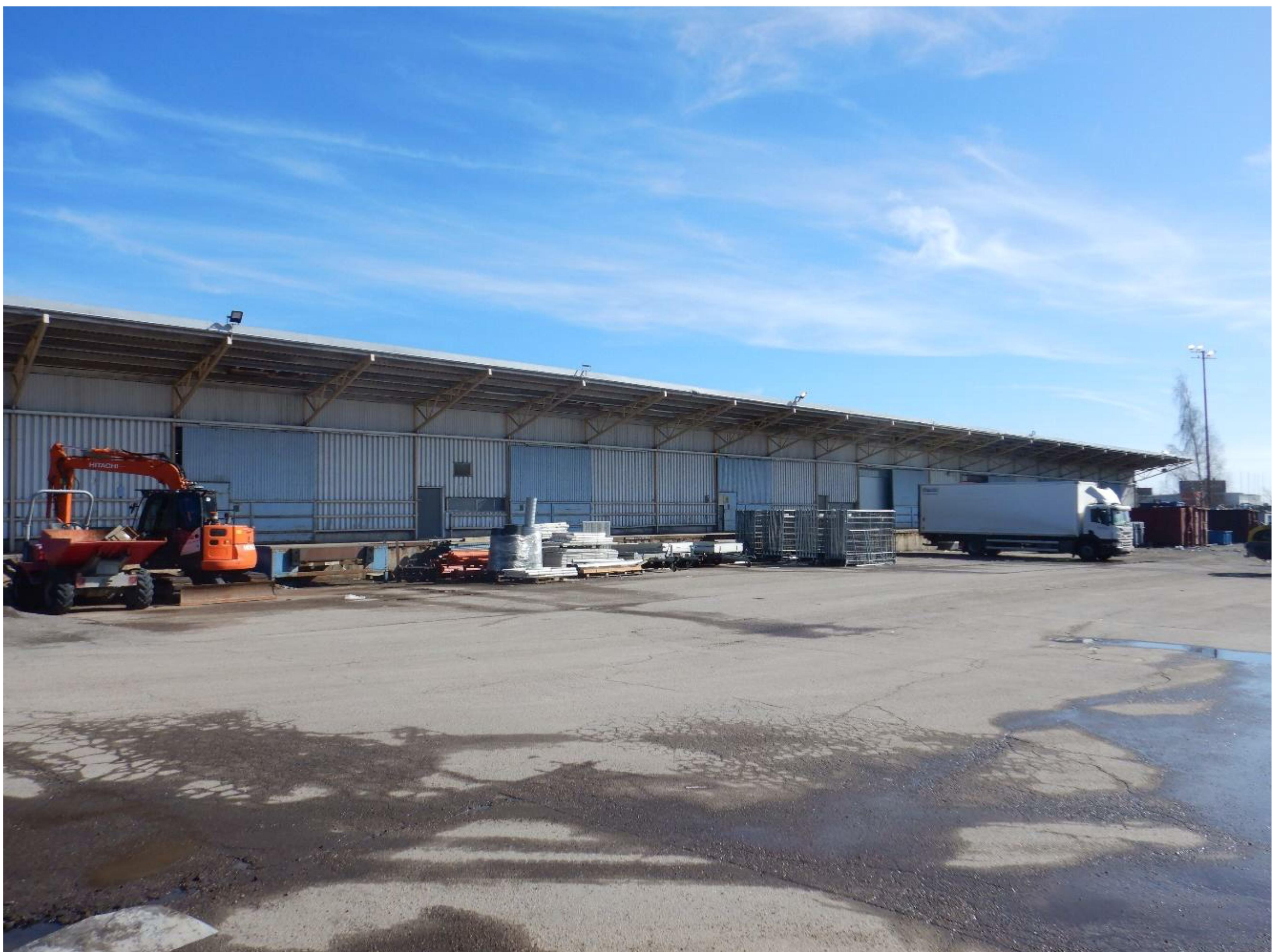
Kuva 4. Rakennus A, rakennuksen länsipuolen julkisivu.
