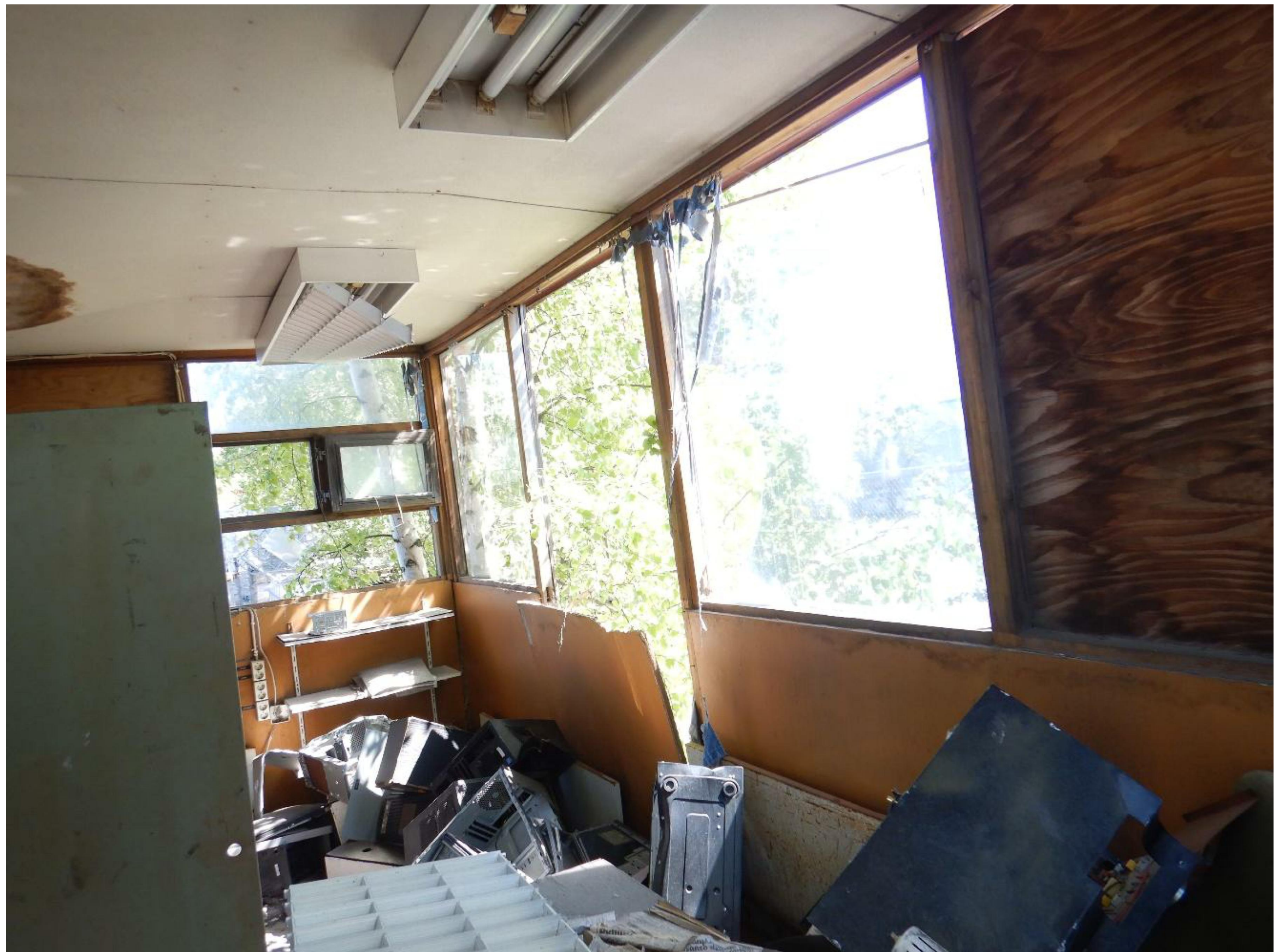
Kuva 24. Porttivartijan rakennus, yleiskuva rakennuksen sisältä.
