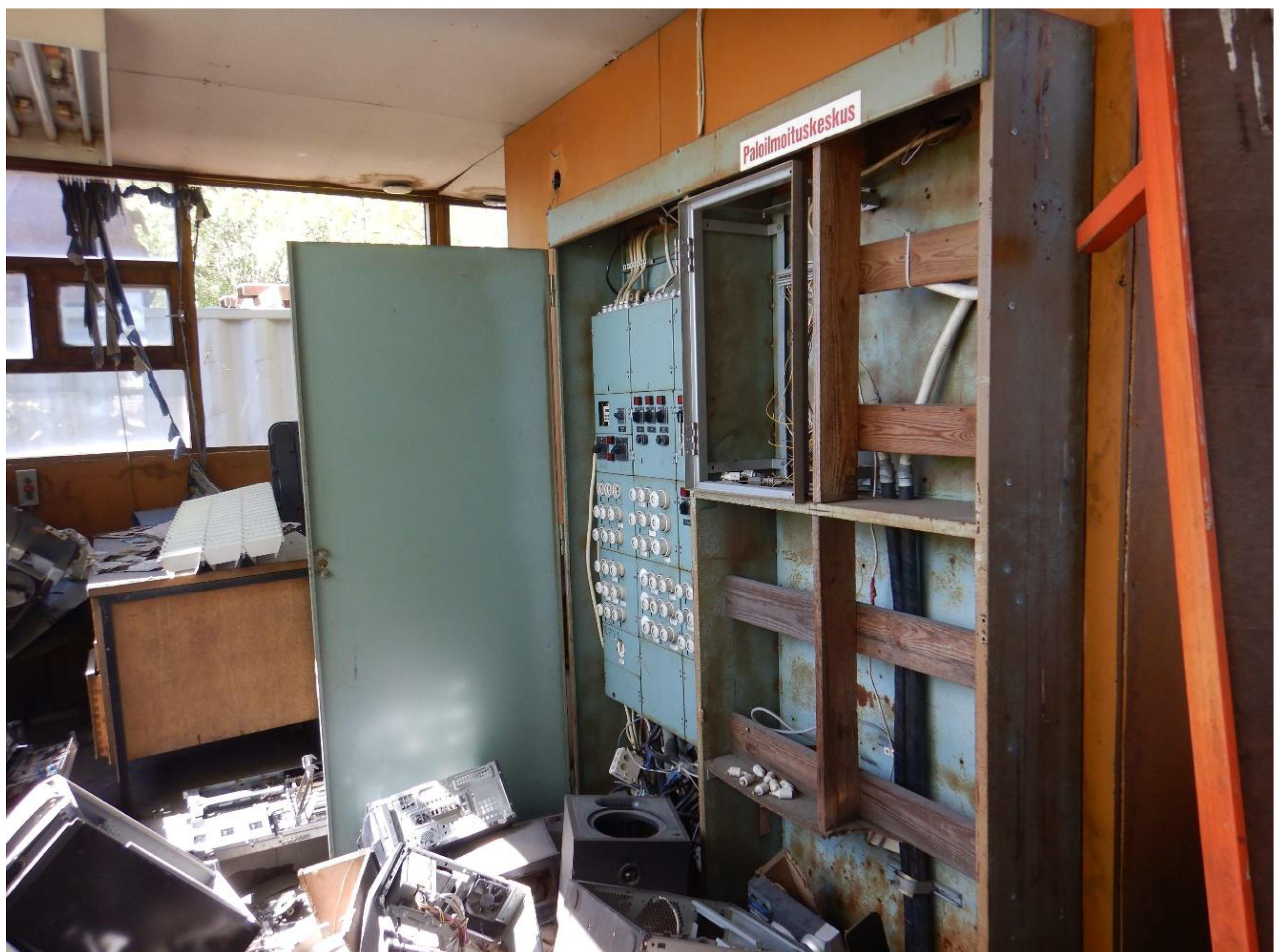
Kuva 25. Porttivartijan rakennus, yleiskuva rakennuksen sisältä.
