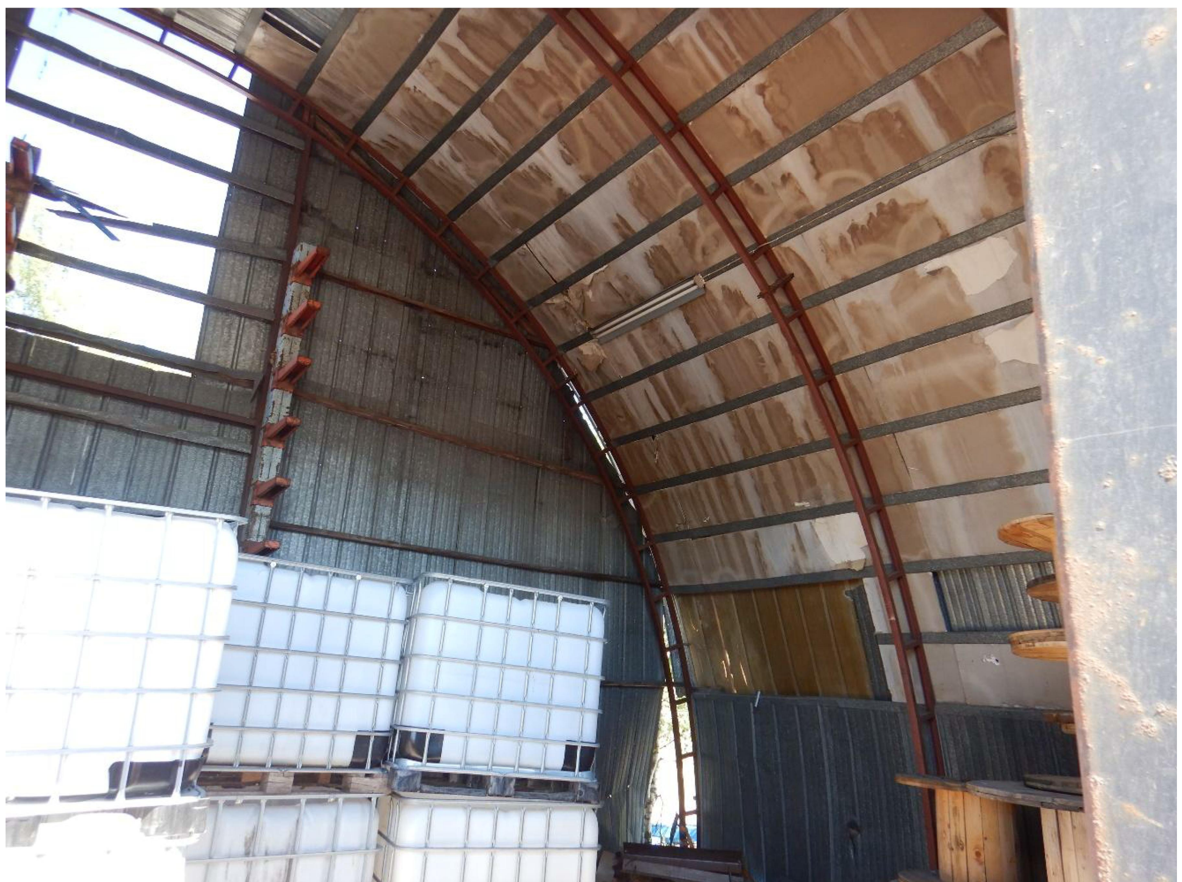
Kuva 21. Lyhyt kaarihalli, yleiskuva rakennuksen sisältä.
