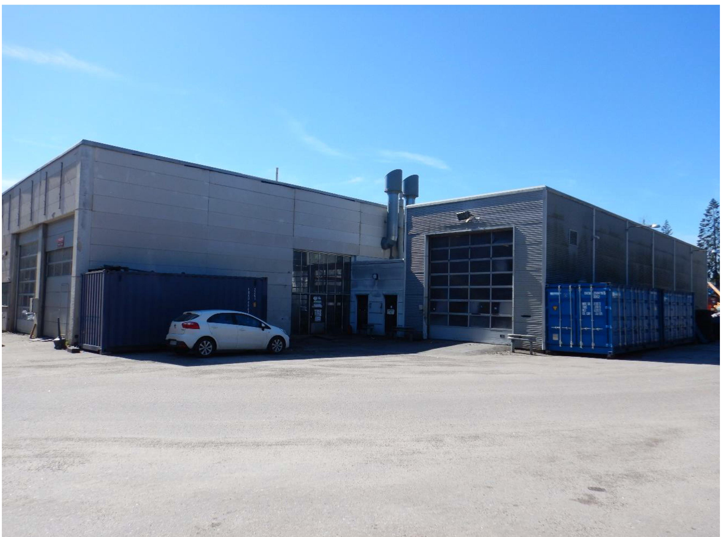
Kuva 4. Rakennus C, rakennuksen pohjoispuolen julkisivu.
