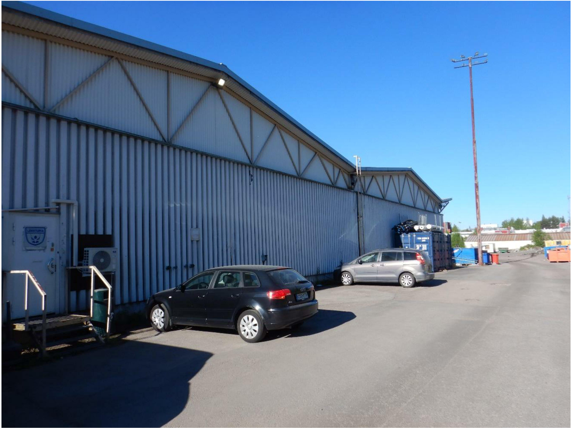
Kuva 3. Rakennus A, rakennuksen pohjoispuolen julkisivu.
