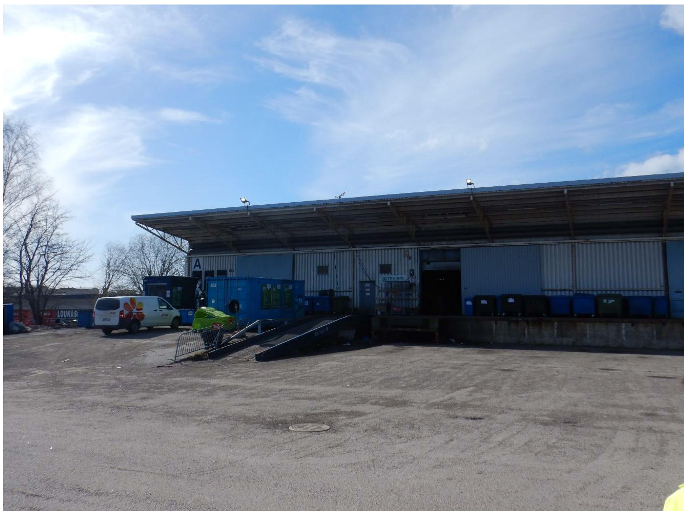
Kuva 2. Rakennus A, rakennuksen itäpuolen julkisivu.
