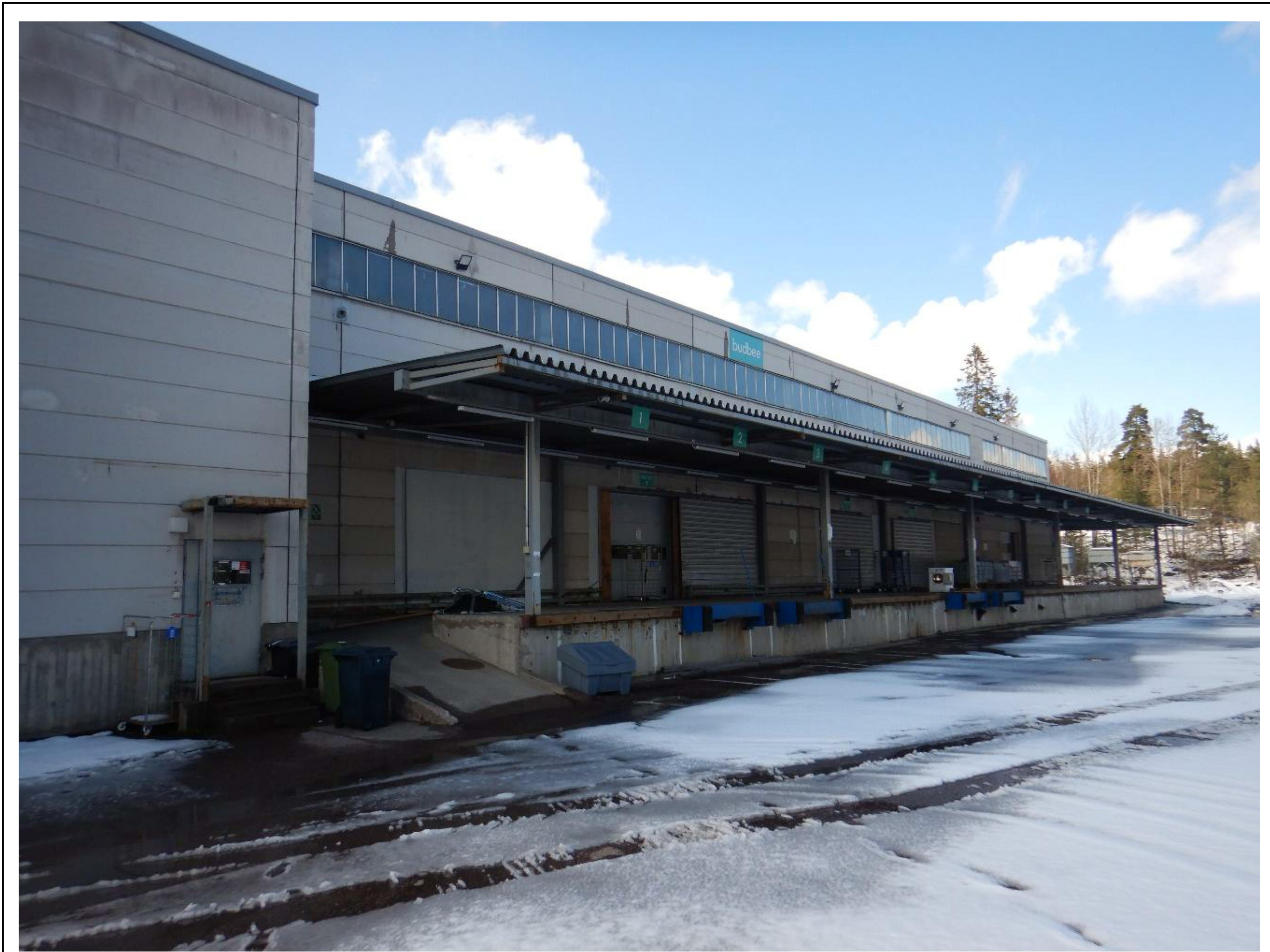
Kuva 1. Rakennus B, rakennuksen itäpuolen julkisivu.
