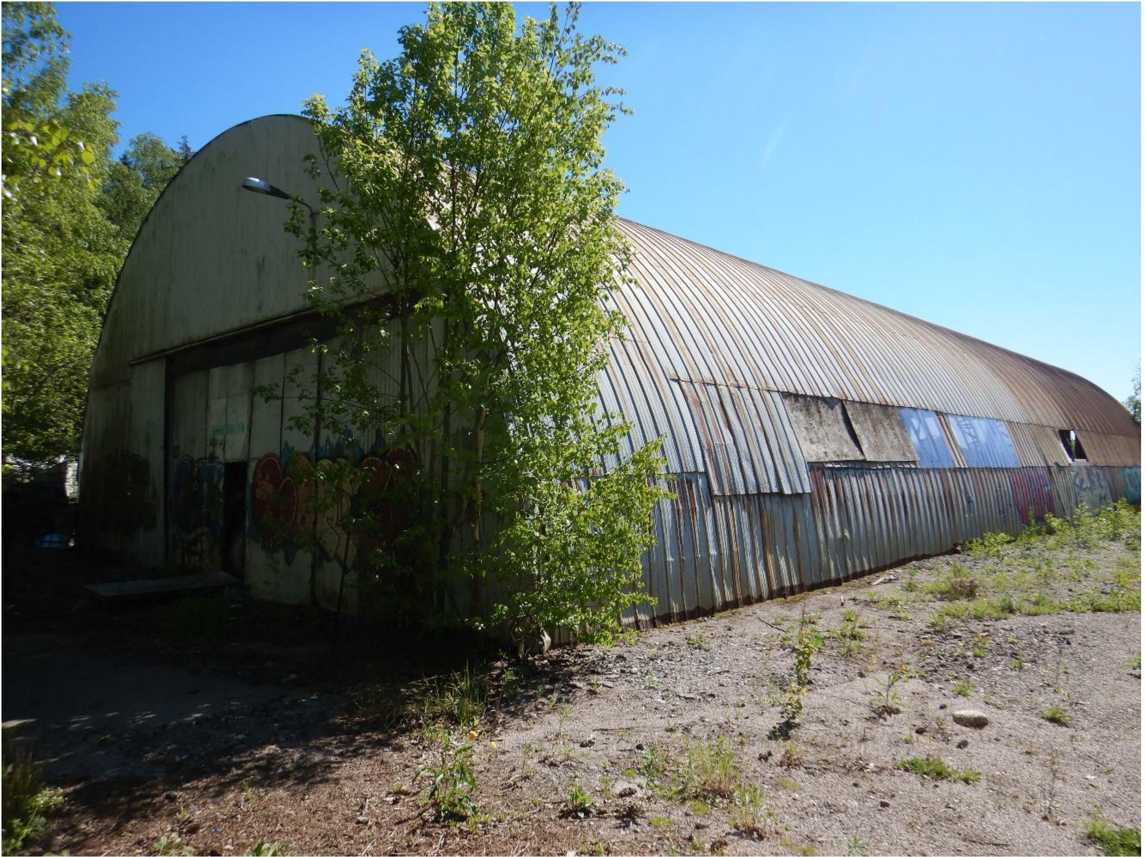
Kuva 16. Pitkä kaarihalli, rakennuksen pohjois- ja länsipuolen julkisivu.
