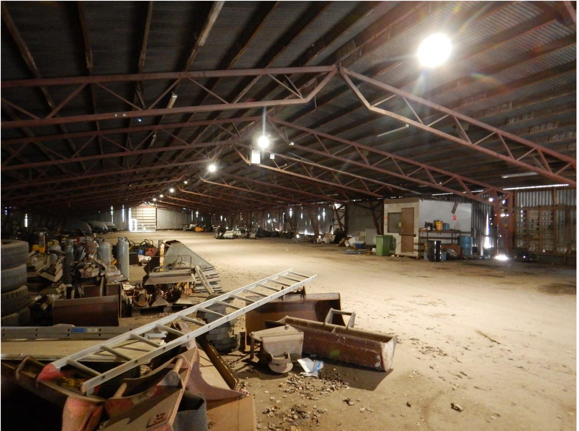
Kuva 14. Peltihalli, yleiskuva rakennuksen sisältä.
