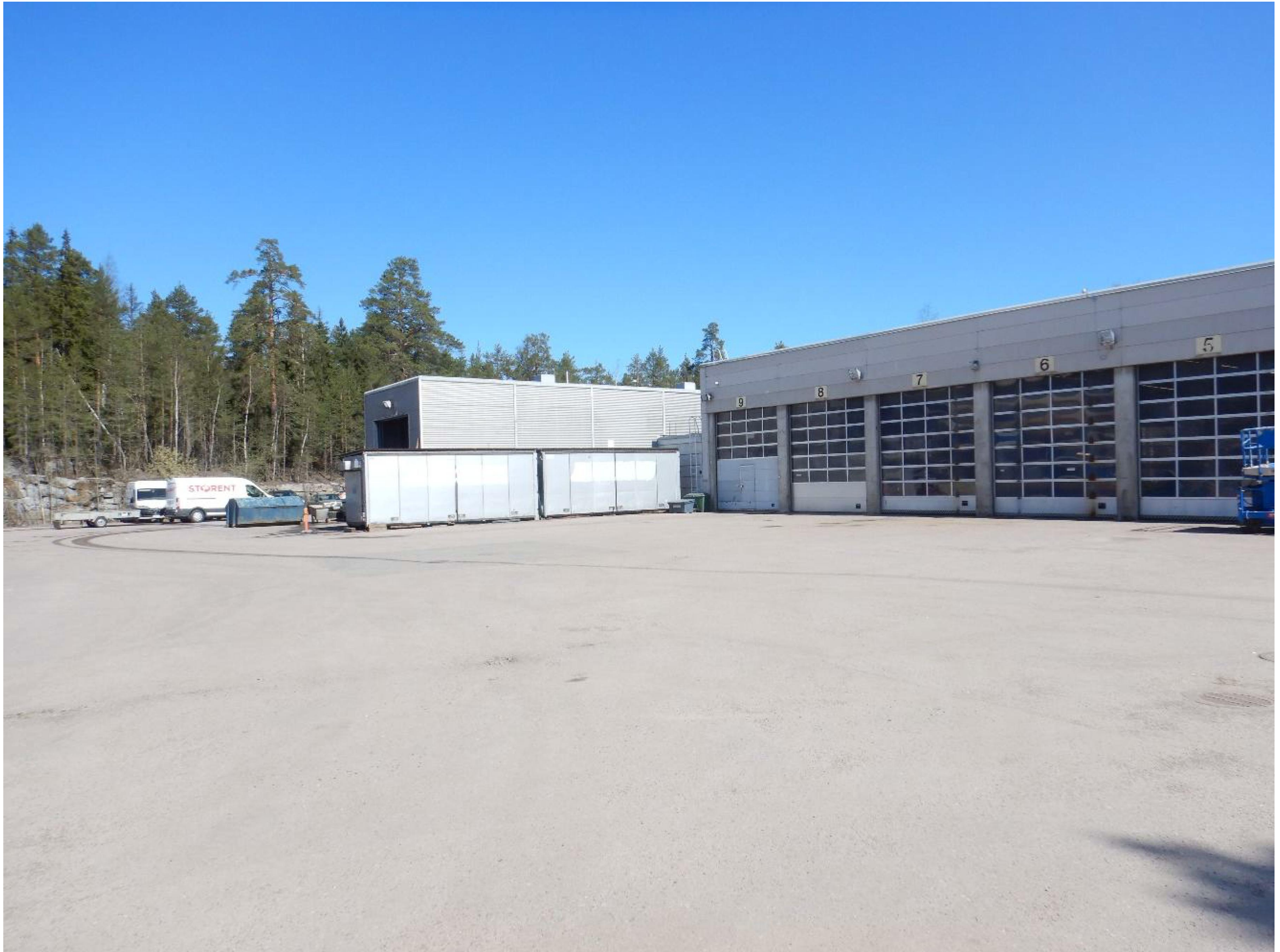
Kuva 3. Rakennus C, rakennuksen länsipuolen julkisivu.
