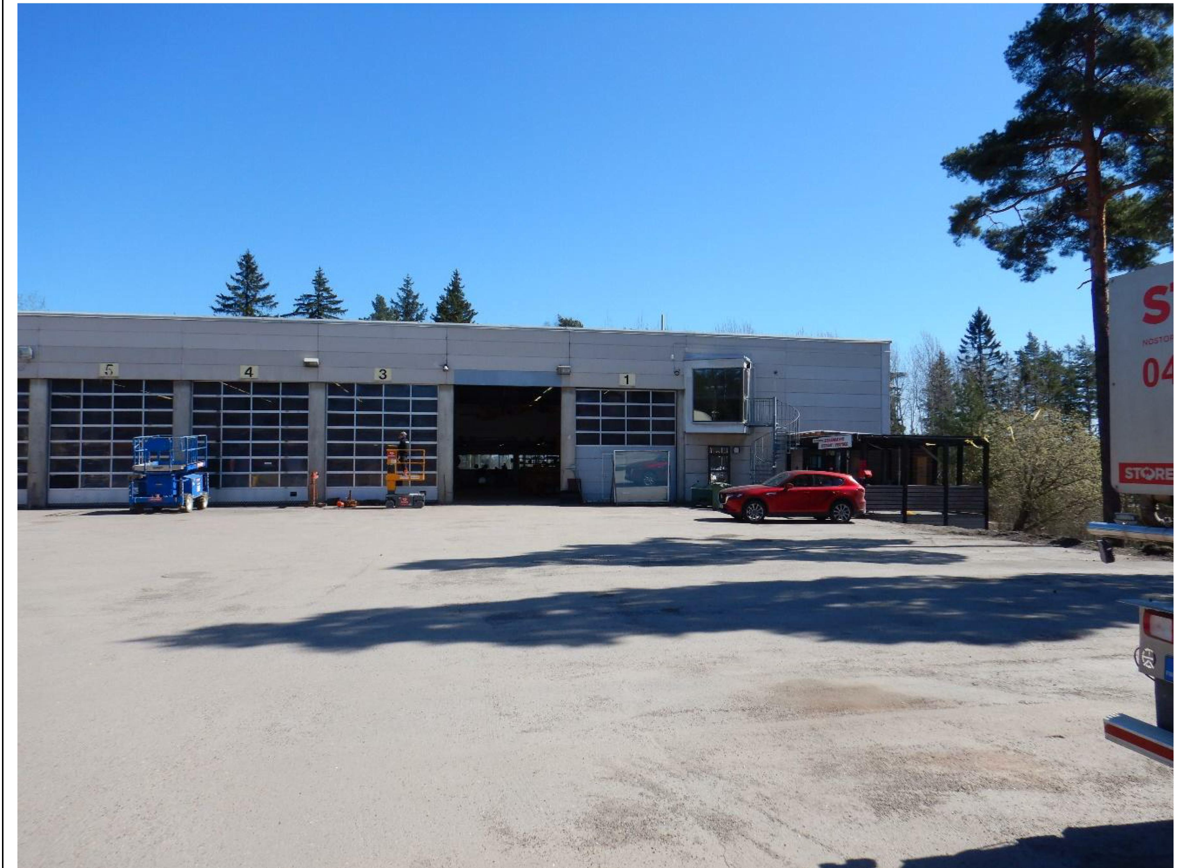
Kuva 2. Rakennus C, rakennuksen länsipuolen julkisivu.
