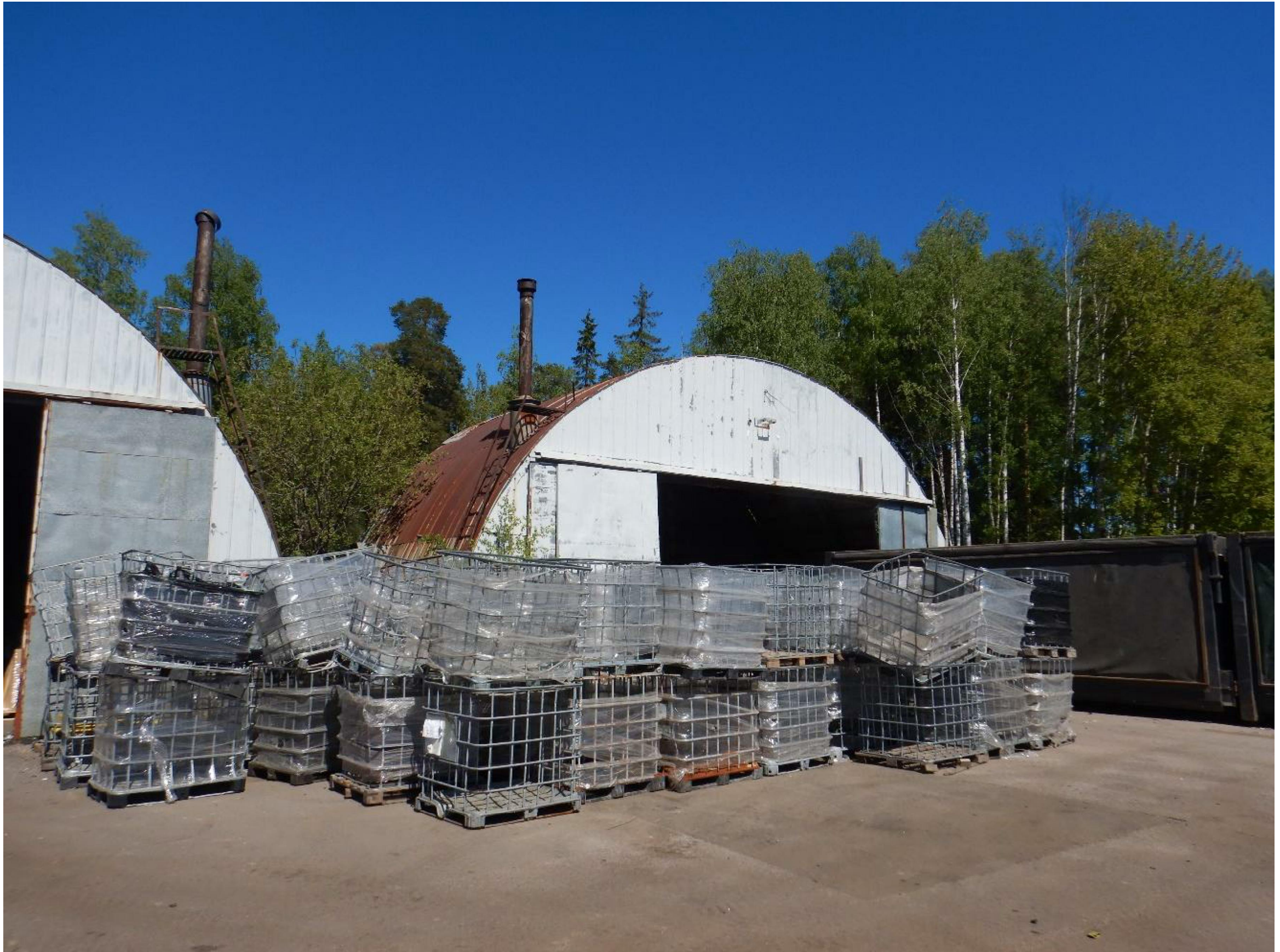
Kuva 18. Lyhyt kaarihalli, rakennuksen etelä- ja länsipuolen julkisivu.
