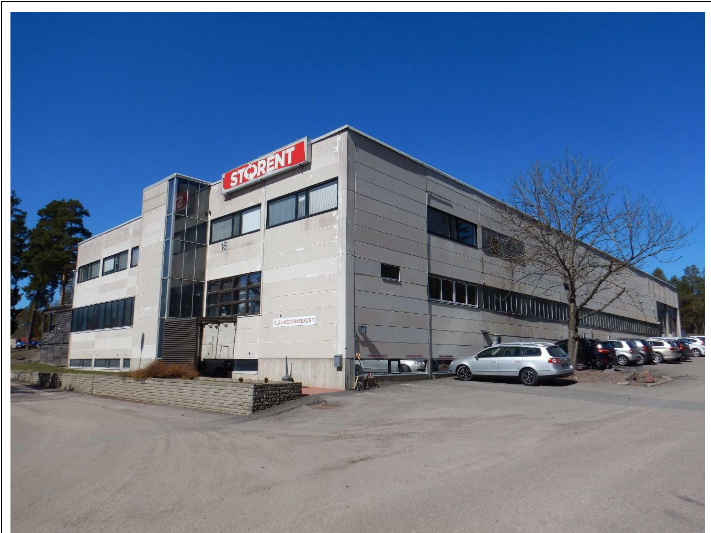
Kuva 1. Rakennus C, rakennuksen etelä- ja itäpuolen julkisivu.
