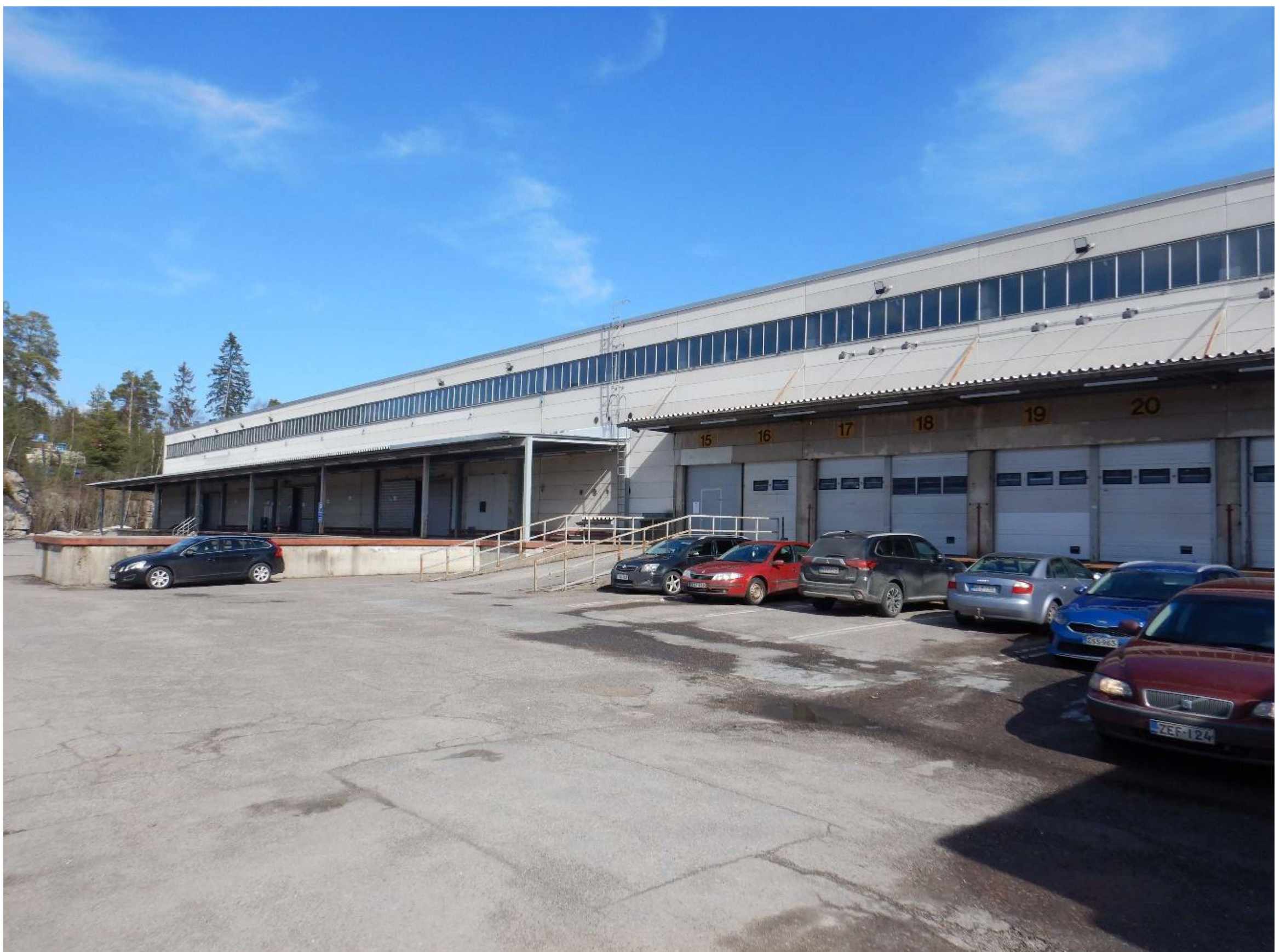
Kuva 4. Rakennus B, rakennuksen länsipuolen julkisivu.
