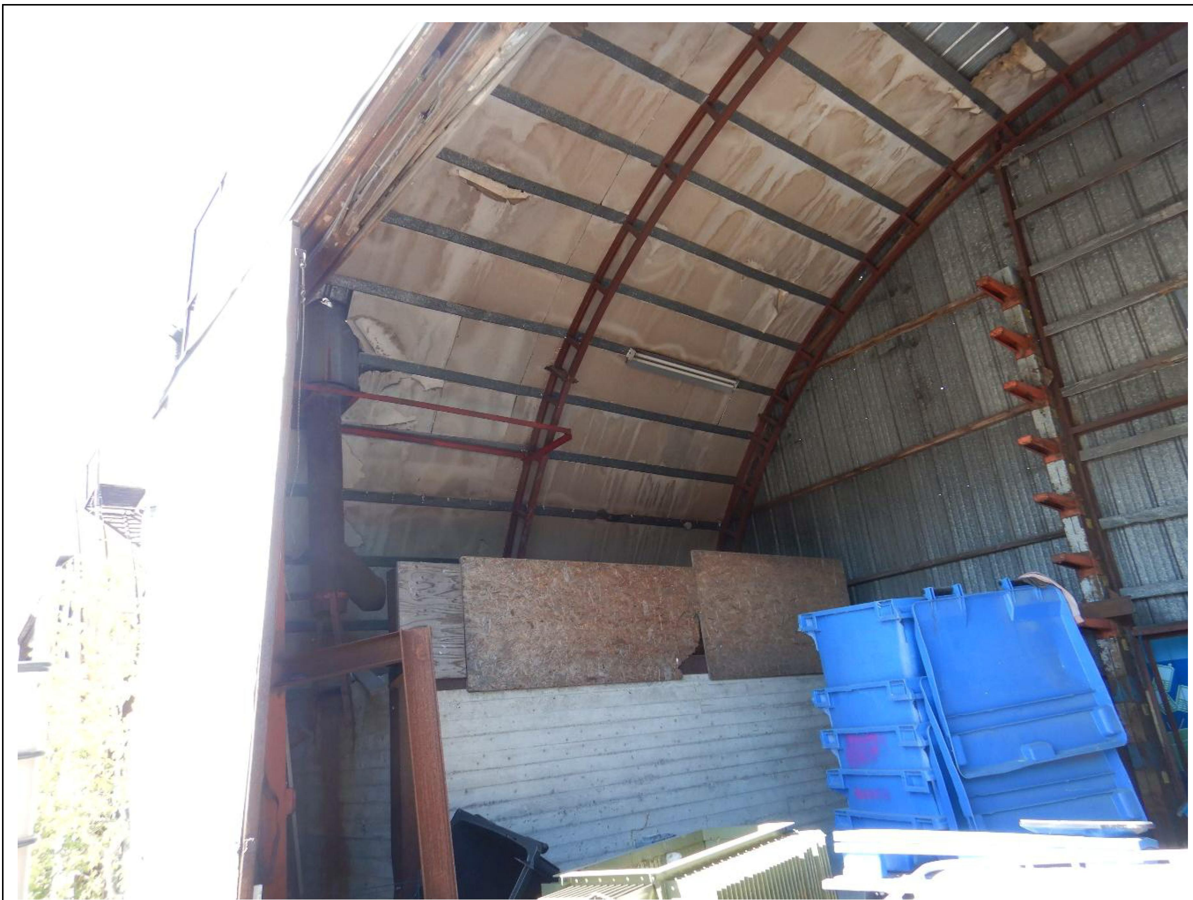
Kuva 20. Lyhyt kaarihalli, yleiskuva rakennuksen sisältä.
