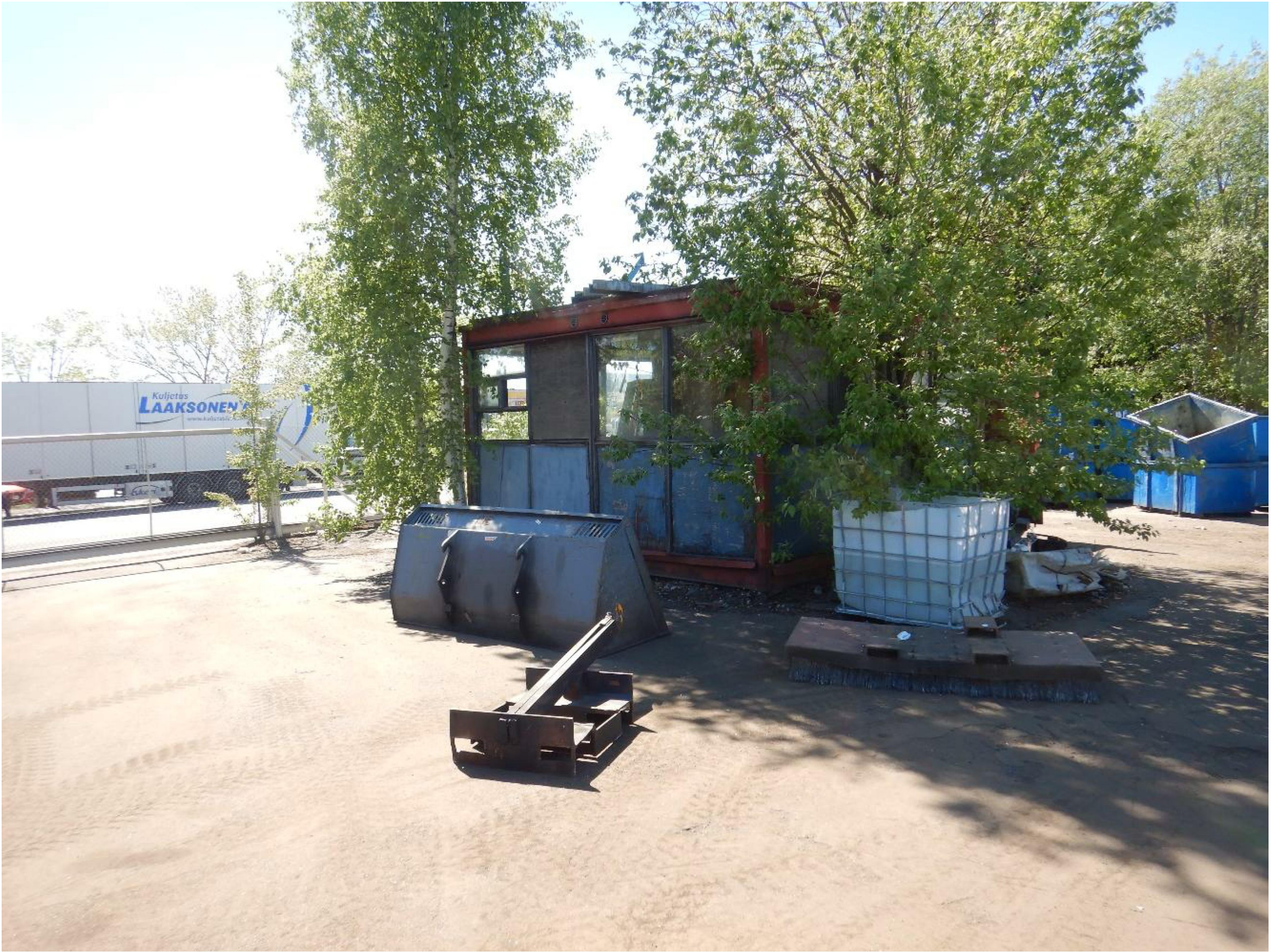
Kuva 22. Porttivartijan rakennus, rakennuksen pohjois- ja itäpuolen julkisivu.
