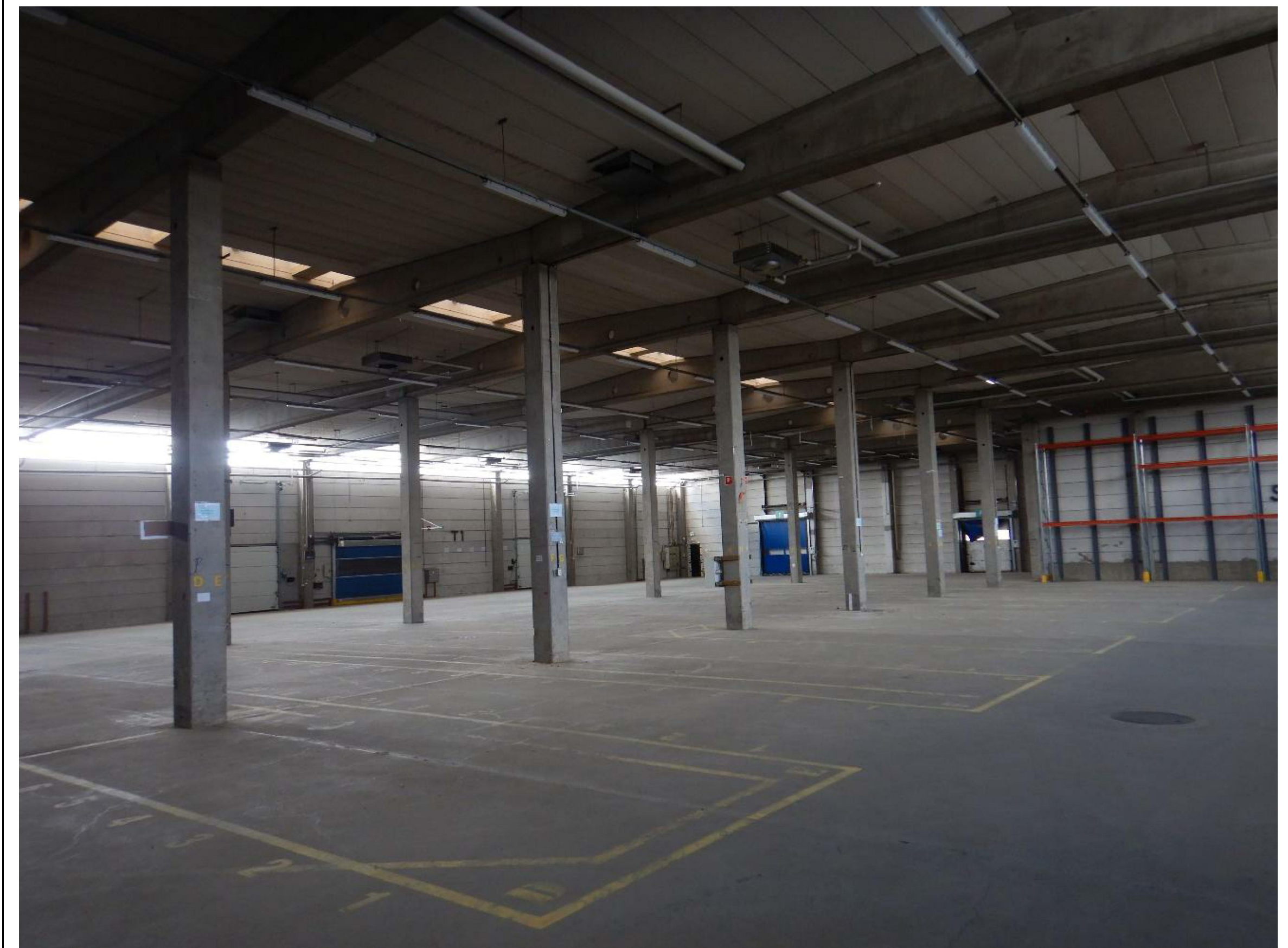
Kuva 7. Rakennus B, yleiskuva rakennuksesta.
