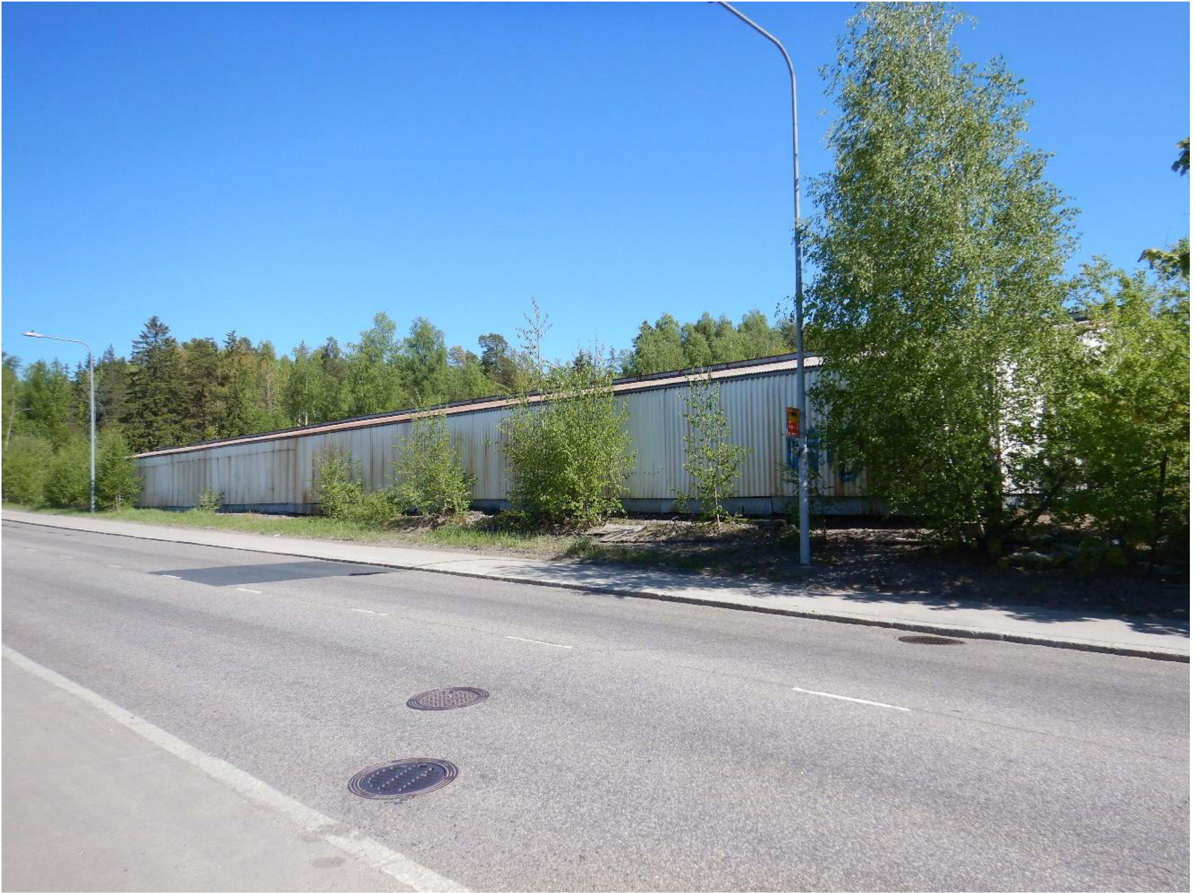
Kuva 12. Peltihalli, rakennuksen länsipuolen julkisivu.
