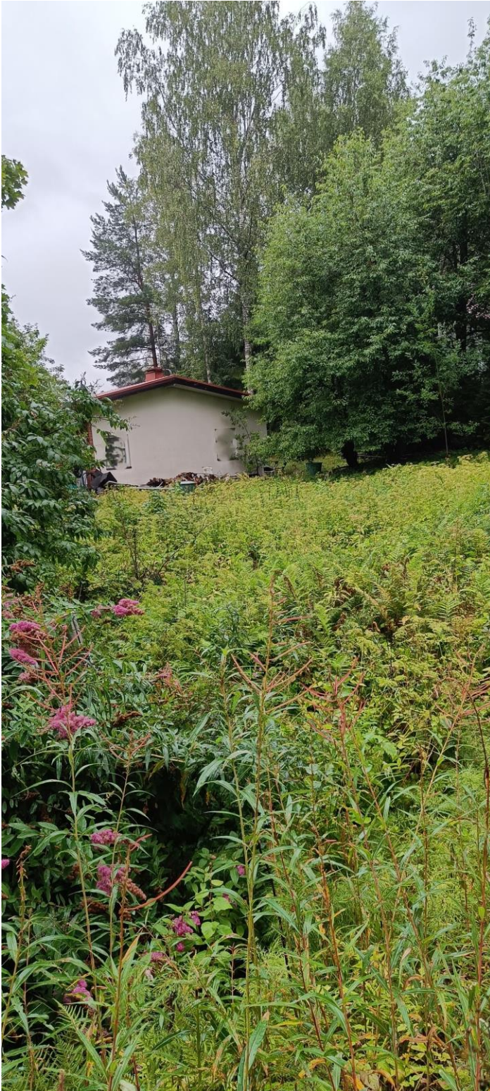
Kuva 3. Rakennuksen nurkalle asetettu saavi puun alla (2.8.2023). Maanpinta viettää naapurikiinteistön suuntaan.
