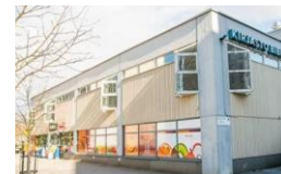
7. Pallastunturintien Liikekiinteistö Oy 1977
