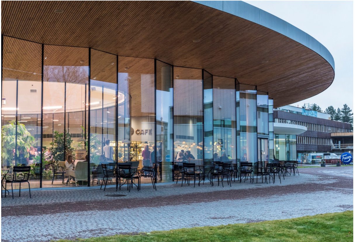
Kuva 5. Fazer Experience Visitor Center. Copyright: Sakari Manninen, Vantaan kaupunki 24.11.2016
