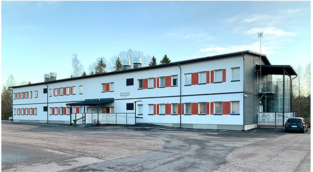
Purettava Varian tilapäinen paviljonki. Sähköosasto.
