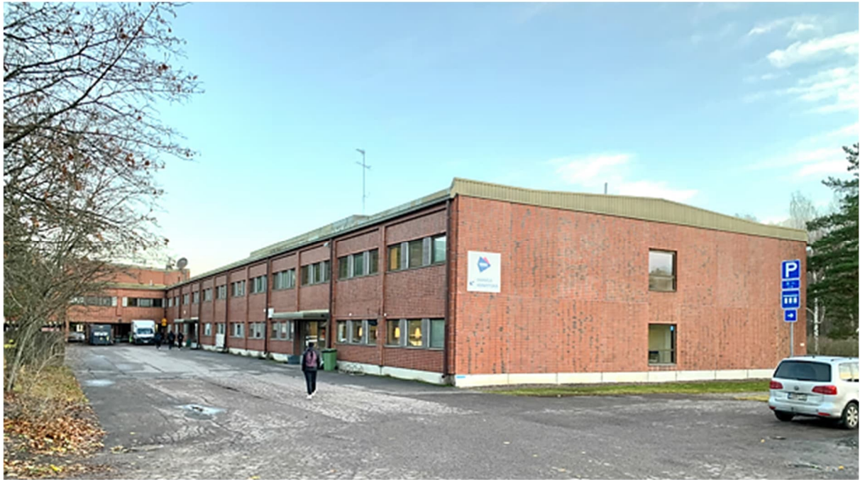
Varian eteläpääty. Huoltopiha ja pääasiallinen sisään kulku.
