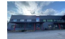
15. KOy Vantaan Helikopteritukikohta 2009
