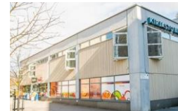
7. Pallastunturintien Liikekiinteistö Oy 1977
