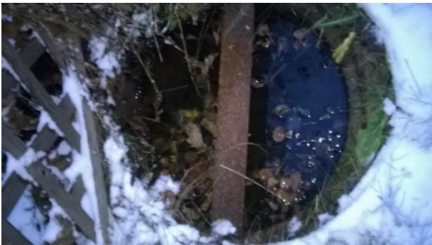
Kuva 1. [REDACTED]:n tontin pohjoisin hulevesilinjan tarkastuskaivo.
