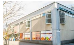
6. Pallastunturintien Liikekiinteistö Oy 1977
