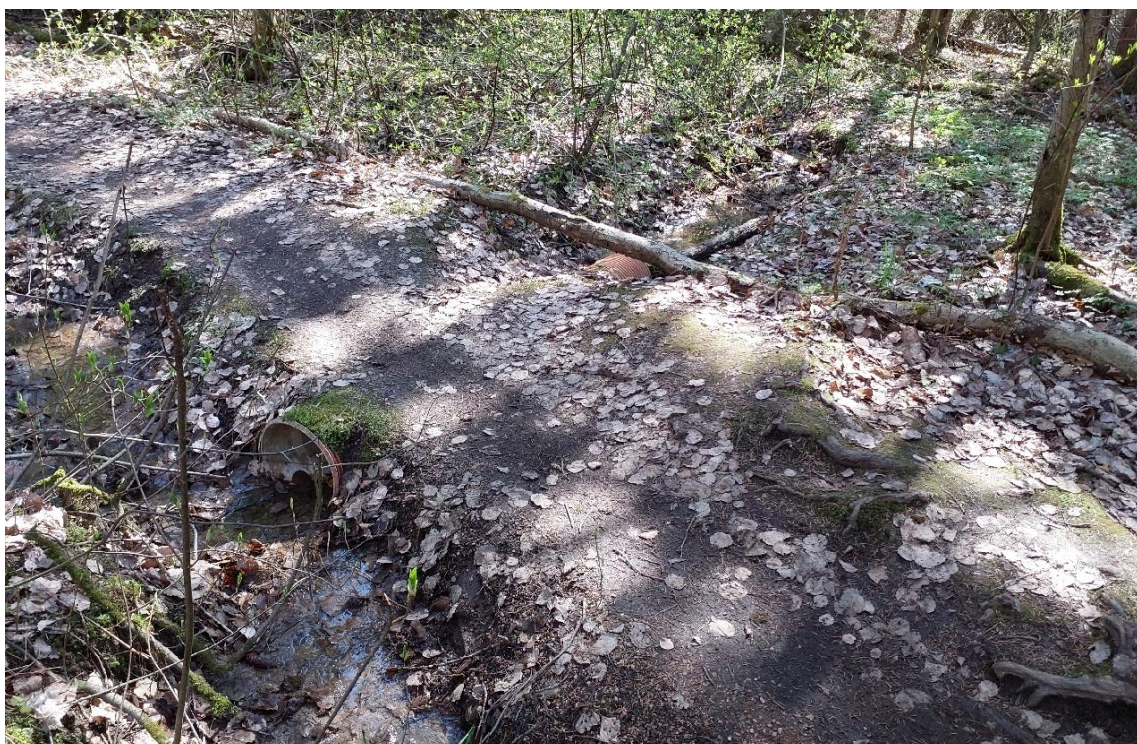
Kuva 5-7. Valuma-alue 1:n eteläisempi noro alittaa yhden polun muoviputkessa.
