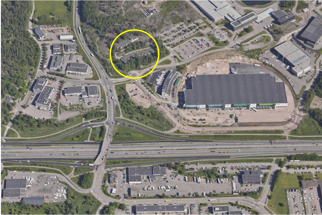
Viistoilmakuva v. 2022 etelästä pohjoiseen Kehä III:n ja Katriinantien eritasoliittymän alueelta (kaavamuutosalue osoitettu ympyrällä)
