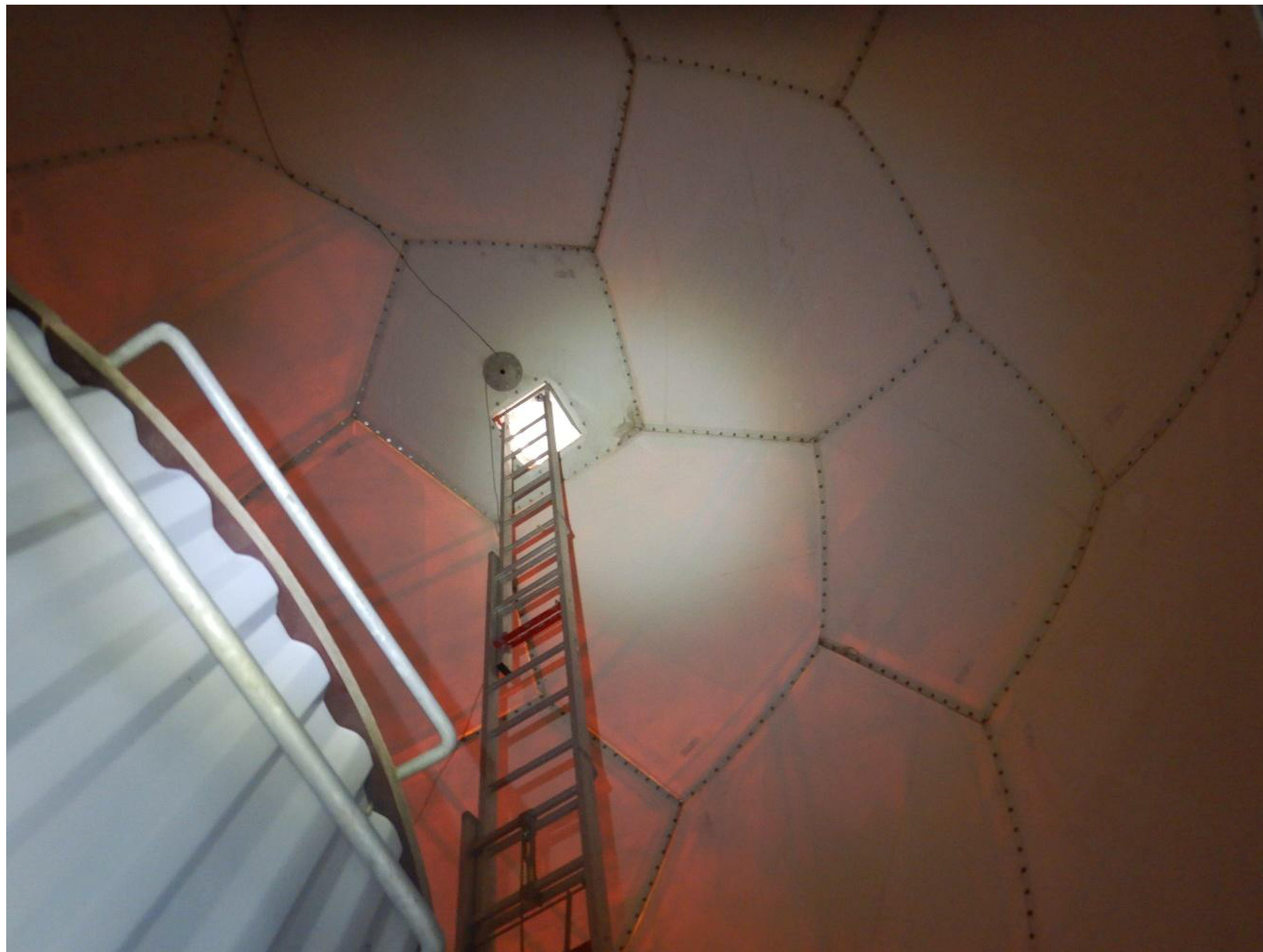
Kuva 12. Sääaseman kupolirakenne sisäpuolelta
