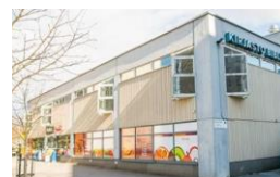
6. Pallastunturintien Liikekiinteistö Oy 1977
