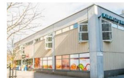
6. Pallastunturintien Liikekiinteistö Oy 1977
