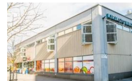
6. Pallastunturintien Liikekiinteistö Oy 1977
